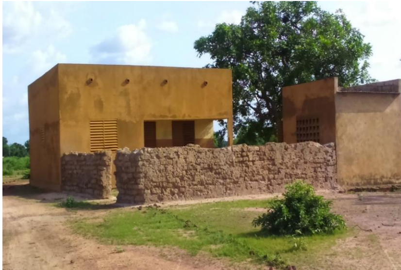
Photo 65 : Logement pour instituteur à Loaga (Poa) construit en 2007, (Source : Willy MOUNDEMBA, 1er août 2016)
