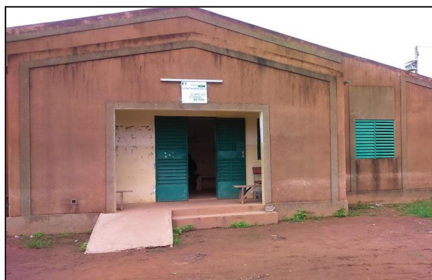
Photo 81 : Bâtiment principal du C.S.P.S. de Poa à Poa-Centre, financé par le gouvernement burkinabé, construite en 2009. (Source : Willy MOUNDEMBA, 12 août 2016)
