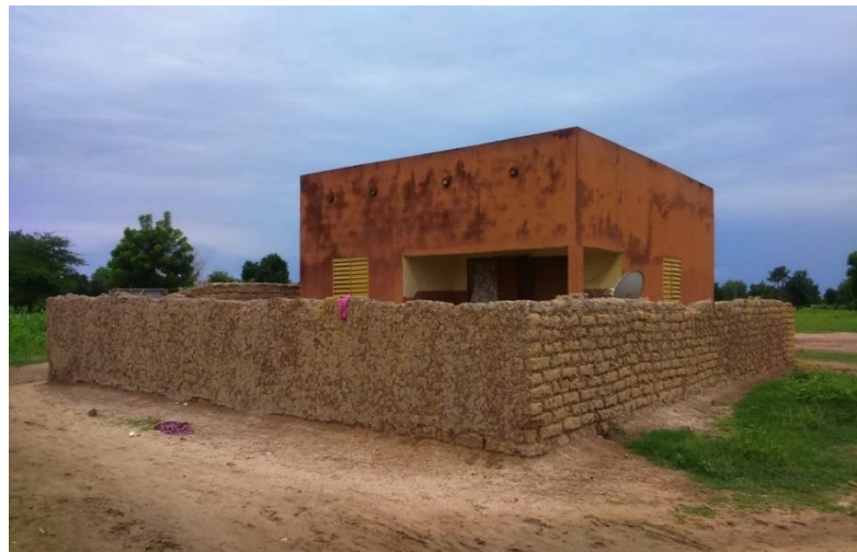
Photo 59 : Logement du vétérinaire chargé du suivi des animaux de la ferme. (Source : Willy MOUNDEMBA, le 12 août 2016 à Poa)
