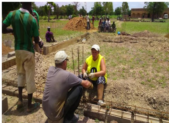
Photo 106 : La mise en place des fondations 958
