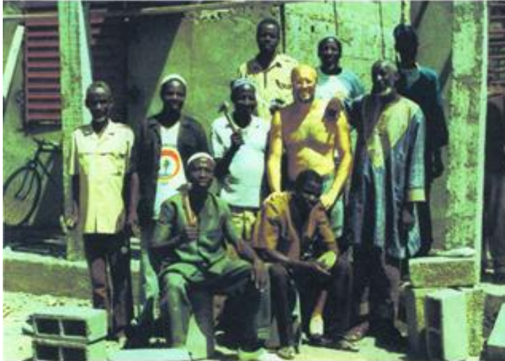
Photo 56 : René REINERT et des maçons burkinabè devant un bâtiment. (Source : René REINERT & Frédéric MOYE, Rapport de chantier août 1997, Construction d'une école à Mougounsi.)
