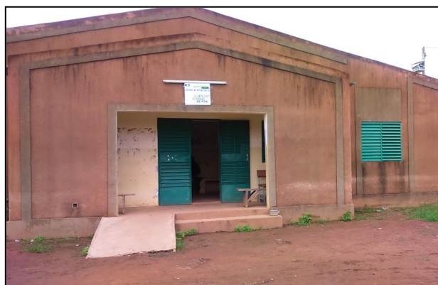
Photo 81 : Bâtiment principal du C.S.P.S. de Poa à Poa-Centre, financé par le gouvernement burkinabé, construite en 2009. (Source : Willy MOUNDEMBA, 12 août 2016)
