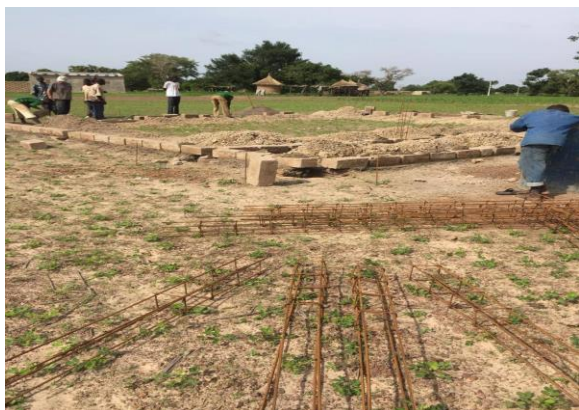
Photo 105 : Le chantier, les premiers jours 957
