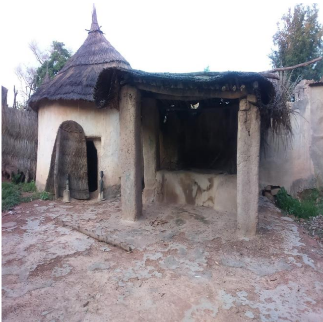
Photo 78 : La case des fétiches où sont entreposés les fétiches et les objets sacrés de la chefferie (vue de l'extérieur de la cour) jouxtant la place des audiences publiques dans la cour de Naaba. SILGA. La juxtaposition de ces deux espaces montre la corrélation qui existe entre le spirituel et le naturel, entre le pouvoir politique et le pouvoir spirituel. Le chef est non seulement le garant du pouvoir temporel, mais aussi du pouvoir spirituel. (Source : Willy MOUNDEMBA, 1 août 2016)
