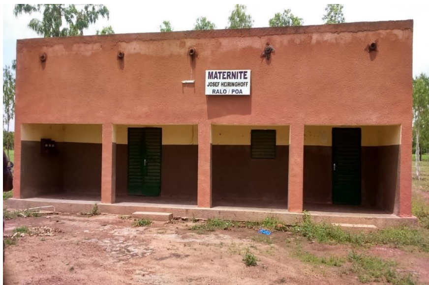
Photo 64 : La maternité de Ralo ou maternité Josef HEIRINGHOFF, construite en 1984 et réhabilitée en 2004. (Source : Willy MOUNDEMBA, 30 juillet 2016)
