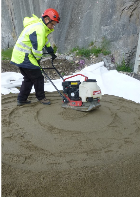
Figure 3.13 : Compactage de chaque sous-couche de sable selon le protocole choisi
