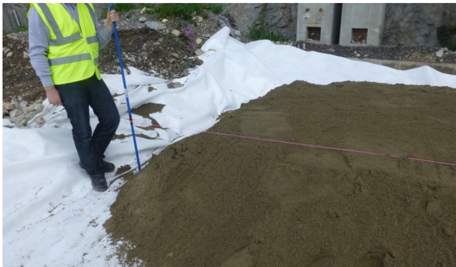
Figure 3.12 : Arasage à la cote correspondant à l'épaisseur de sous-couche avant compactage.
