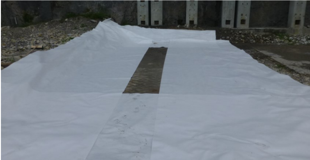
Figure 3.10 : Installation du géotextile de séparation à la surface des dalles et du site
