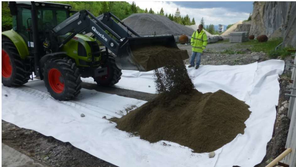
Figure 3.11 : Apport au tractopelle d'une quantité de sable correspondant à une sous-couche
