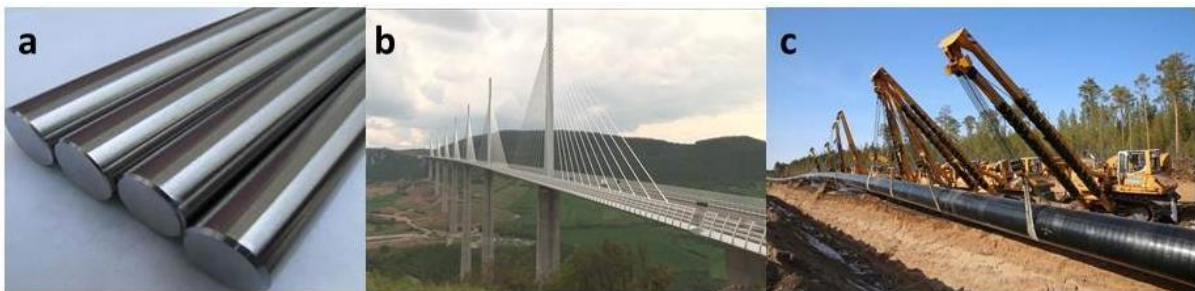
Figure I- 1 : Applications du niobium pour la fabrication des aciers. a) alliages de Nb et de Ti utilisés dans le domaine des supraconducteurs. b) viaduc de Millau en France, le pont est constitué d'acier à 0,2% en masse de Nb. c) conduites en acier à base de Nb pour le transport du pétrole.
