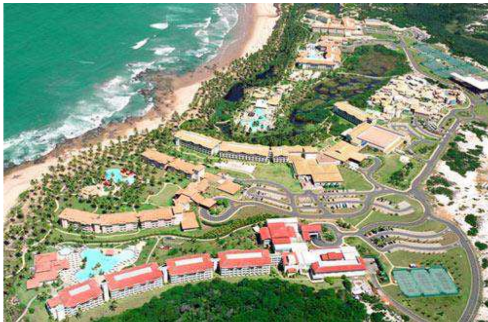
Photo 4 : Le projet « Costa do Sauípe » vu d'avion
