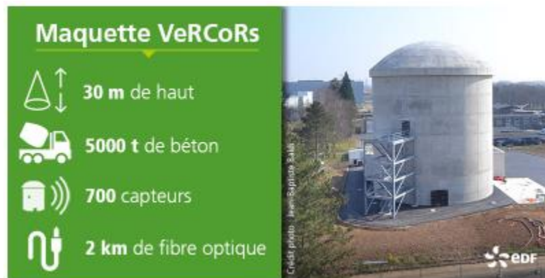
Figure 2. Vue de l'extérieure de la maquette VeRCoRs (enceinte de confinement à l'échelle 1 :3) [Projet VeRCoRs, 2015-2021]
