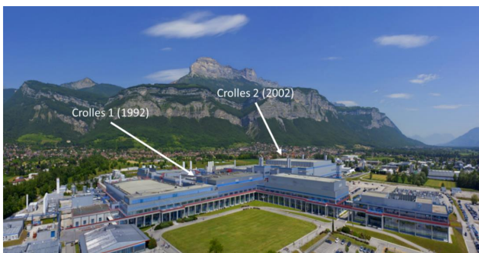
Figure 9 : Site STMicroelectronics de Crolles avec les salles blanches Crolles 1 et Crolles 2.
