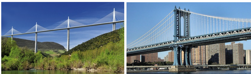
FIGURE 0.3: Exemple d'un pont à haubans : le viaduc de Millau (à gauche) [99] et d'un pont suspendu : le pont de Manhattan (à droite) [50]
