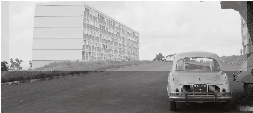
Figure 18: Immeuble les Dahlias. Jean Colbe
