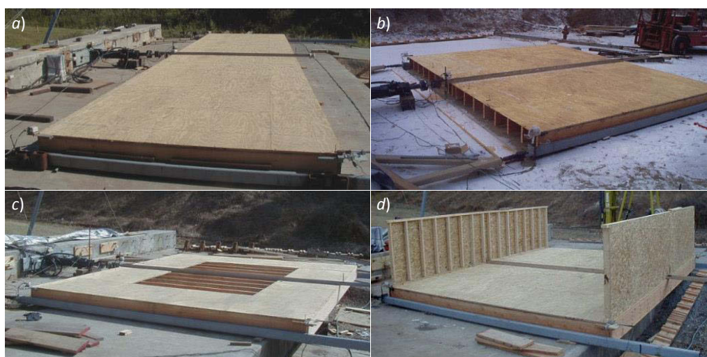
Figure I-10. Différentes configurations de planchers testés par Wescott [WES 2005]. a) Plancher diaphragme courant. b) Plancher sans poutres de chaînage. c) Plancher avec trémie au centre. d) Plancher avec murs périphériques.
