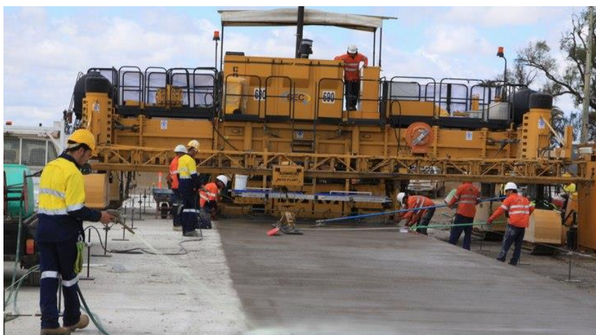
Fig. II-8. Construction des voies de circulation des avions de l'aéroport BWWA en béton géopolymère
