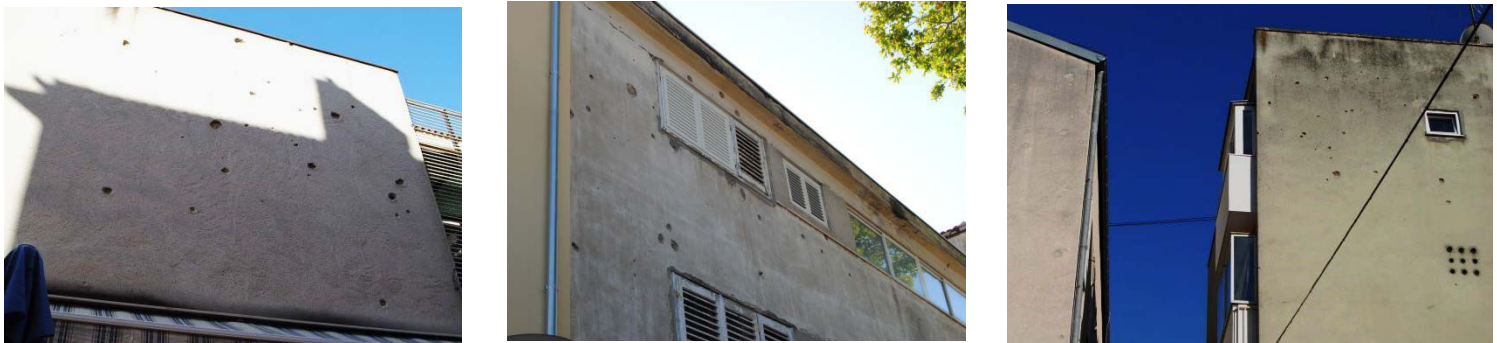
Figure 36 : Des impacts de fragments d'obus et de projectiles sur les devantures des immeubles à Zadar.
