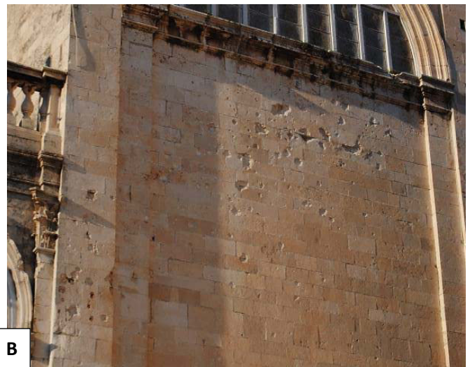
Figure 43 : Des impacts d'obus sur les devantures des bâtiments (A et B) et sur les pavés (C) du centre historique de Dubrovnik. Comme à Zadar, il s'agit là des seules traces qui subsistent après la restauration du centre historique.
