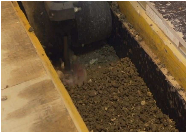
(a) Compactage d'un mur en pisé
