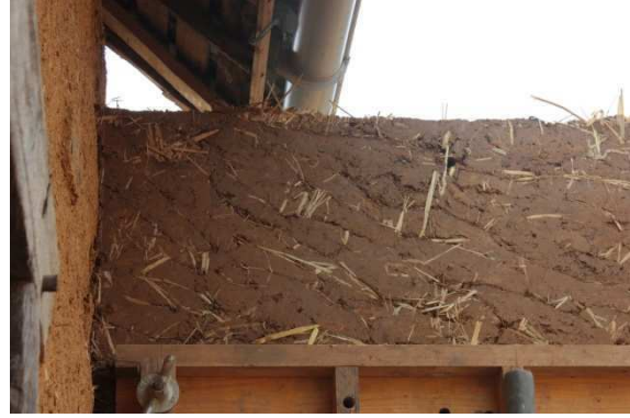
(b) Mur en bauge
