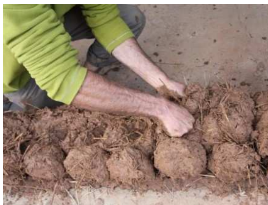
(a) Mélange terre-fibre pour la bauge
