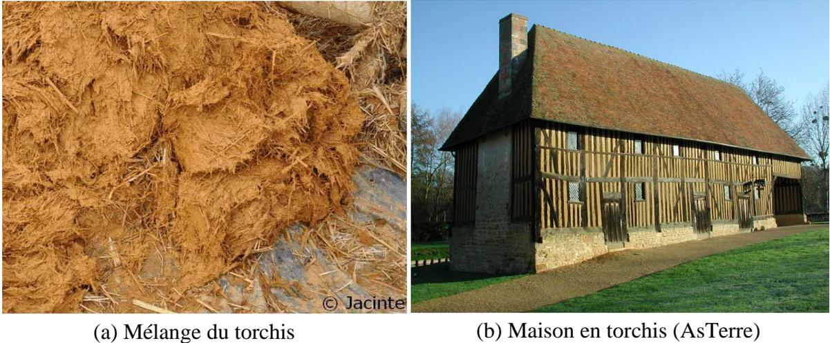
Figure I-3 : Construction en torchis (Sources Internet)
