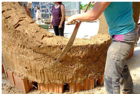
(c) Séchage et rectification du mur
