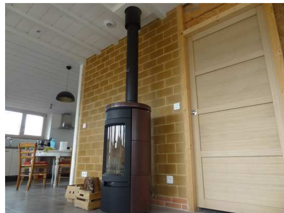
(b) Cloison en brique de terre compressée
