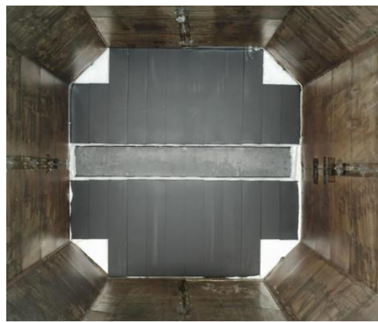
B. Récepteur céramique : Un module de SiC en test dans la cavité de la tour de la centrale THEMIS [35]
