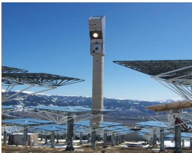
Figure 1.35 - Photographie de la centrale solaire à tour Thémis.
