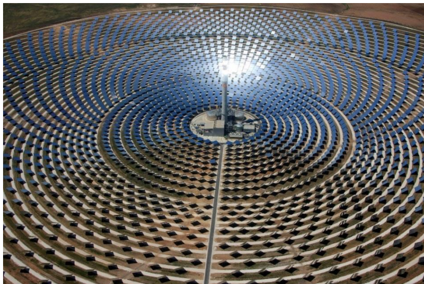
Figure 1.37 - Tour solaire à concentration "solar Tres".
