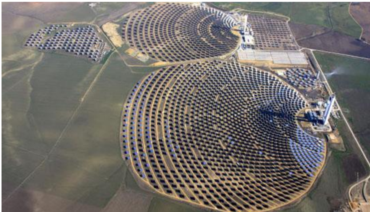
Figure 1.36 - Tours solaires à concentration PS10 (haut de l'image) et PS20 (bas de l'image) situées à Séville en Espagne [CHU12].
