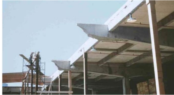
Figure 1.1 : Cas d'effondrement de structures par cisaillement : (a) Viaduc de la concorde Canada (2006) ; (b) Pile de pont après le séisme de Kobe Japon (1995) ; (c) Poutres dans les entrepôts de l'US Air Force USA (1955).
