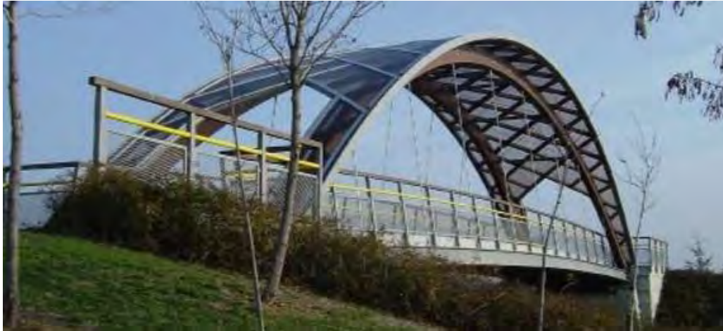
Figure 13 : Passerelle Pinot (d'après CEREMA 2008)
