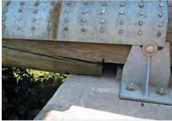
Figure 24 : Rupture du bois sous sollicitation de traction transversale (d'après Aubagnac et al. 2008)
