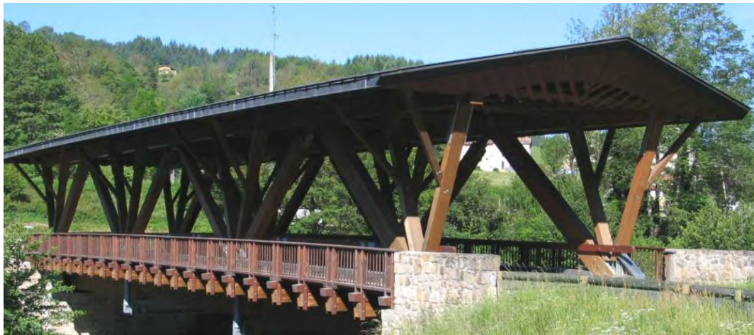
Figure 14 : Pont sur la Dore (d'après CEREMA 2008)
