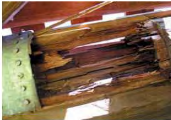
Figure 25 : Arrachement des fibres de bois sous sollicitation de traction longitudinale (d'après Aubagnac et al. 2008)
