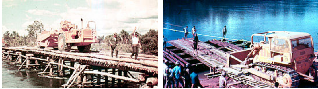
Figure 15 : Construction de la route BR 163 Cuiabá-Santarém. Source : http://www.rotadooeste.com.br/pt-br/rodovia/historia-da-rodovia
