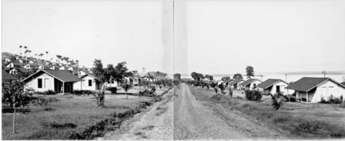
Figure 12 : Cité ouvrière de Fordlândia, au bord du Tapajós, construite par la Compagnie Ford Industrial au Brésil (années 1930) Source : site www.fordlandia.com
