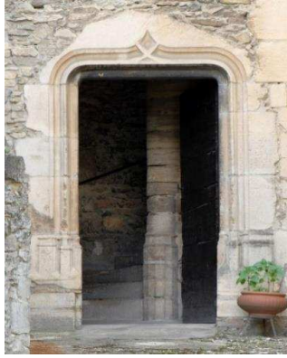
Figure 19 La porte de la maison forte Gramond
