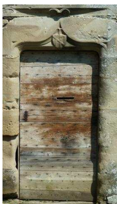
Figure 13 La porte de la maison forte Peythieu
