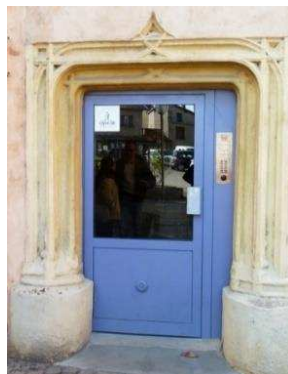
Figure 23 La porte de la maison forte Verpillière
