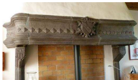
Figure 58 Cheminée adossée, maison forte de Tournelle
