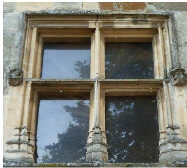
Figure 38 La fenêtre du château Demptézieu
