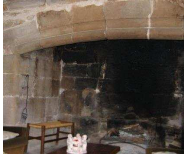
Figure 56 Cheminée incorporée, maison forte Saleton
