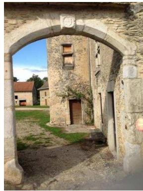
Figure 11 La porte de la maison forte Ferme des Dames
