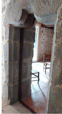
Figure 14 La porte de la maison forte de la Crosse
