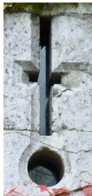
Figure 53 L'archère-canonnière de la maison forte du Carre
