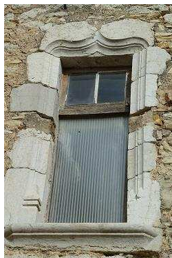
Figure 40 La fenêtre de la maison forte du Carroz
