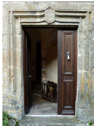
Figure 17 La porte de la maison forte Biol
