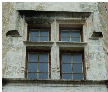
Figure 35 La fenêtre de la maison forte Larnage
