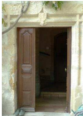
Figure 24 La porte de la maison forte Robinière
