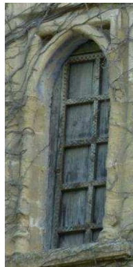
Figure 29 La fenêtre de la maison forte de la Tour Saint-Cierge
