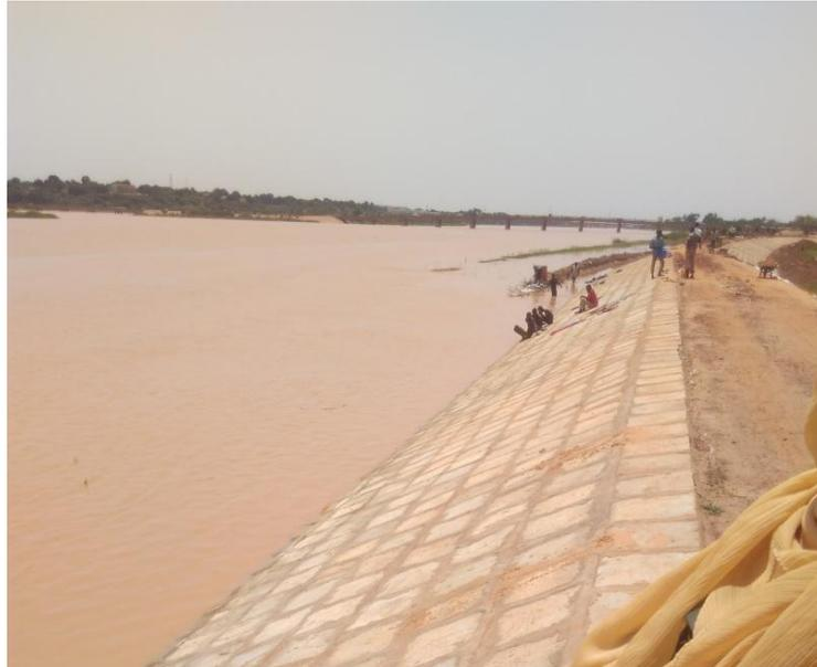
Figure 50: Rénovation de la digue de protection de la ville sur la rive droite. Cliché : Abdou Alou. A. 2017
