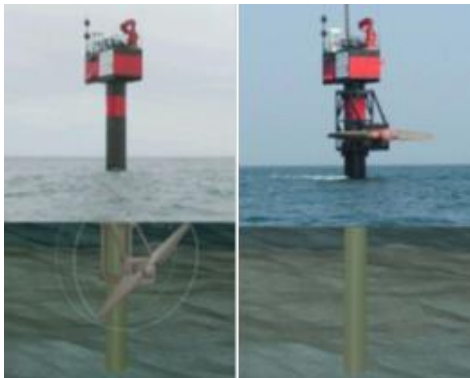
Figure 1.6 – Projet Seaflow, hydrolienne bipale à axe horizontal développée par MCT Ltd
