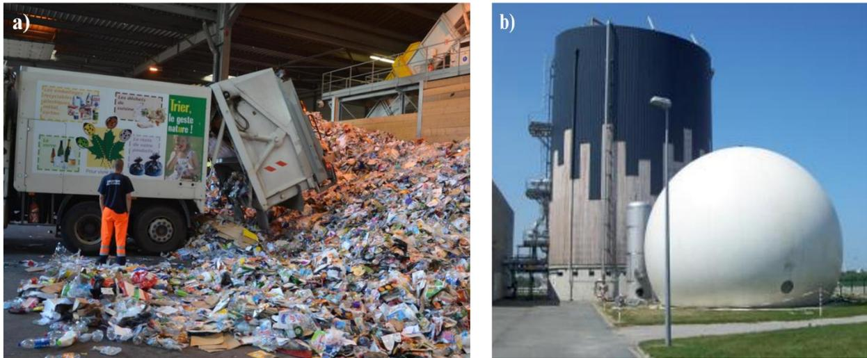
**Figure 1. 4: a) Réception des bouteilles et des flacons en plastique, b) Digesteur de méthanisation et gazomètre (le gazomètre sert à lisser l'alimentation des moteurs qui produisent de l'électricité à partir du biogaz)**
