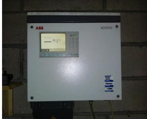
**Figure 1. 10: Analyseur fixe pour la mesure du méthane**
