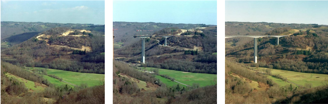
FIGURE 1.1 – Photographies extraites de l’observatoire photographique du paysage mis en place lors de la construction de l’autoroute A89.
