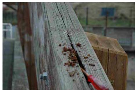
Figure 11: Pourriture en fond d'une fissure importante (Passerelle sur le Sichon à Vichy) (Doignon 2009a)
