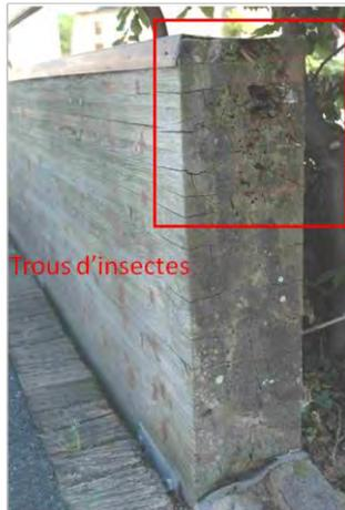
**Figure 12: Exemple de l'attaque d'insectes (Passerelle Avenue Voltaire à Thiers) (Doignon 2009b)**
