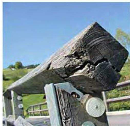
**Figure 38: Attache de la main courante sous-dimensionnée (LCPC 2008)**
