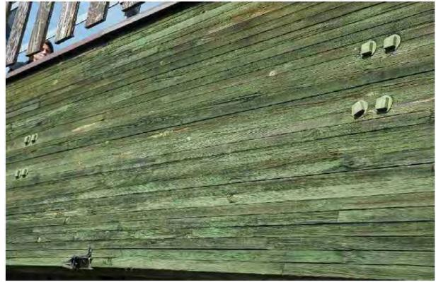
Figure 32: Délaminations et fentes sur une poutre LC (Doignon 2009c)
