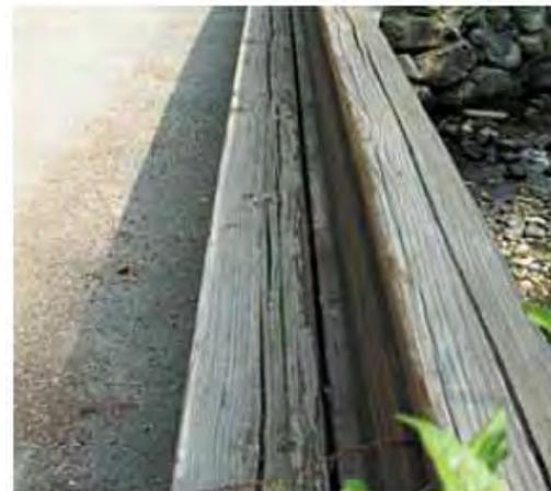
Figure 8: Fentes de retrait sur les lisses d'un garde-corps, créant ainsi des pièges à eau (LCPC 2008)
