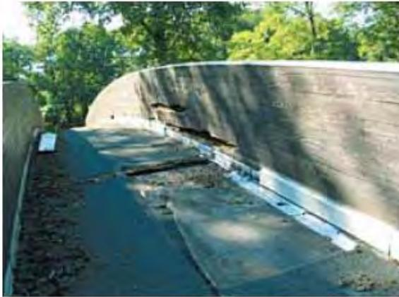
**Figure 35: Dégradation fongique sur une passerelle en LC conduisant à sa fermeture (LCPC 2008)**
