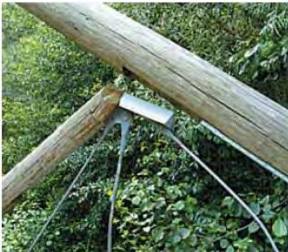
**Figure 37: Rupture d'un assemblage (LCPC 2008)**
