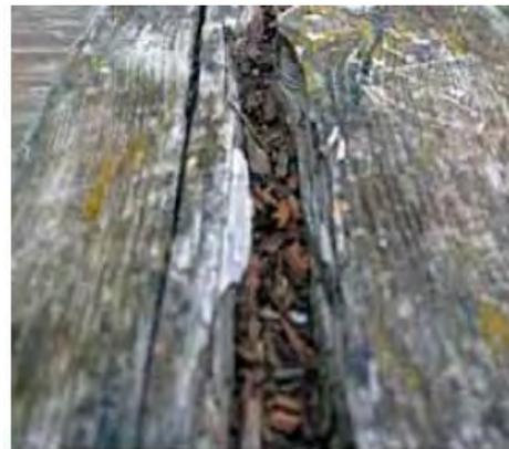
Figure 34: Développement fongique sur une surface de bois avec les fentes de retrait et l'infiltration de l'eau (LCPC 2008)
