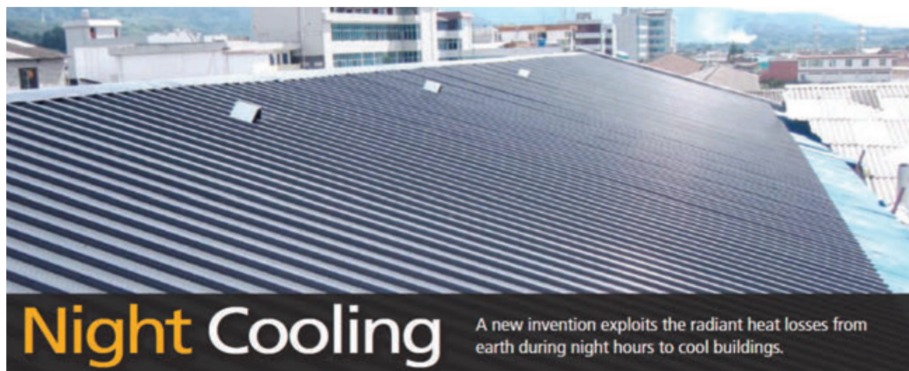
Figure 4-51 Extrait de la revue Canadian Consulting Engineer sur l'implantation de toitures Night Solar de la société Conserval Engineering. Crédit: CCE mai 2015
