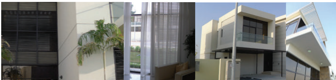
Photo 4-3 Maisons individuelles en construction par la société DAMAC à Sharjah
