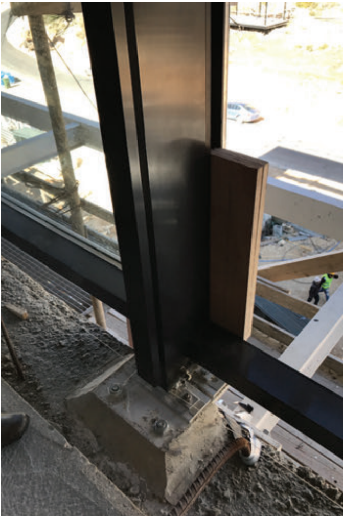
Photo 1-190 Détails du mur rideau en double vitrage et a rupture de pont thermique de la façade principale de la fondation Quattan. Crédit : FYu
