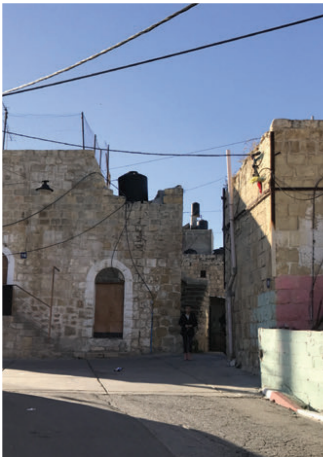
Photo 1-25 Maison dans la vieille ville avec eau chaud sanitaire sur le toit, pierre et pas de fenêtres. Crédit : FYu
