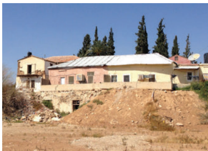
Photo 1-17 Maison classe populaire à Jéricho avec toiture en tôle acier. Crédit : FYu
