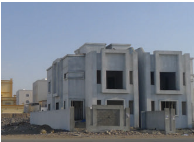
Photo 1-95 Maison en construction en périphérie de Muscat. Crédit: F. Yusta
