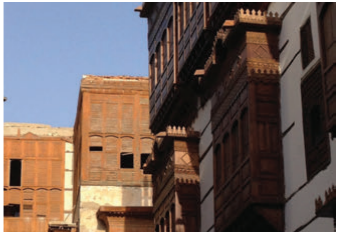
Photo 1-32 Façades avec moucharabieh pour assurer la ventilation des bâtiments. Crédit : FYu
