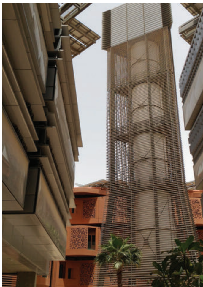
Photo 1-177 Tour rafraîchissante adiabatique par évaporation. Crédit: NF&A
