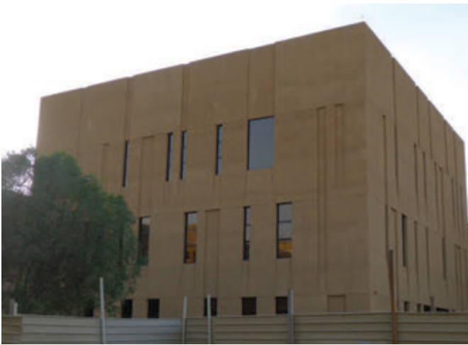
Photo 1-83 Bâtiment contemporain à Riyad. Crédit: F. Yusta
