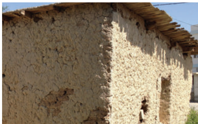
Photo 1-20 Maison vernaculaire avec murs en adobe et enduit en terre crue à Jéricho. Crédit : FYu
