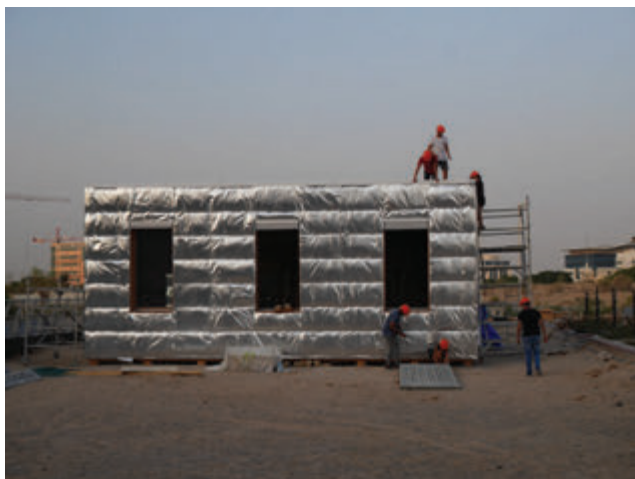
Photos A7-6 Solar Decathlon Middle East 2018 - Équipe Baitykool : Finalisation de la construction la structure bois Crédit : Equipe Baitykool
