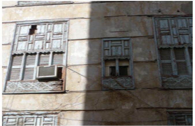
Photo 1-33 Façades avec protection en bois extérieure pour assurer la ventilation des bâtiments. Crédit : FYu
