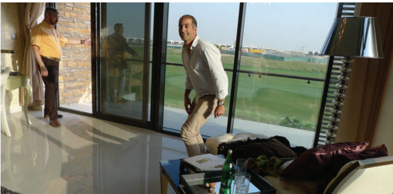
Photo 1-163 Intérieur de une maison de luxe à Sharjah sans aucune mesure de protection passive contre la chaleur. Crédit : FYu
