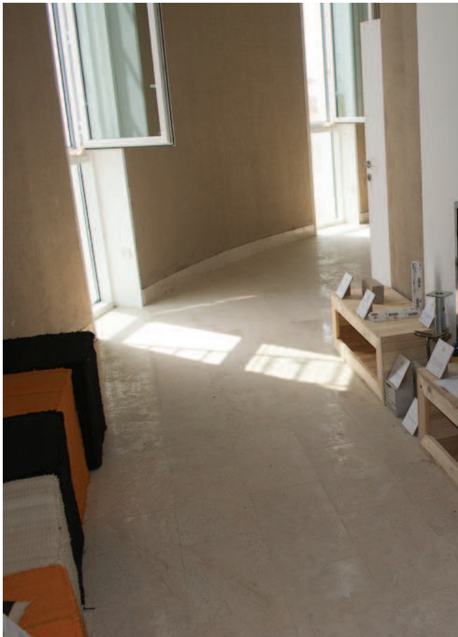
Photo 4-6 Distribution des groupes des fenêtres en partie basse et partie haute de l'espace intérieur pour faciliter la ventilation transversale par gradient thermique pendant les situations sans vent à Ecohouse GUTech, Muscat, Oman. Crédit Photo : FYusta
