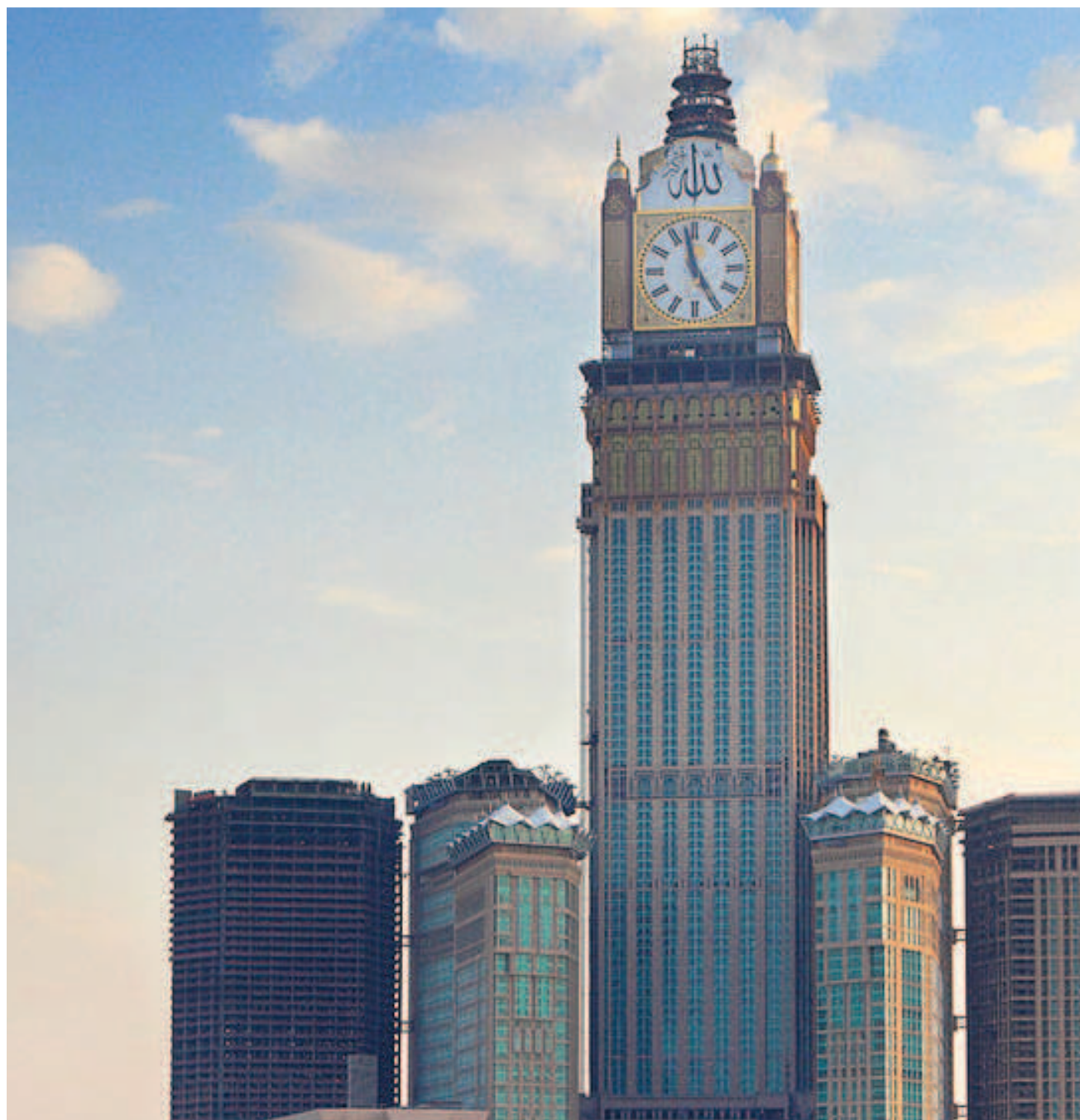
Photo 4-4 Tour d'hôtel de la Royal Clock Tower et d'autres bureaux et hôtels à La Mecque, Arabie Saoudite. Crédit : inconnu
