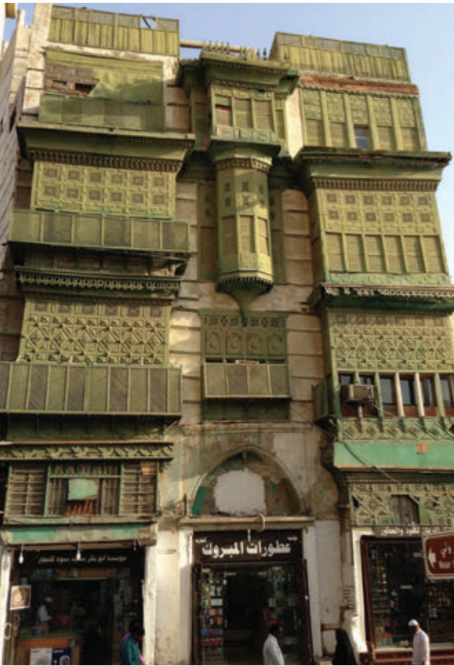
Photo 1-31 constructions en pierre de corail, des façades décorées de bois sculpté et des moucharabieh pour assurer la ventilation des bâtiments. Crédit : FYu
