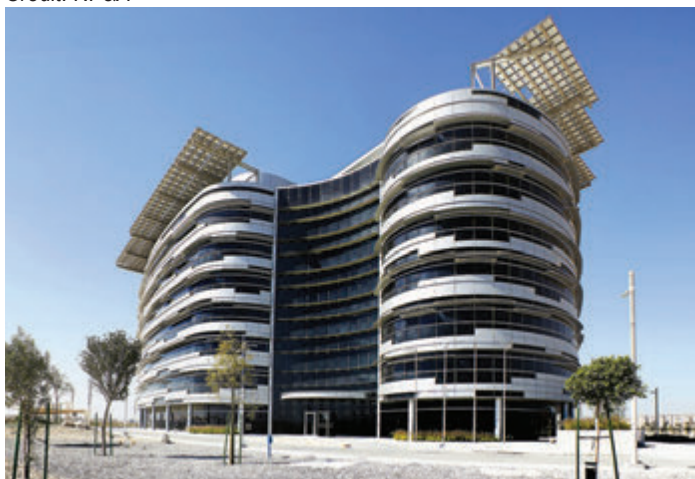
Photo 1-165 Siège IRENA - Façade principale avec des panneaux PV intégrés. Crédit: IRENA
