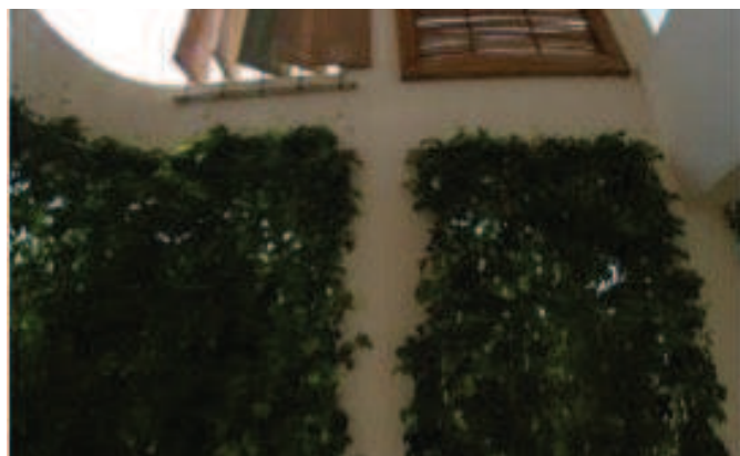
Photo 4-8 Présence végétale à proximité immédiate de l'enveloppe extérieure de la maison afin de faire descendre la température environnante, Muscat, Oman. Crédit Photo :SQU Ecohouse team
