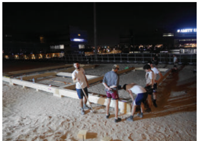
Photos A7-5- Solar Decathlon Middle East 2018 - Equipe Baitykool : Assemblage par les étudiants des fondations sur le site intermédiaire Crédit : FYu
