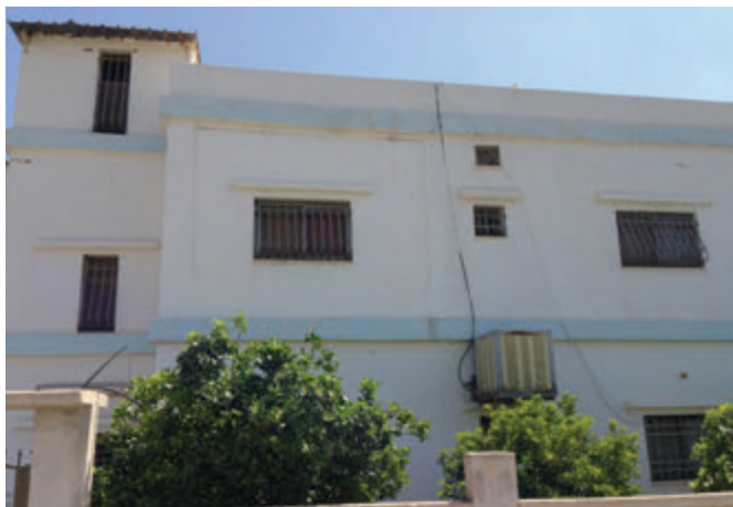
Photo 1-14 Maison traditionnelle à Jéricho avec refroidisseur adiabatique en façade. Crédit : FYu
