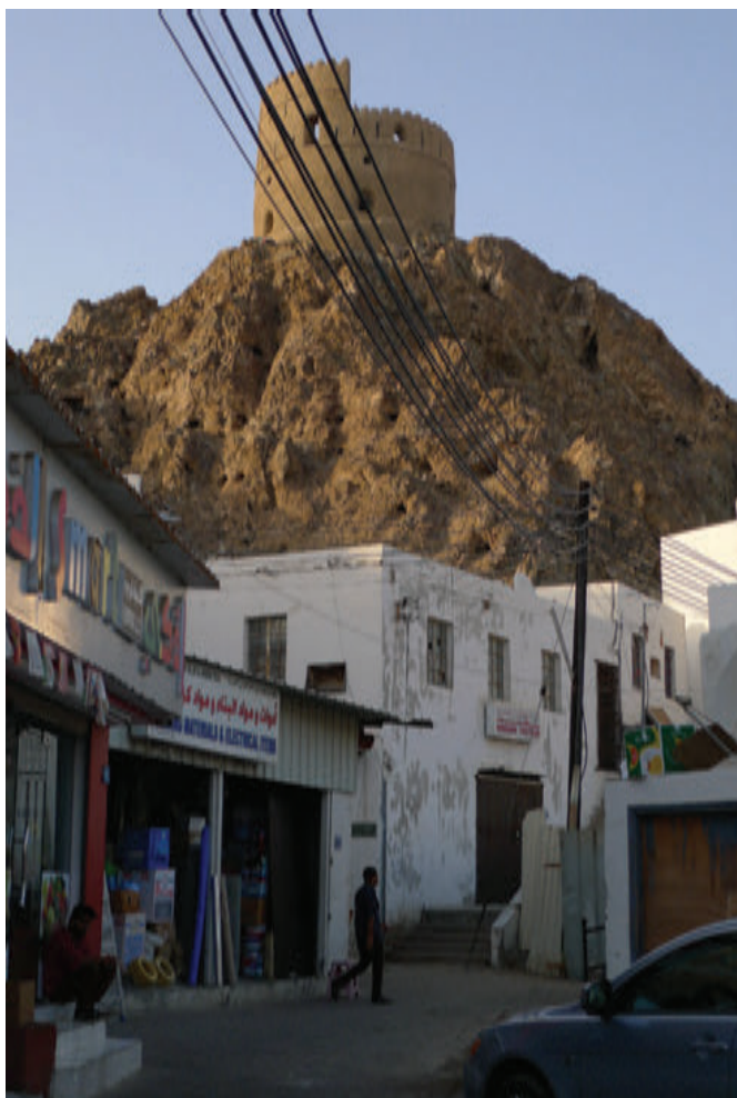
Photo 1-49 Rapport de proximité entre les constructions et les rochers environnants- Façades à grande majorité blanches. Crédit : FYu
