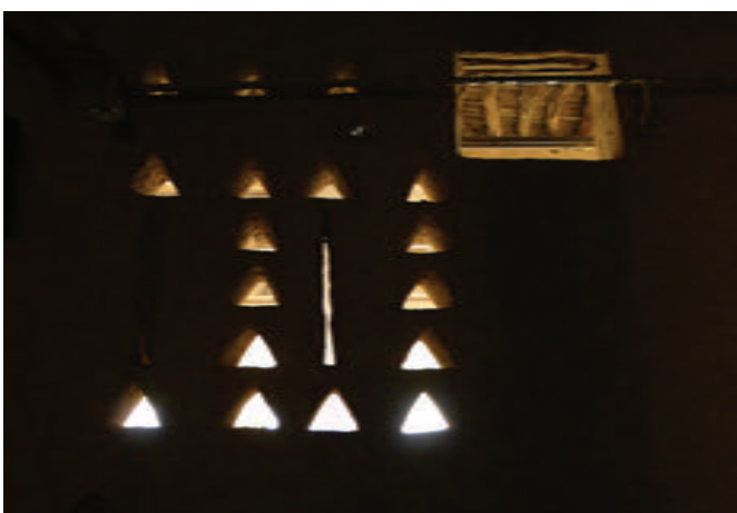
Photo 1-45 Ouvertures pour ventilation naturelle en façade du Fort Masmak, Riyad. Crédit : FYu
