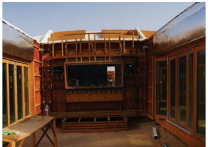
Photos A7-6 Solar Decathlon Middle East 2018 - Équipe Baitykool : Finalisation de la construction la structure bois Crédit : Equipe Baitykool
