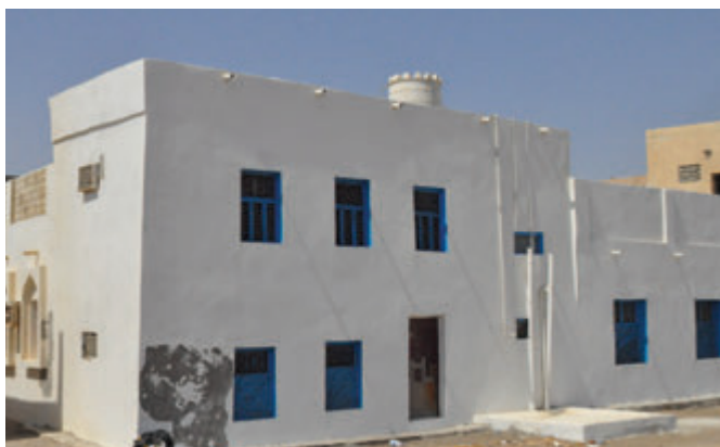
Photo 1-61 Bâtisse en front de mer avec un pourcentage d'ouvertures caractéristique des maisons à Sour. Crédit : FYu
