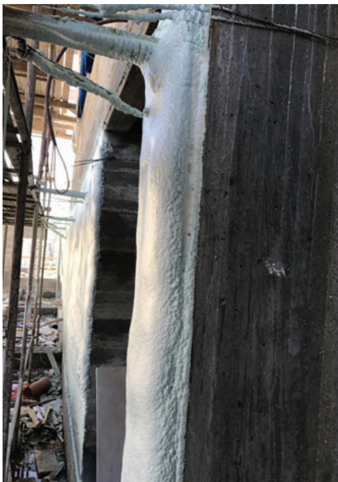
Photo 1-198 Bio-Polyurethane projeté sur les voiles. Crédit : FYu
