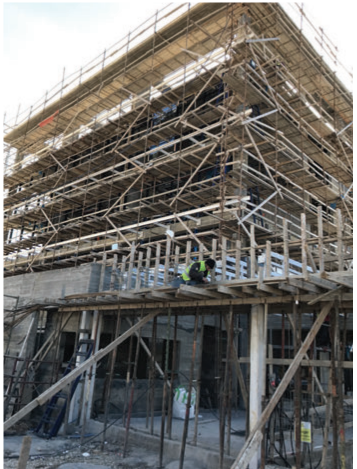
Photo 1-193 Future façade vitrée de la fondation Quattan. Crédit : FYu
