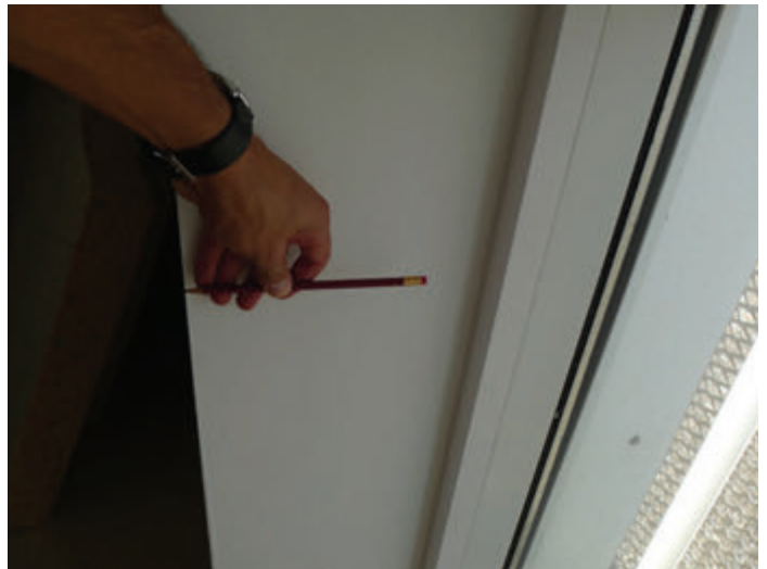
Photo 1-185 épaisseur du mur extérieur de la maison GUTECH-Ecohouse a Muscat. Crédit : FYu
