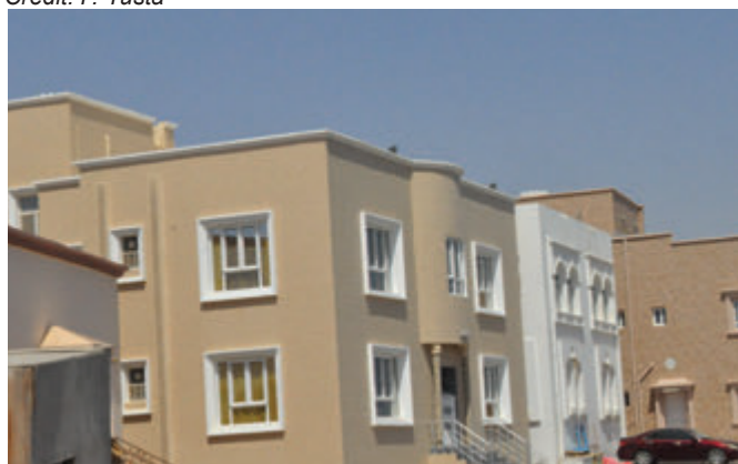
Photo 1-102 Maison récente dans quartier périphérique à Sour. Crédit: F. Yusta
