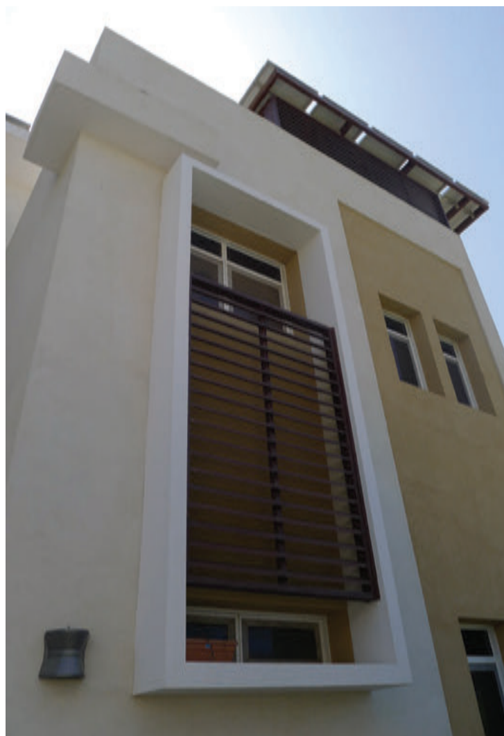
Photo 1-187 Vue extérieure des vitrages avec sans brise-soleil, et un brise-soleil sans vitrage. Maison Eco-house HTC. Crédit : FYu
