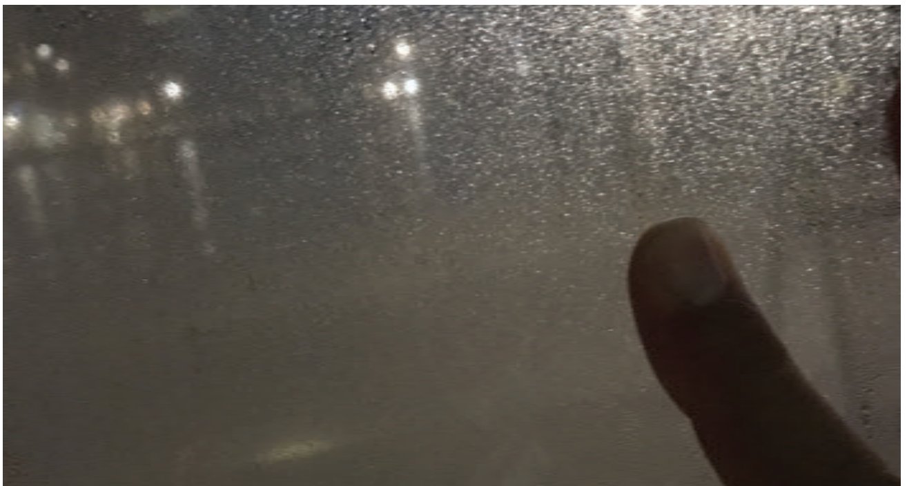
Photo 1-10 Condensation à l'extérieur d'un café climatisé à Dubaï avec des ouvertures en méthacrylate (basse isolation) dans une soirée avec une forte humidité relative. Crédit photo : FYu
