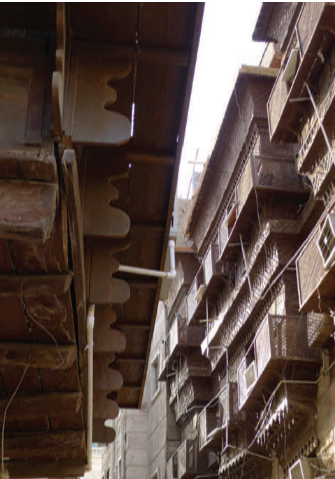
Photo 1-34 constructions en pierre de corail, des façades avec des moucharabieh pour assurer la ventilation. Crédit : FYu
