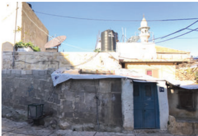
Photo 1-21 Maison dans la vieille ville de Ramallah avec eau chaud sanitaire sur le toit. Crédit : FYu
