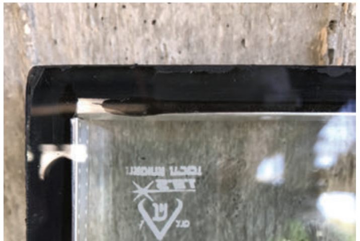
Photo 1-190 Détails du mur rideau en double vitrage et a rupture de pont thermique de la façade principale de la fondation Quattan. Crédit : FYu
