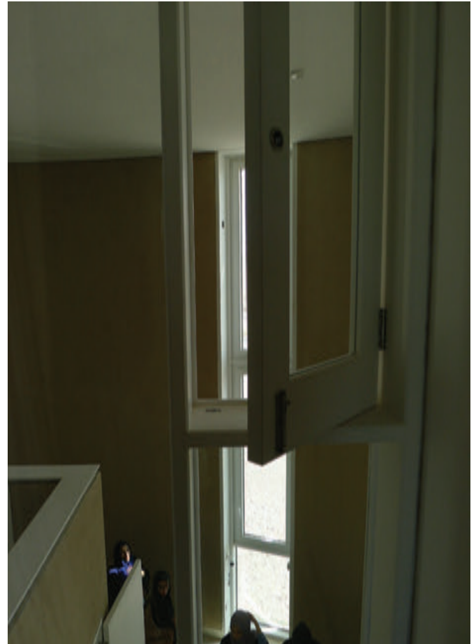
Photo 4-6 Distribution des groupes des fenêtres en partie basse et partie haute de l'espace intérieur pour faciliter la ventilation transversale par gradient thermique pendant les situations sans vent à Ecohouse GUTech, Muscat, Oman. Crédit Photo : FYusta
