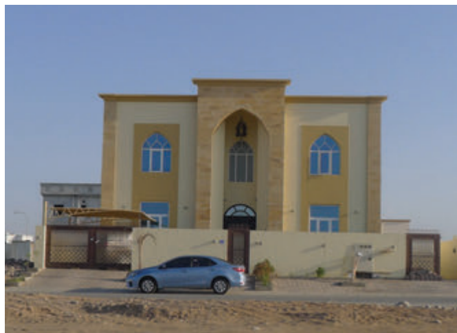
Photo 1-96 Maison en construction en périphérie de Muscat. Crédit: F. Yusta
