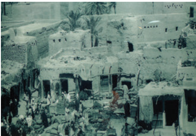
Photo 1-43 Scènes historiques de la vieille ville de Riyad. Constructions en terre crue, sans fenêtres et toiture terrasse
