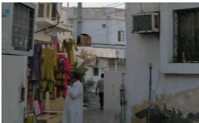
Photo 1-53 Refroidisseurs de climatisation en façade dans ruelle à Matrah. Crédit : FYu
