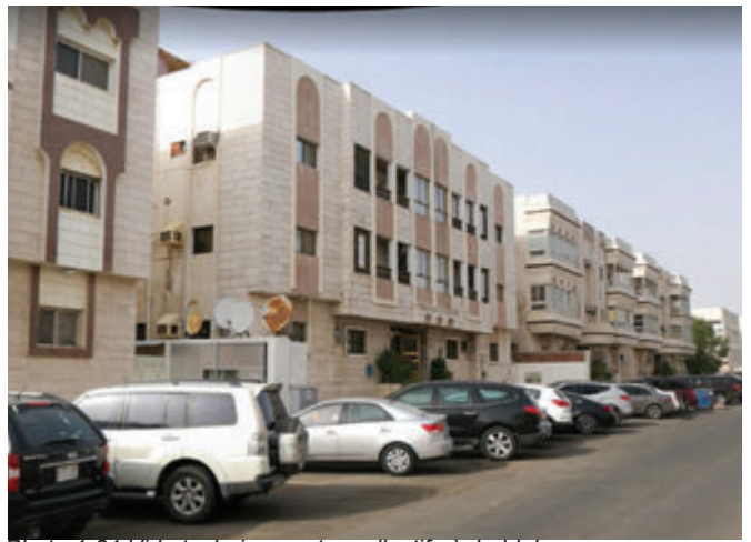
Photo 1-81 Vide technique entre collectifs à Jeddah. Crédit : FYu
