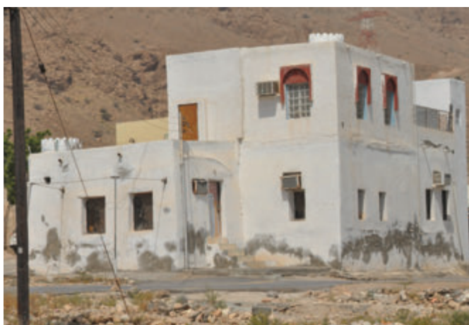
Photo 1-65 Bâtisse à Tiwi: logement et cour intégrées dans un enclos. Fenêtres du R+1 larges pour capter le vent . Crédit : FYu
