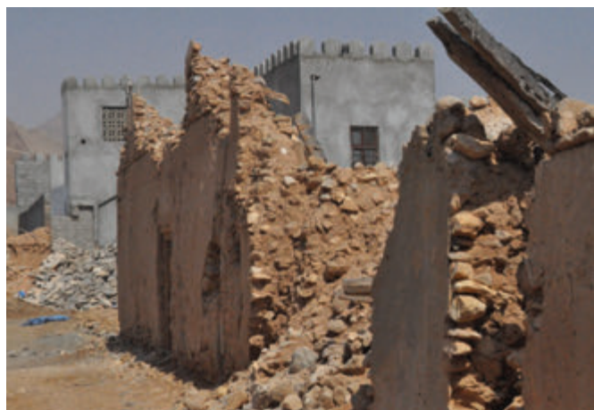
Photo 1-64 Ruine dans le bourg de Tiwi qui permettent de voir la composition du mur en pierre: pierres/terre/pierre. Crédit : FYu
