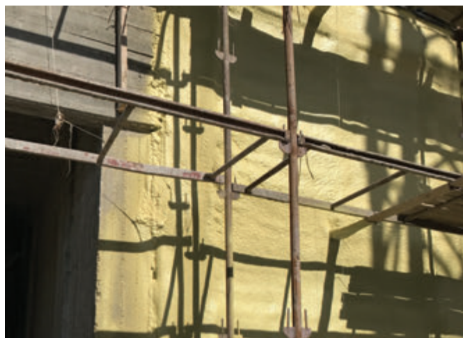
Photo 1-195 Bio-Polyurethane projeté sur les voiles en béton . Crédit : FYu
