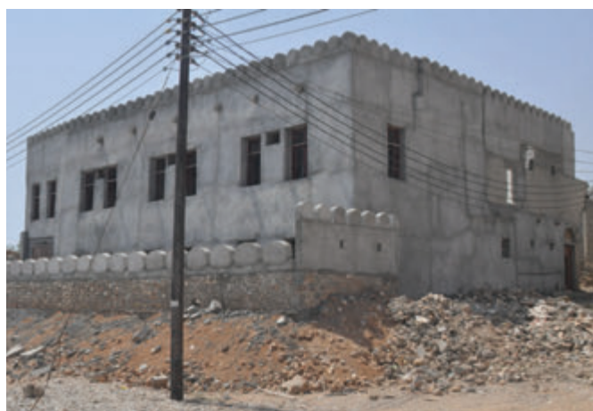
Photo 1-66 Logement de nouvelle construction a Tiwi. Crédit : FYu
