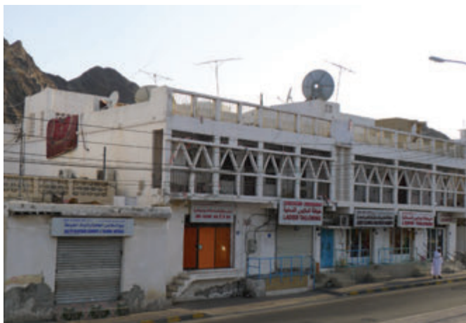
Photo 1-51 façades ouvertes avec une coursive de protection solaire et d'espace extérieur d'agrément. Crédit : FYu
