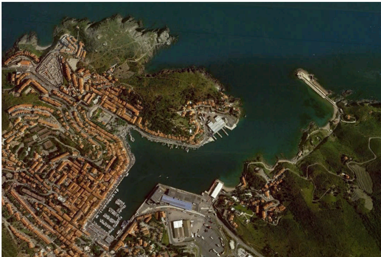
Figure 4 : Vue aérienne du port de Port-Vendres, Google earth V 7.1.2.2041 (7/10/2013), 42°31'08.66 N, 3°06'40.22 E, http://www.earth.google.com [20 Février 2018].
