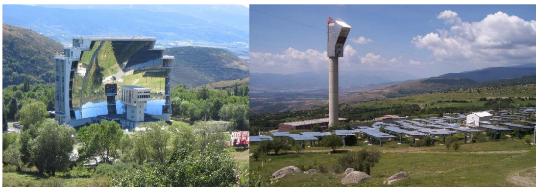
Figure 2: Four solaire d'Odeillo (à gauche) et centrale solaire Thémis (à droite)
