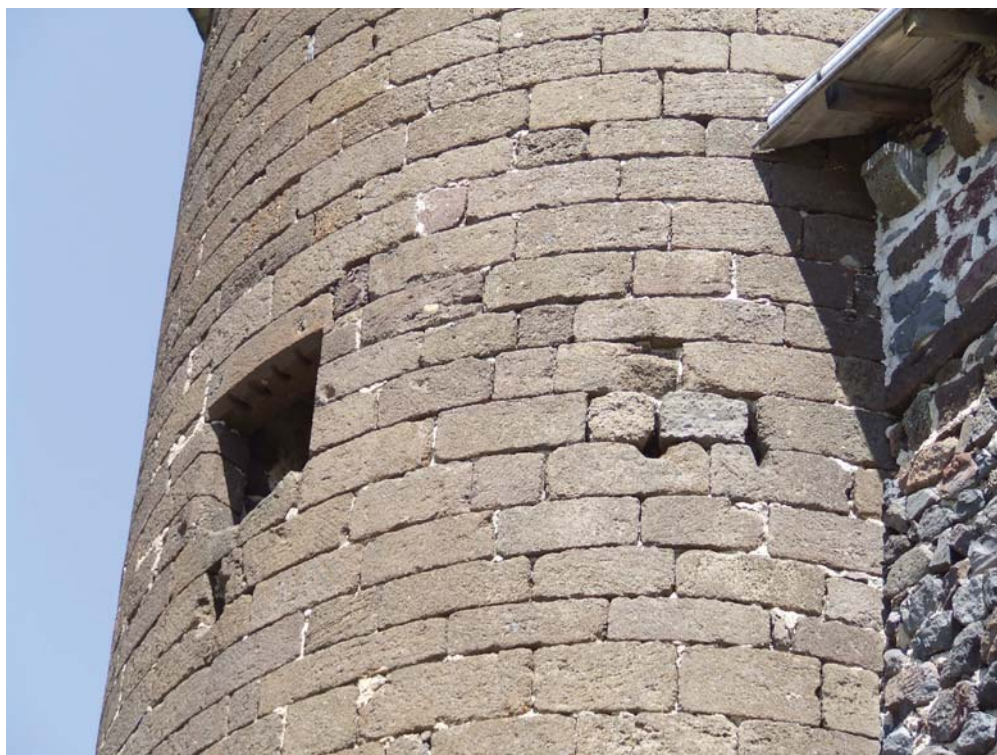
fig. 71. Détail des ouvertures pour mousquet sur la tour circulaire. Bouzols.
