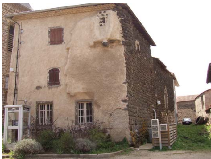
fig. 342. Maison forte ou du prieur avec échauguette. Lissac.
