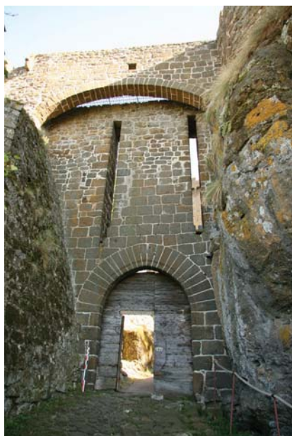
fig. 489. Porte de l'entrée nord avec encastrement des flèches du pont-levis. Castrum de Polignac.
