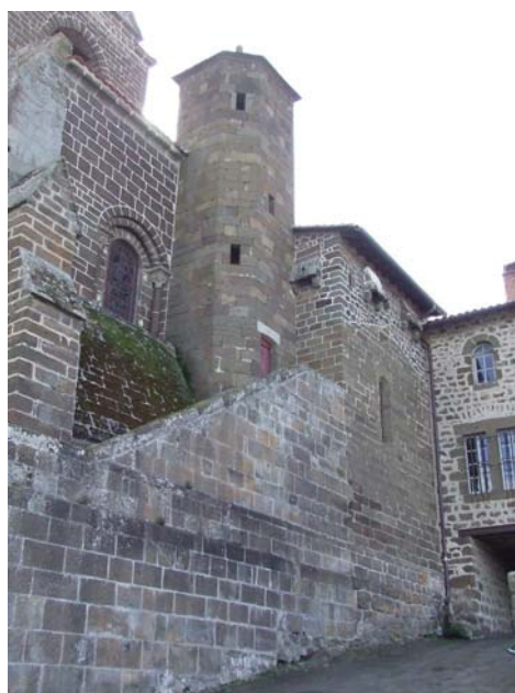
fig. 476. Vue rapprochée du bâtiment fortifié accolé au nord de l'église Saint-Martin de Polignac.
