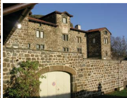
fig. 453. Maison de Cheyrac. Haut du hameau. Polignac.
