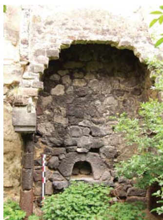
fig. 439. Cheminée ruinée du logis. Agrain. Ouïdes.
