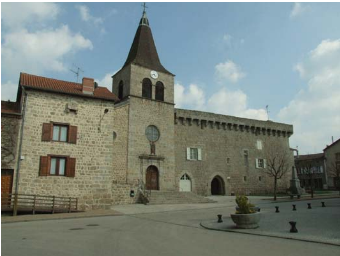
fig. 314. Vue de la courtine ouest et de l'église. Grazac.
