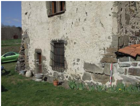
fig. 461. Vue de la porte à accolade. Rez-de-chaussée. Communac. Polignac.
