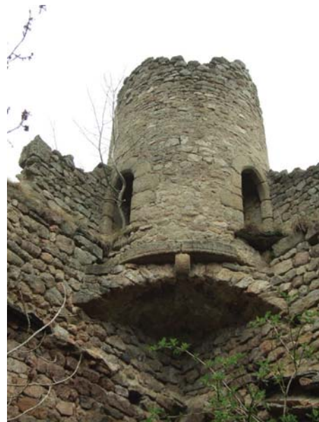
fig. 323. Échauguette en surplomb. Carry-Vertamise. Grazac.
