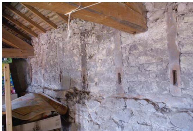
fig. 167. Détail de l'arasement de la toiture des combles. Bellevue-la-Montagne (Saint-Just-près-Chomelix).
