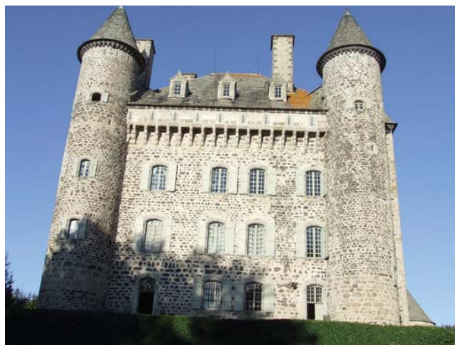
fig. 493. Face ouest et mâchicoulis sur accolade. Vachères. Présailles.
