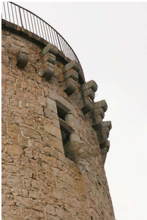
fig. 283. Détail des consoles de mâchicoulis. La Tour dite de Joyeuse. Dunières.
