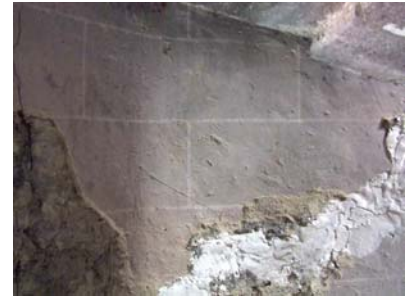
fig. 460. Détail du faux-joint blanc. Communac. Polignac.
