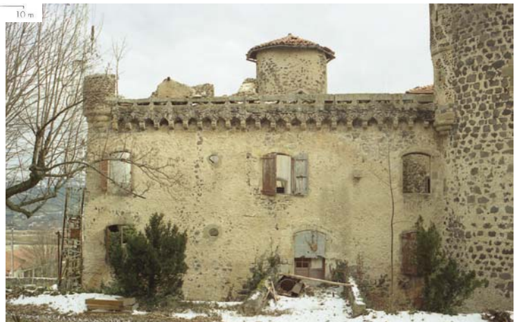
fig. 502. Vue de l'entrée de la courtine nord sur fossés. Mons. Puy-en-Velay.
