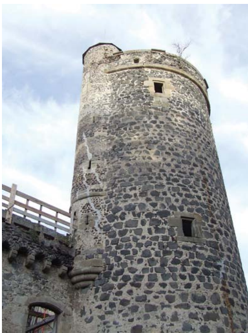
fig. 507. Vue de l'escalier en demi-hors-œuvre. Mons. Puy-en-Velay.
