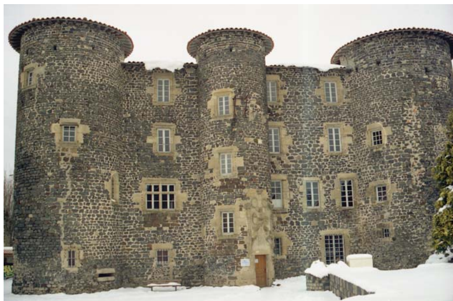
fig. 388. Façade sud du logis abbatial. Le Monastier-sur-Gazeille.
