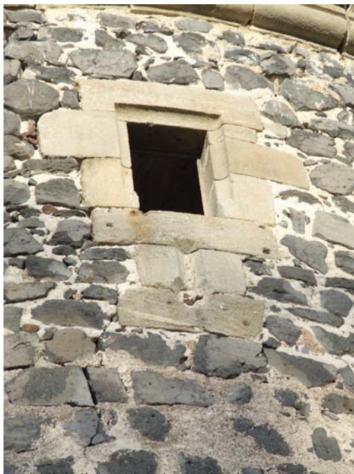
fig. 511. Détail de l'ouverture depuis l'extérieur du niveau 5. Mons. Puy-en-Velay.
