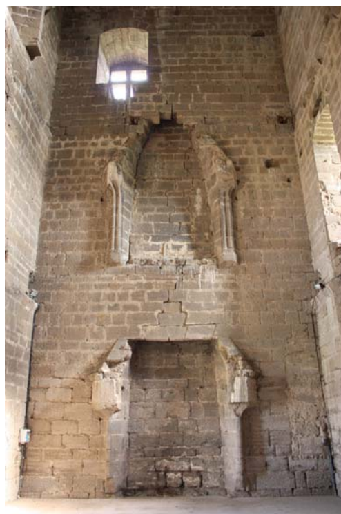
fig. 488. Cheminées de la tour. Castrum de Polignac.
