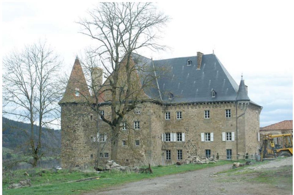
fig. 50. Vue générale de la maison forte de la Beaume. Alleyras.
