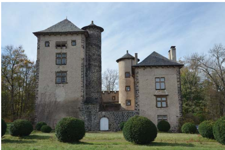
fig. 447. Vue générale de l'édifice. Bornette. Polignac. (cliché L. Gouteyron).
