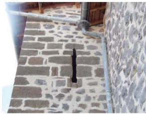
fig. 353. Détail de l'arbalétrière située en face nord à l'étage de cette porte. Le Charrouil. Loudes.
