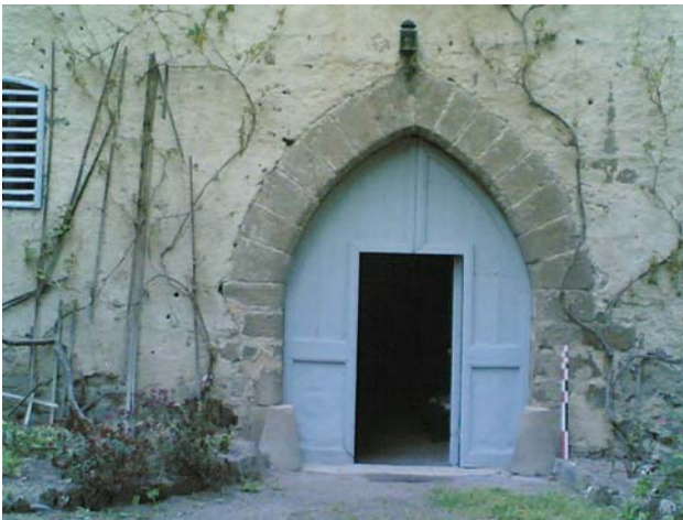
fig. 466. Détail porte avec arc brisé. Face Sud. Cussac. Polignac.
