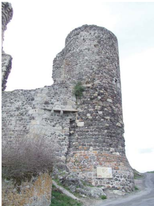
fig. 25. Tour sud-est à embase tronconique et glacis. Allègre.
