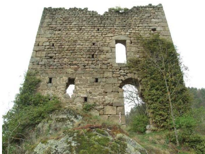
fig. 328. Vue du pan de mur côté vallée avec linteau en bâtière. Chabrespine-Saint-Martial. Grazac.
