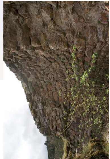
détail du parement intérieur
