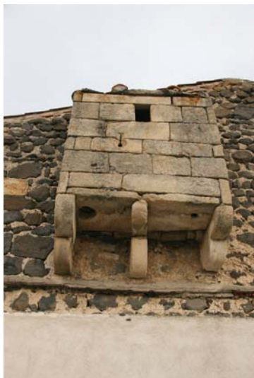
fig. 195. Détail de la bretèche-latrines. Farnier. Brives-Charensac.
