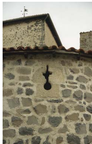
fig. 260. Détail d'une archère-canonnière à croix de visée sur la tour d'enceinte extérieure. La Tour Daniel. Coubon.
