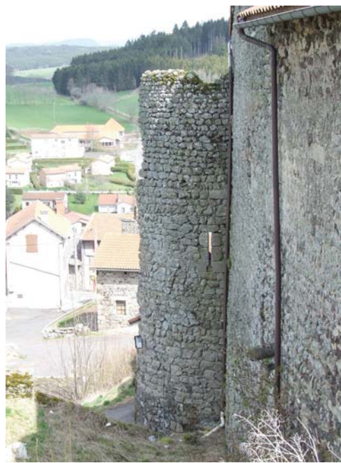
fig. 26. Tour nord-est à archères-canonnières, enceinte haute. Allègre.
