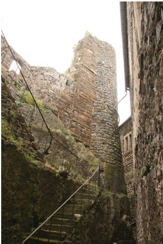
fig. 63. Vue de la façade ouest depuis le fossé creusé dans la roche. Bouzols.
