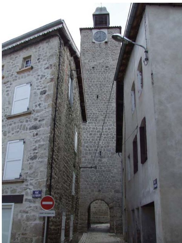
fig. 269. Vue de la tour-porte, ouverture vers la ville. Craponne.
