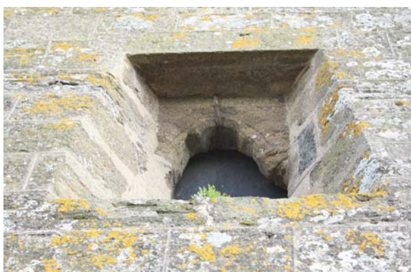
fig. 487. Baie trilobée antérieure au glacis de la tour. Castrum de Polignac.
