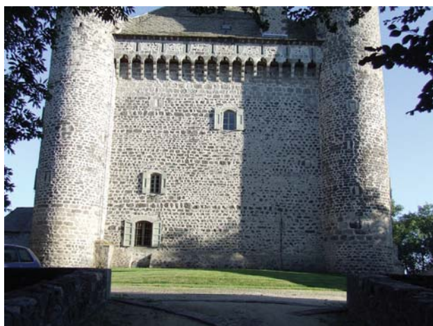
fig. 494. Face nord et mâchicoulis trilobés. Vachères. Présailles.
