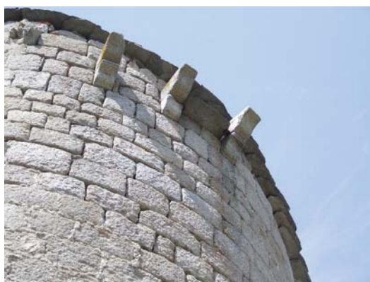
fig. 227. Détail des corbeaux. Pont-de-Mars. Chambon-sur-Lignon.
