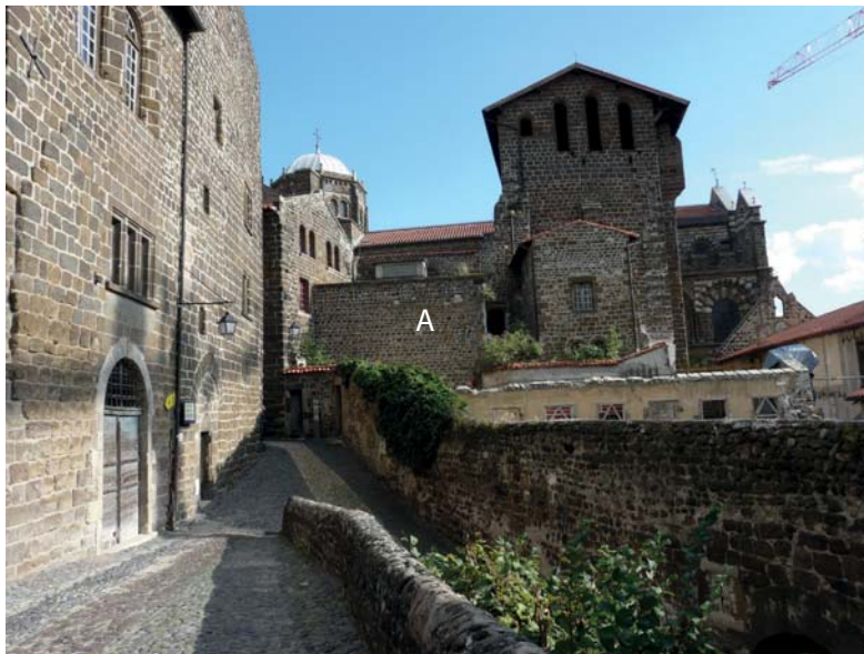
Vue des niveaux inférieurs arasés de la tour (A)
