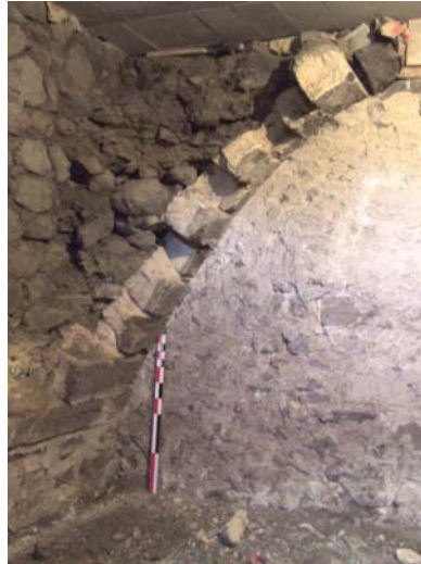
fig. 459. Voûtement en berceau du rez-de-chaussée. Communac. Polignac.
