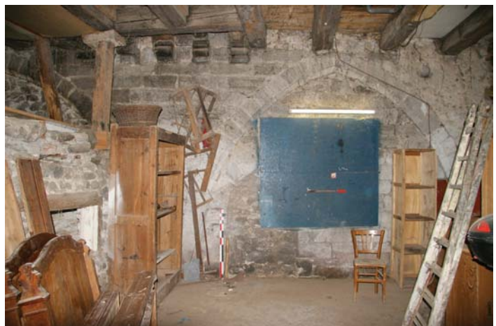
fig. 6. Grandes arcades en rez-de-chaussée. Mur ouest. Aiguilhe
