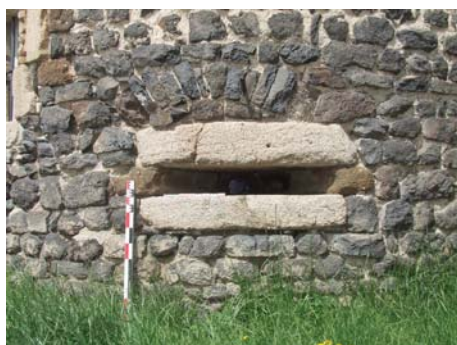
fig. 391. Exemple d'une canonnière à la française. Le Monastier-sur-Gazeille.
