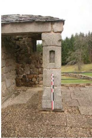
fig. 371. Pilier en réemploi du Panelier. Mazet-Saint-Voy.
