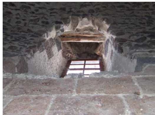
fig. 339. Baie en plein-cintre agrandie. Lissac.
