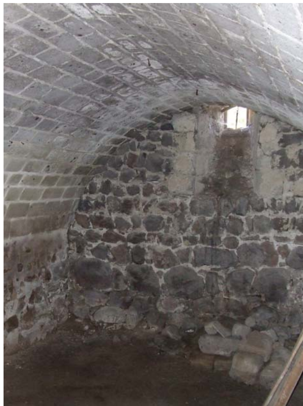
fig. 127. Vue du niveau de cave voûtée de la tour. Adiac.
