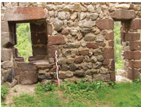
fig. 436. Fenêtre à coussiège du niveau 2 de la tour. Agrain. Ouïdes.
