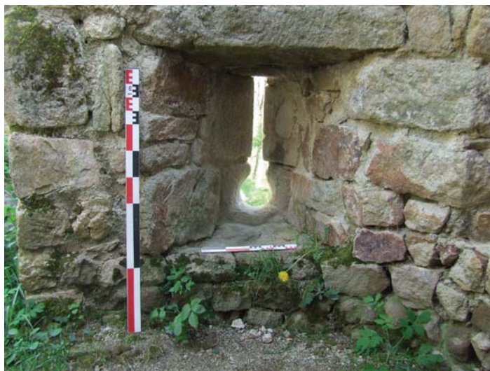
fig. 119. Vue de l'ébrasement interne. Rochebaron.
