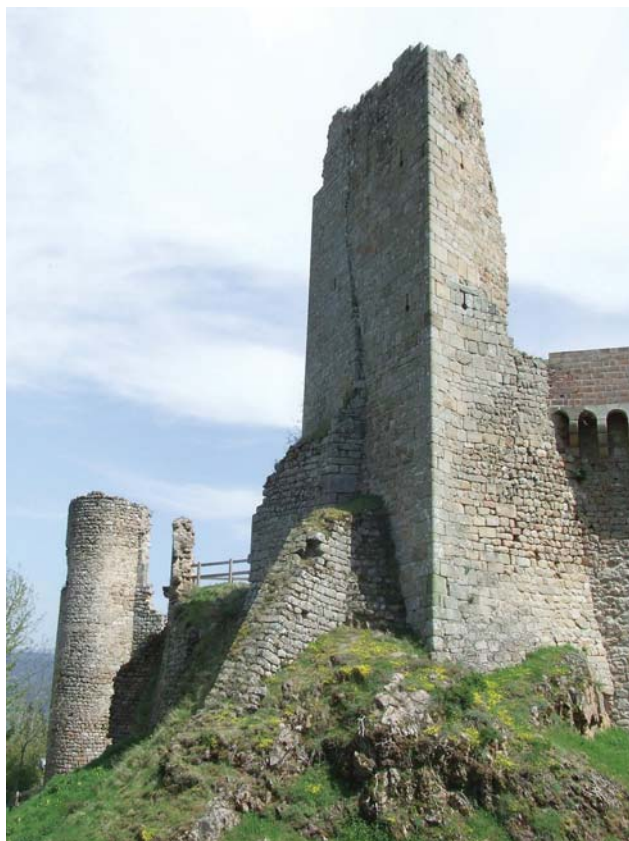
fig. 123. Vue de la tour quadrangulaire remaniée (tour 1) depuis l'ouest. Rochebaron.
