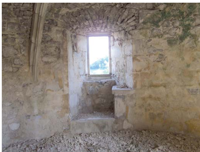
fig. 510. Détail de la fenêtre à coussin de niveau 5. Détail de la voûte d'ogive. Mons. Puy-en-Velay.
