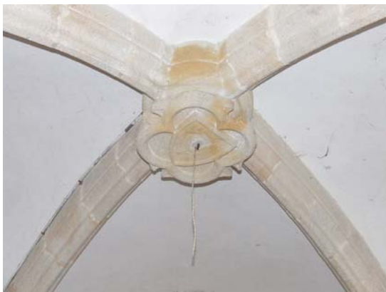
fig. 505. Détail de la voûte d'ogive du niveau 1. Mons. Puy-en-Velay.
