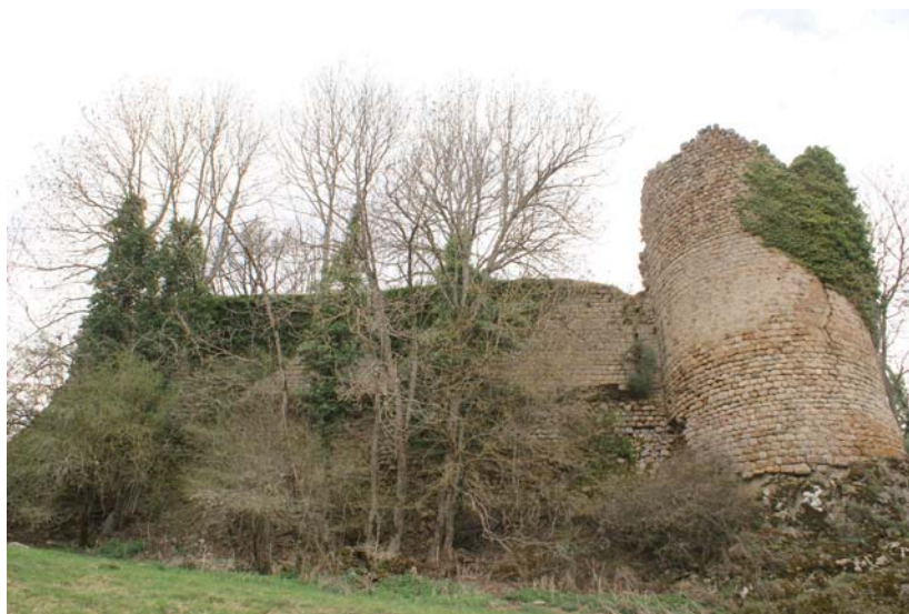
fig. 250. Vue du flanc est avec la tour circulaire. Arzon. Chomelix.
