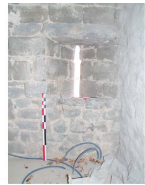
fig. 353. Détail de l'arbalétrière située en face nord à l'étage de cette porte. Le Charrouil. Loudes.
