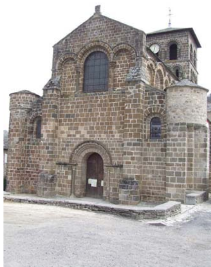
fig. 222. Façade de l'église avec échauguettes sur contreforts. Chamalières-sur-Loire.
