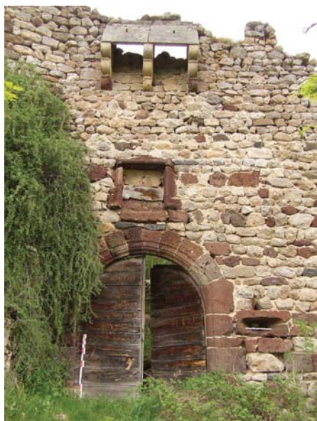
fig. 440. Portail avec armoiries, bretèche et canonnère. Agrain. Ouïdes.
