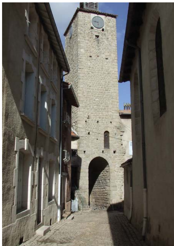
fig. 270. Vue de la face interne, côté castrum. Craponne.
