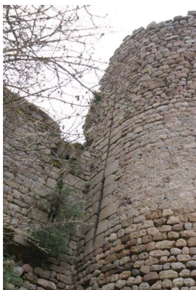
fig. 251. Détail de l'archère en rame et de celle du parapet du chemin de ronde de la courtine. Arzon. Chomelix.
