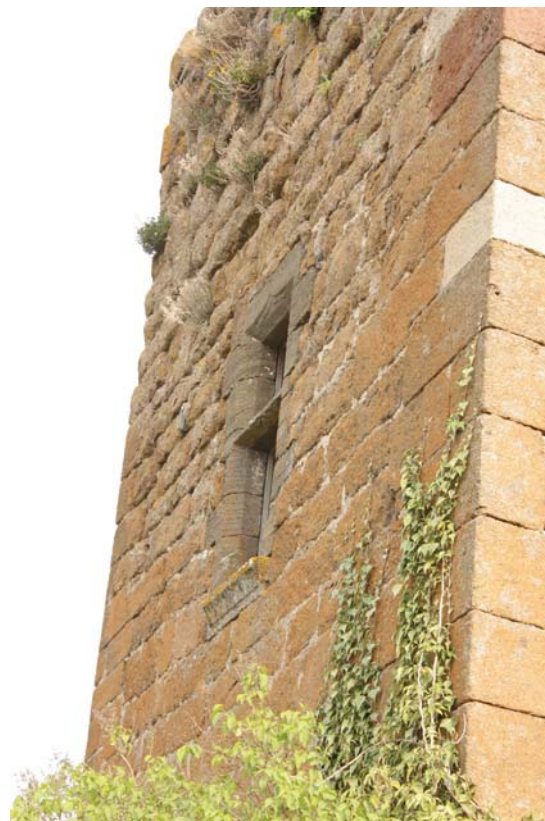
fig. 207. Vue de la face ouest de la tour, fenêtre à simple traverse. Ceyssac.
