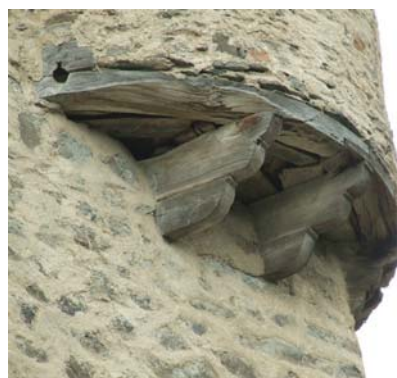
fig. 225. Détail des corbeaux des échauguettes en bois. Ventressac. Chamalières-sur-Loire.
