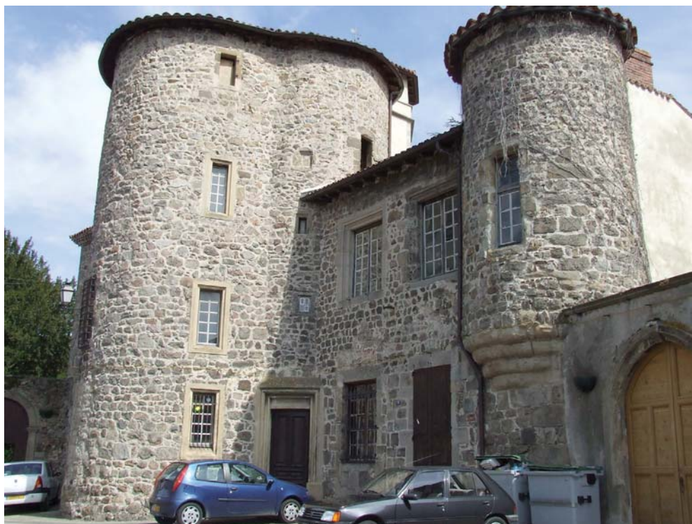
fig. 88. Vue du flanc nord du château. Aurec-sur-Loire.
