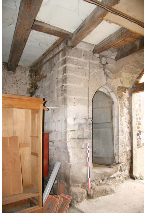
fig. 7. Vue de la porte d'accès à l'escalier en vis. Aiguilhe.
