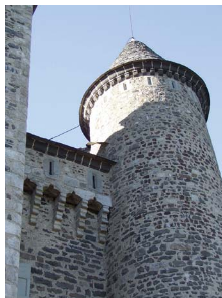
fig. 495. Détails de la face sud avec réfection sans doute récente de la terrasse de la tour. Vachères. Présailles.
