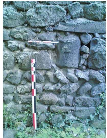
fig. 469. Détail de l'opus spicatum. Cussac. Polignac.
