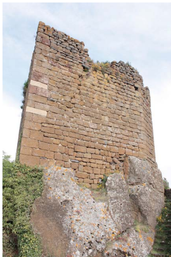
fig. 205. Vue de la face sud de la tour, chaîne d'angle comportant deux blocs d'arkoses. Ceyszac.
