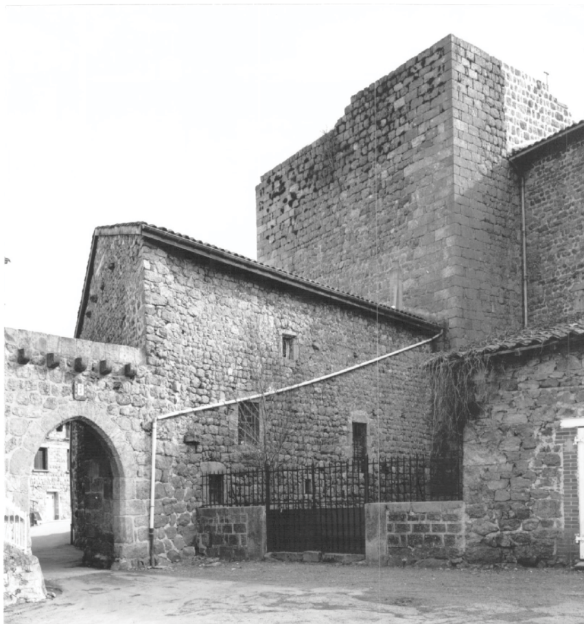
fig. 53. Vue de la maison du castrum et d'une porte du bourg d'Apinac (issue du Dossier DRAC-CRMH-Inventaire).
