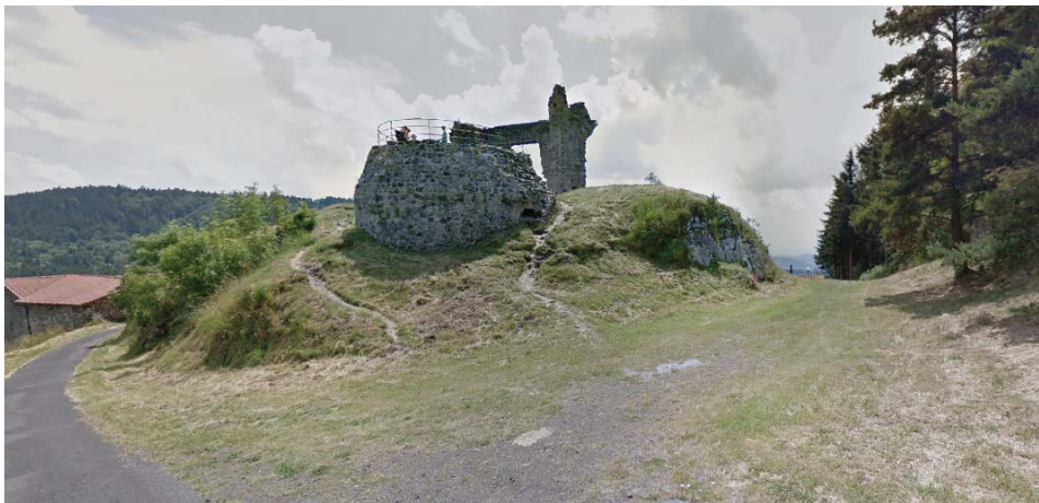
fig. 20. Tour nord-ouest à embase tronconique et glacis. Château d'Allègre. Googlemaps.
