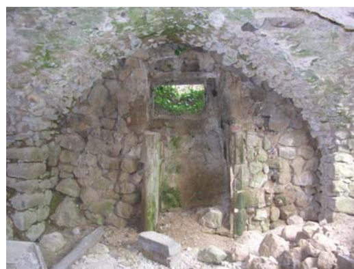
fig. 232. Voûtement du rez-de-chaussée. Le Chambon à la Chapelle-d'Aurec.
