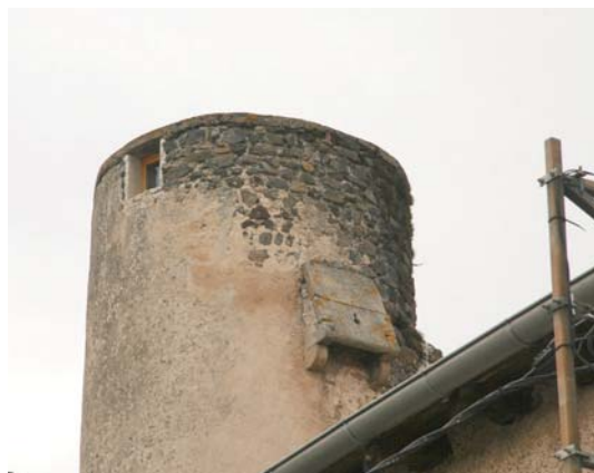
fig. 516. Détail de la huchette de la tour. Ours. Puy-en-Velay.
