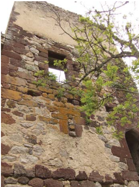
fig. 434. Vue générale de l'élévation de la tour. Agrain. Oüides.
