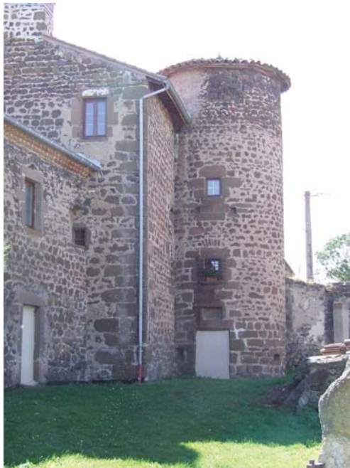
fig. 234. Vue de la tour d'escalier murée. Les Ternes. Chaspuzac.
