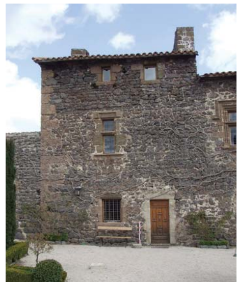
fig. 366. Corps de bâtiment côté cour (sud). Coubladour. Loudes.
