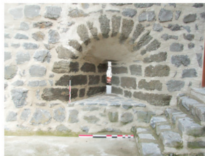
fig. 354. Arbalétrière située sur la courtine en basalte. Le Charrouil. Loudes.
