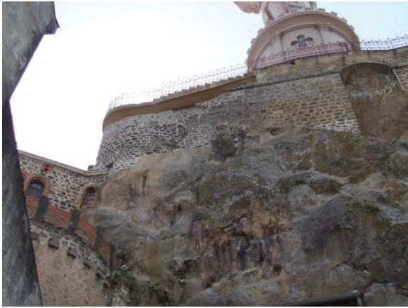
fig. 291. Murs de sous-bassement du socle de la statue Saint-Joseph à l'ouest : on décèle les bases d'une tour circulaire à gauche construite à même le rocher. Espaly.
