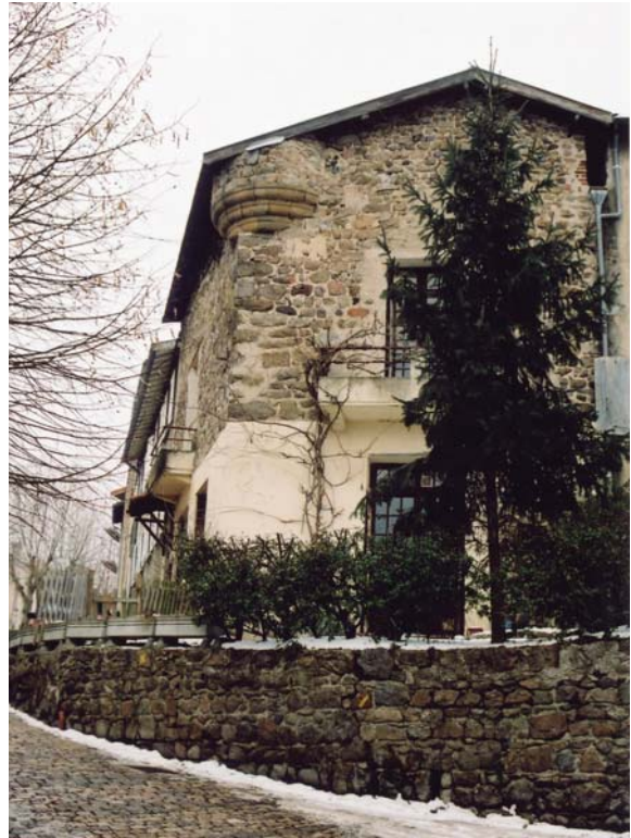
fig. 74. Échauguette d'angle sur une maison formant l'angle nord-ouest du bourg. Aurec-sur-Loire.
