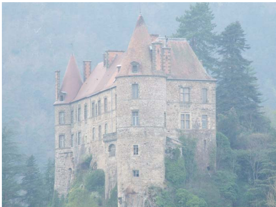
fig. 333. Vue générale de l'aile composant le château de Lavoûte. Lavoûte-sur-Loire.
