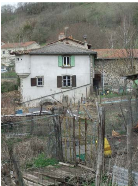
fig. 472. Vue générale du moulin. Les Estreys. Polignac.
