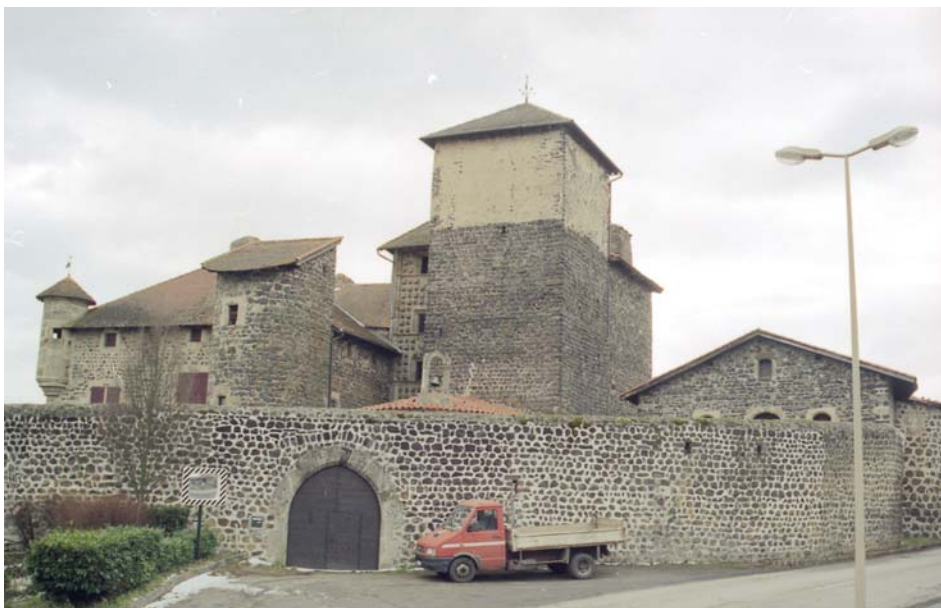
fig. 258. Vue de la Tour Daniel depuis l'entrée nord-ouest.
