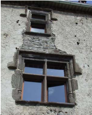
fig. 458. Détail des fenêtres à meneau. Communac. Polignac.
