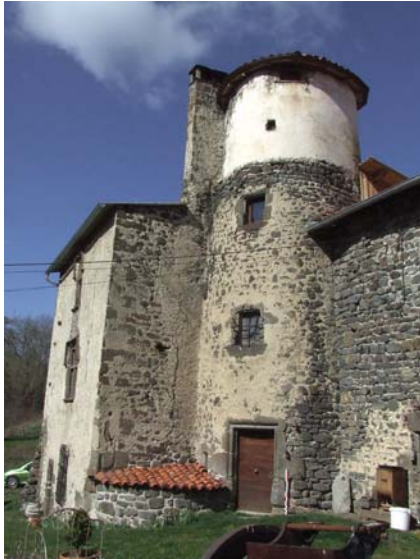
fig. 456. Vue de la façade d'entrée. Communac. Polignac.
