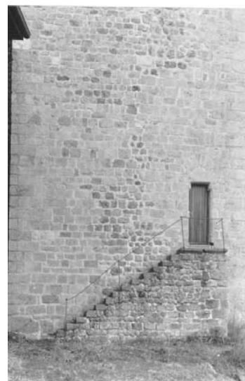
fig. 376. Vue d'une porte à linteau à coussinet aménagée dans une ancienne porte. Dossier de l'Inventaire. Base Mérimée. Leignec.
