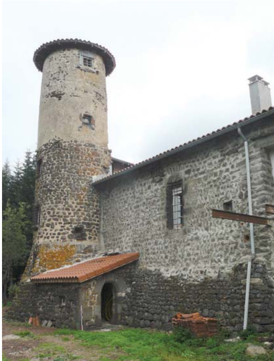
fig. 182. Vue générale du château des Roys. Le Brignon.
