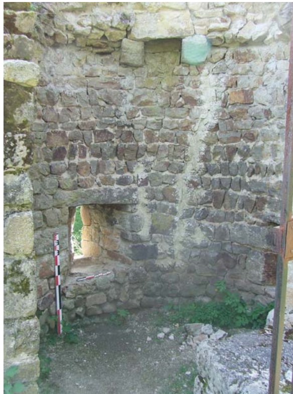
fig. 117. Vue de l'intérieur de la tour est du châtelet de la porte 1. Rochebaron.
