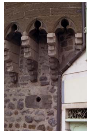
Plan et détail des mâchicoulis et de l'archère-cannonnière tronquée (ci-dessous).
