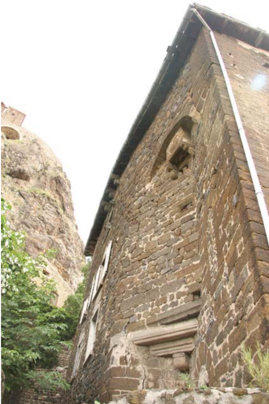
fig. 8. Face ouest de l'édifice. Aiguilhe.
