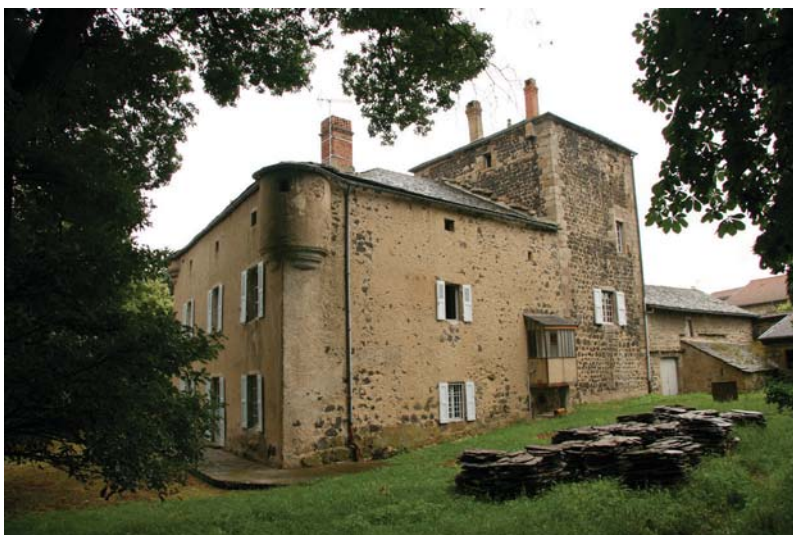
fig. 136. Vue générale logis et tour. Beaux.
