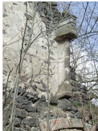
fig. 178. Détail d'un piédroit de cheminée. Soleilhac à Blanzac.
