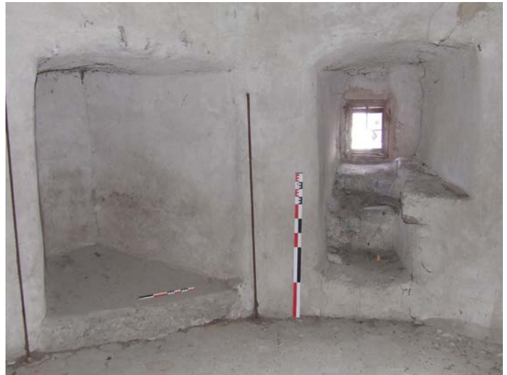
fig. 79. Fenêtre à coussiège et embrasure bouchée, vue intérieure du 3 e niveau. Aurec-sur-Loire.
