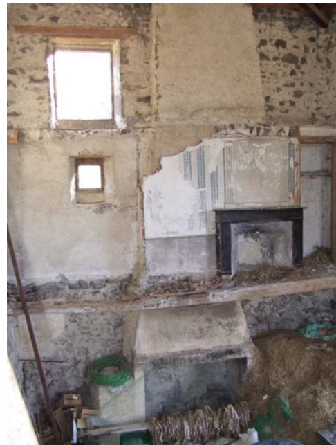
fig. 445. Détail de la cheminée. La Barbeyre. Polignac.
