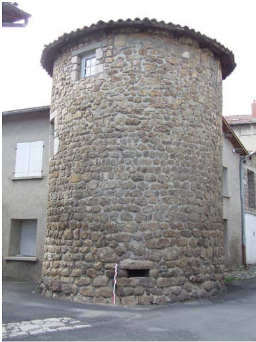
fig. 271. Vue d'une tour circulaire conservant des canonnères à ébrasement externe. Craponne.
