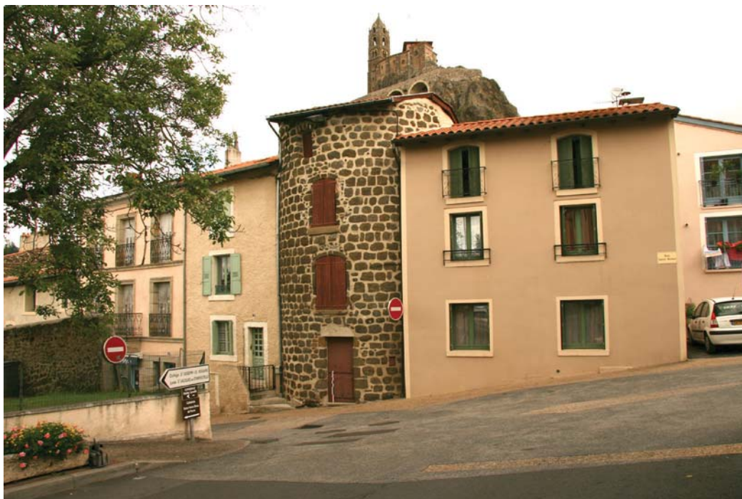
fig. 18. Tour sur l'enceinte au sud. Aiguilhe.
