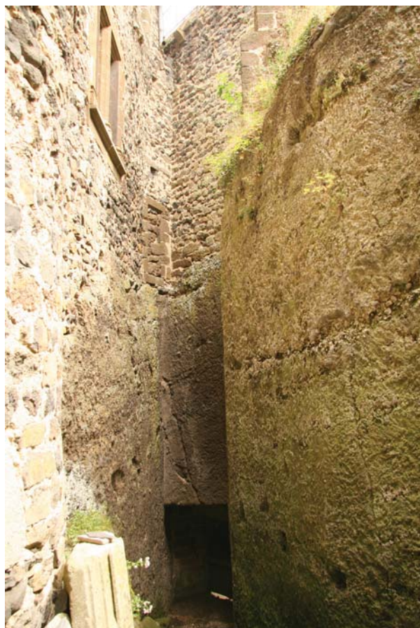
fig. 68. Passage creusé dans la roche séparant la tour quadrangulaire du reste des logis. Bouzols.
