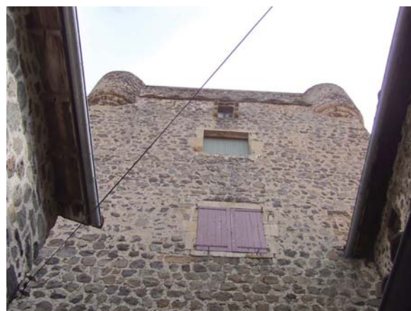
fig. 263. Vue d'une face de la tour avec corbeaux. Poinzac. Coubon.
