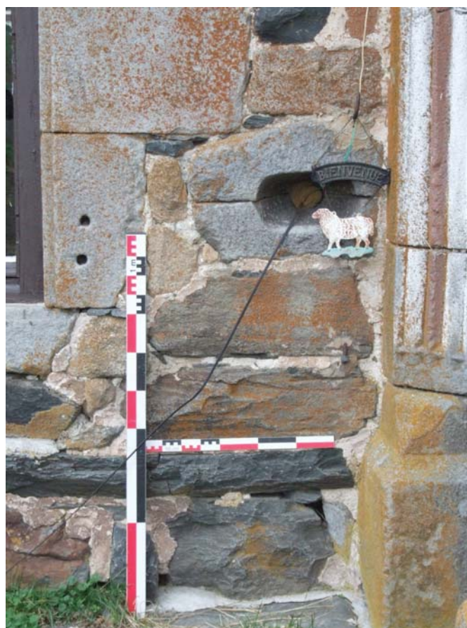
fig. 57. Vue de détail d'une canonnière située à côté de l'entrée du portail, sur le logis. Araules.
