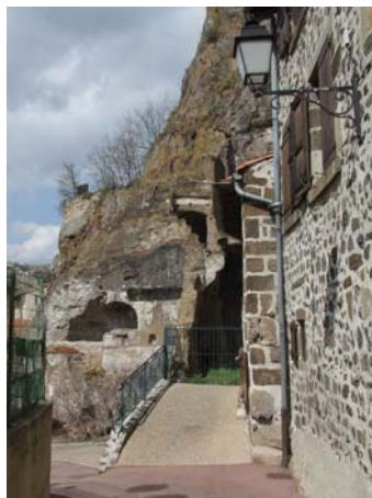
fig. 295. Traces d'ancrages pour des bâtiments dans le rocher au nord, proche de la rivière. Espaly.
