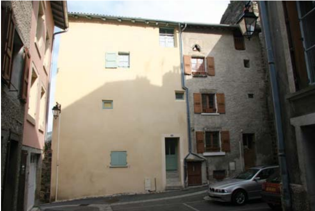
fig. 5. Vue de la façade est : les deux bâtiments formant l'ensemble de l'hôpital. Aiguilhe.
