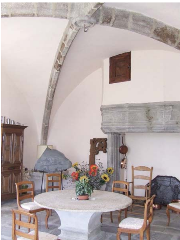
fig. 128. Voûte d'ogive et cheminée du 1 er niveau. Adiac.
