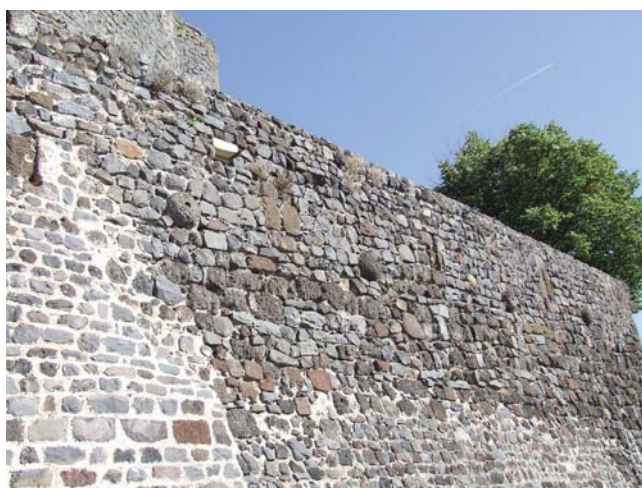
fig. 66. Rampe d'accès monumentale située sur le côté sud. Bouzols.
