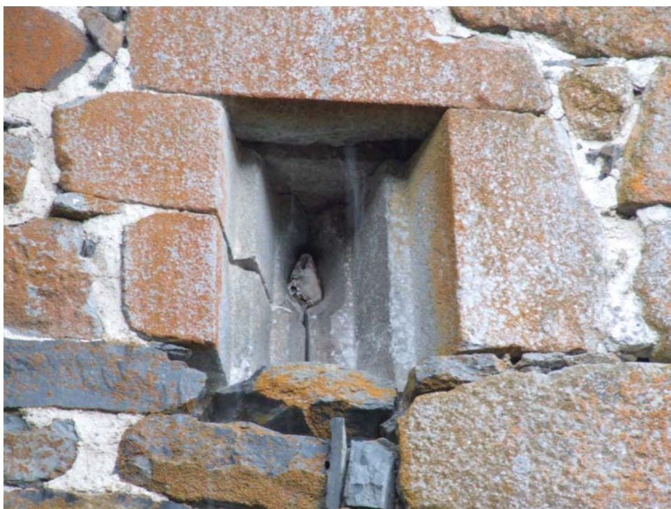
fig. 56. Vue de détail d'une canonnière à redent présente sur la tour d'escalier. Araules.
