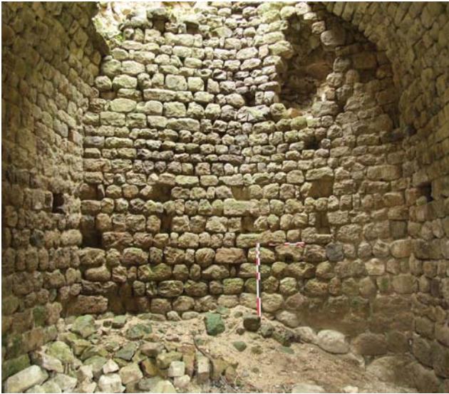
fig. 320. Vue intérieure du niveau bas de la tour. Carry-Vertamise. Grazac.
