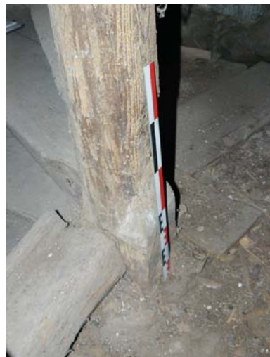
fig. 185. Détail de l'escalier en bois. Les Roys. Le Brignon.
