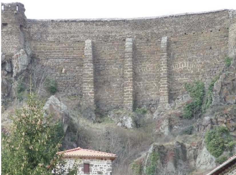
fig. 482. Mur à contreforts. Castrum de Polignac.
