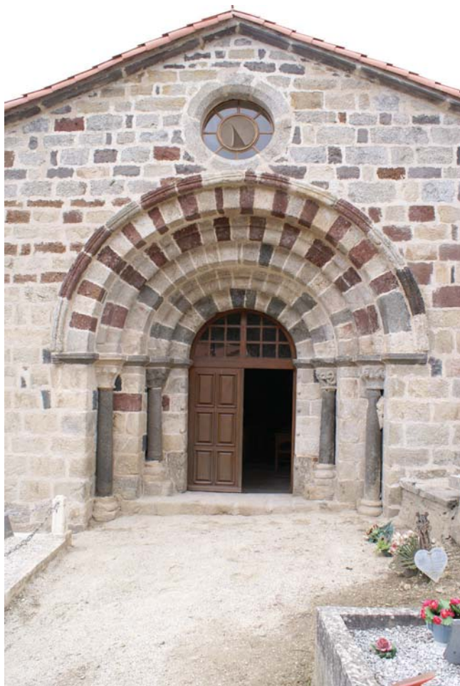
fig. 47. Vue du portail de la Chapelle Saint-Vincent de Vabres. Alleyras.
