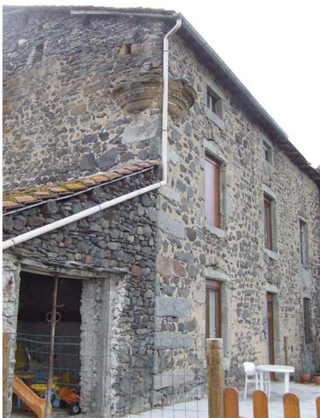
fig. 139. Vue d'un cul de lampe à denticule, d'une ancienne échauguette, maison forte du Bouchet.
