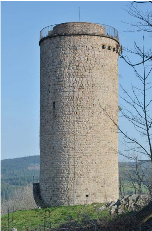
fig. 279. Vue de la Tour dite de Joyeuse à Dunières.
