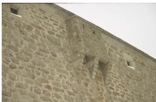
fig. 306. Détail Bretèche. Freycenet-la-Cuche.
