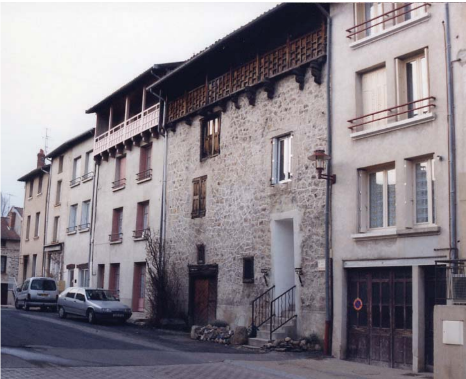
fig. 147. Vue de l'enceinte sud du bourg. Beauzac.
