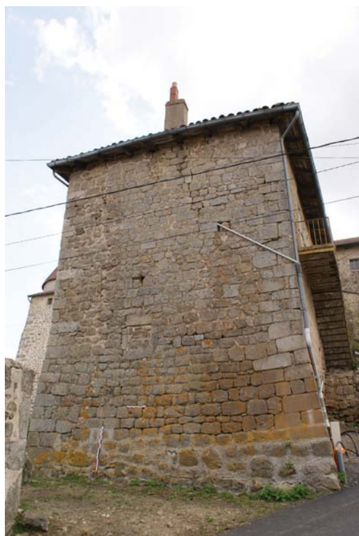
fig. 171. Embase talutée de ce logis au nord. Bellevue-la-Montagne (Saint-Just-près-Chomelix).
