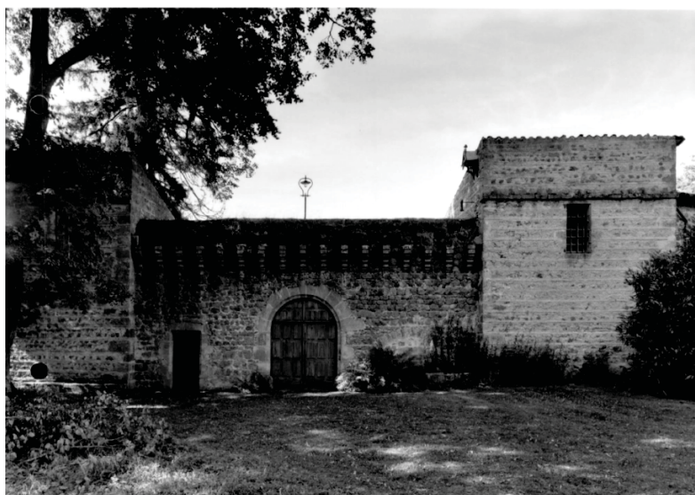
fig. 303. Consoles de mâchicoulis sur porte de l'avant-cour. La Marandière.
