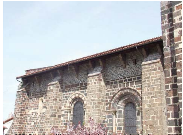
fig. 385. Détail de l'étage surélevé de la nef de l'église sur le mur gouttereau sud. Le Monastier-sur-Gazeille.
