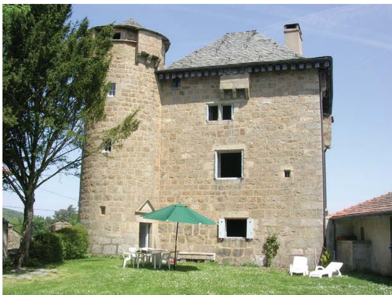
fig. 236. Vue de la façade d'entrée avec portail et bretèche. La Borie. Chenereilles.
