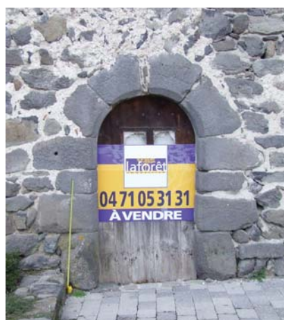
fig. 174. Détail d'une porte de ces bâtiments. Blanzac.
