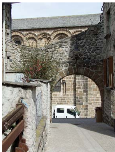
fig. 220. Porte sud extérieure. Chamalières-sur-Loire.
