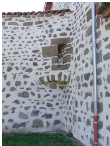
fig. 235. Détail d'une canonnière à redent. Les Ternes. Chaspuzac.
