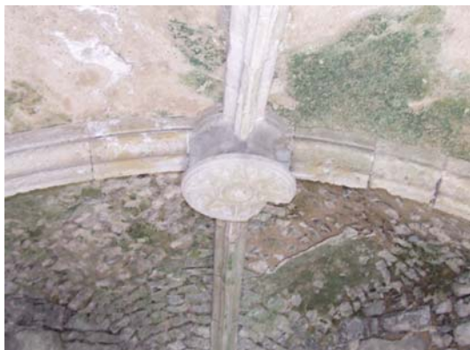
fig. 509. Détail de la voûte d'ogive du niveau 5. Mons. Puy-en-Velay.
