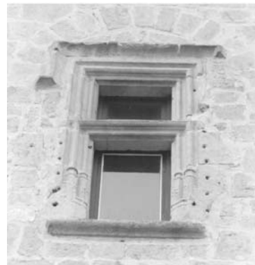
fig. 375. Vue d'une fenêtre à simple traverse aménagée dans une ancienne baie plein-cintre. Dossier de l'Inventaire. Base Mérimée. Leignec.
