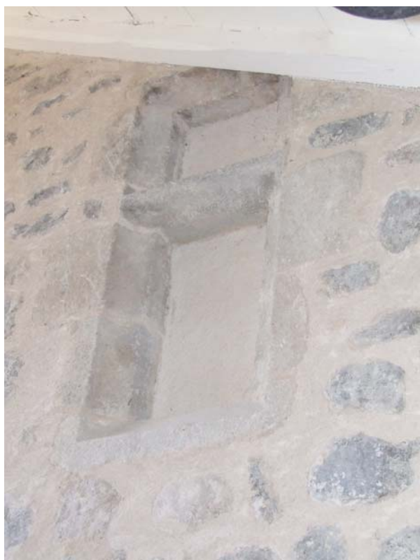
fig. 130. Fenêtre à simple traverse. Intérieur face est. Adiac.
