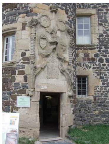
fig. 389. Portail d'entrée de la tour d'escalier façade sud du logis abbatial. Le Monastier-sur-Gazeille.
