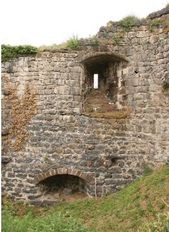
fig. 65. Ébrasement interne de l'ouverture pour le tir. Bouzols.
