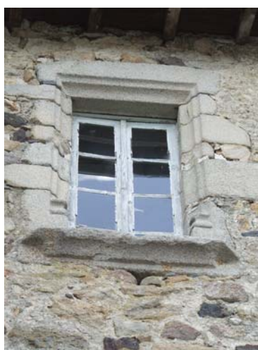
fig. 417. Détail d'une baie de la façade sud. Maison forte de Monlet.
