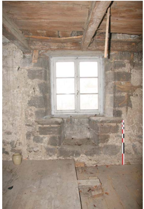
fig. 12. Détail du coussiège de la baie face ouest. Aiguilhe.
