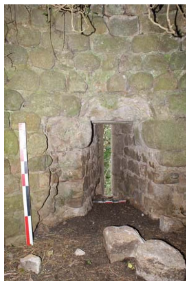
fig. 252. Linteau en coussinet d'une archère. Arzon. Chomelix.
