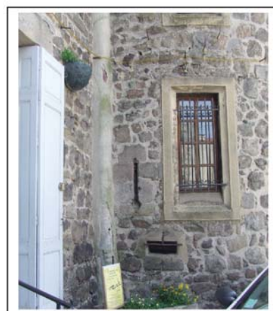
fig. 89. Détail de l'archère-canonnière conservée en flanquement est. Aurec-sur-Loire.
