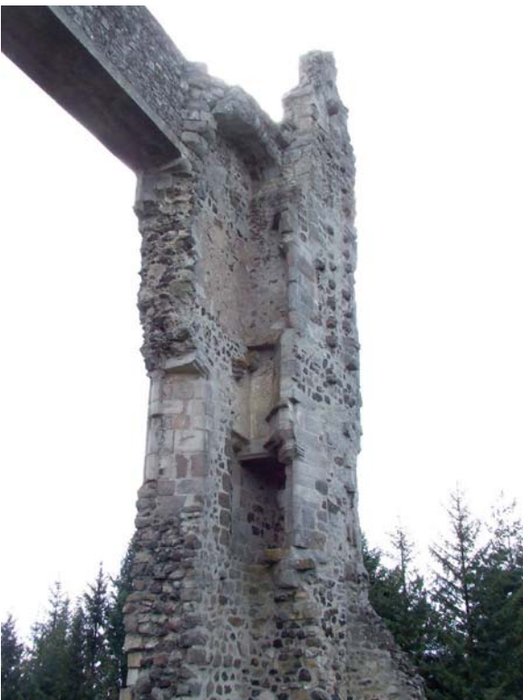
fig. 24. Jambages de cheminées au revers de la potence. Allègre.
