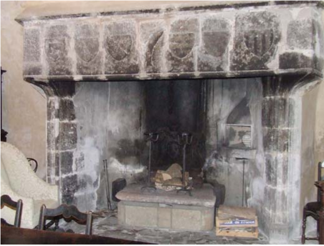
fig. 264. Vue de la cheminée du rez-de-chaussée de la tour. Poinzac. Coubon.
