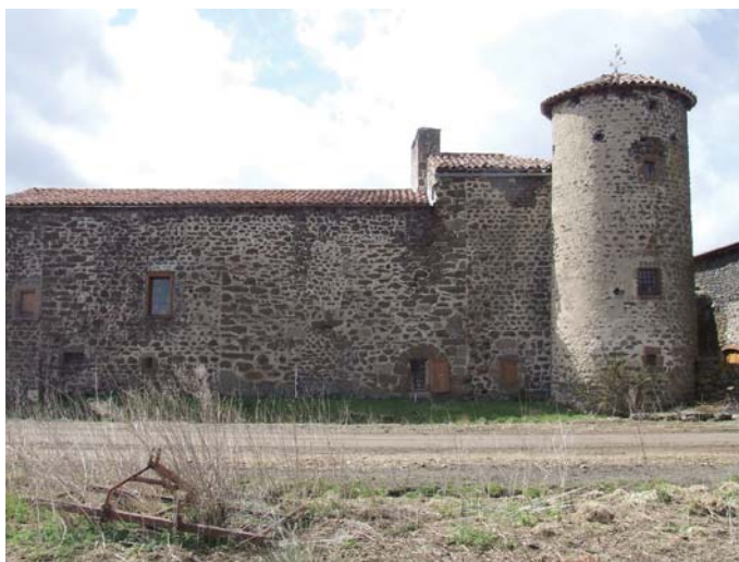
fig. 360. Vue générale du pan nord intégrant une tour quadrangulaire. Coubladour.
