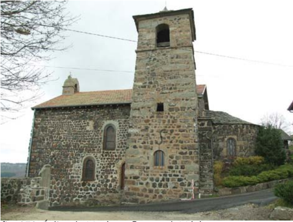
fig. 379. Église de Mezères, flanc sud. Mézères.
