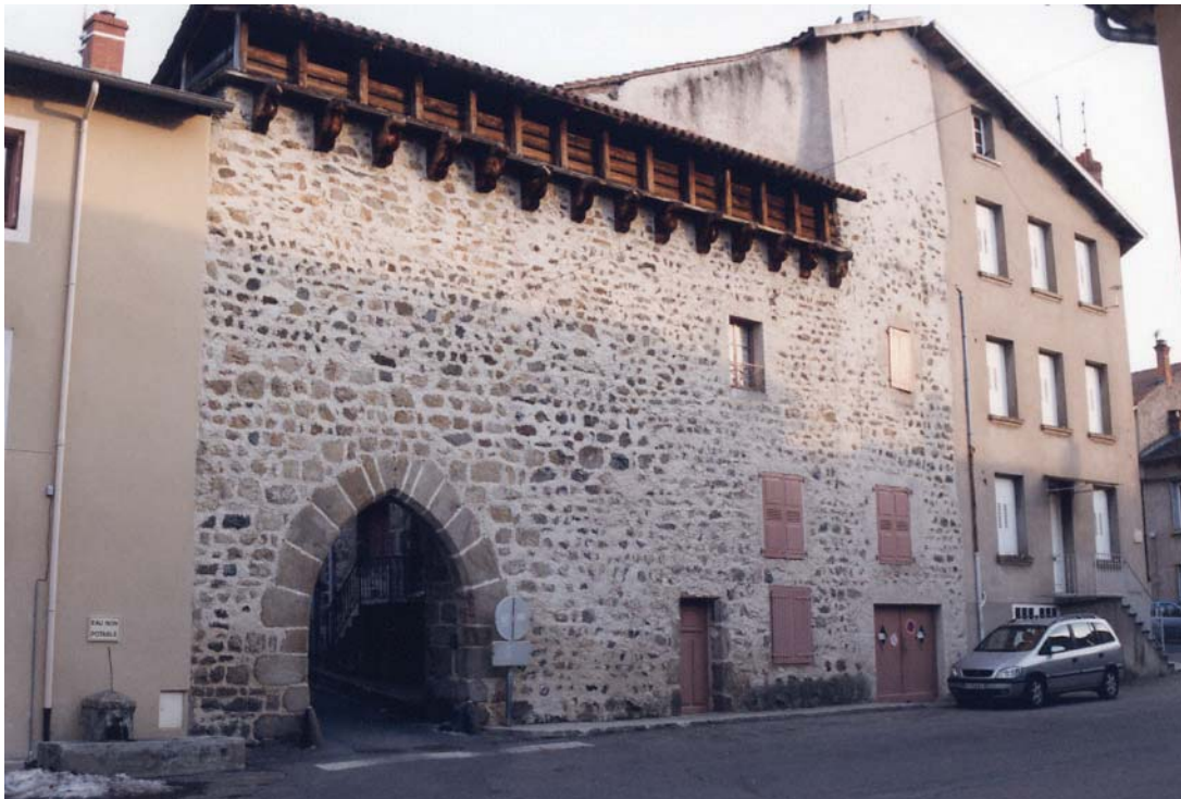
fig. 146. Vue de l'entrée ouest du bourg avec hourds de mâchicoulis restitués. Beauzac.
