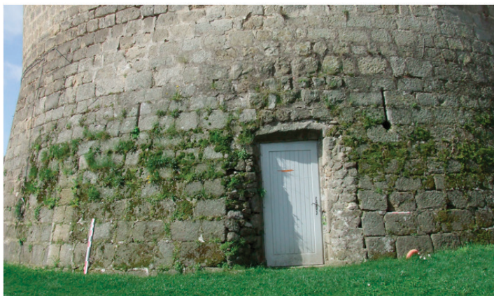
fig. 405. Archères-canonnères du talus de la grosse tour. Monistrol-sur-Loire.
