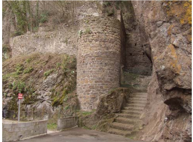
fig. 292. Poterne du castrum (angle nord-est) sur les rives de la Borne. L'escalier est creusé dans la roche. Espaly.
