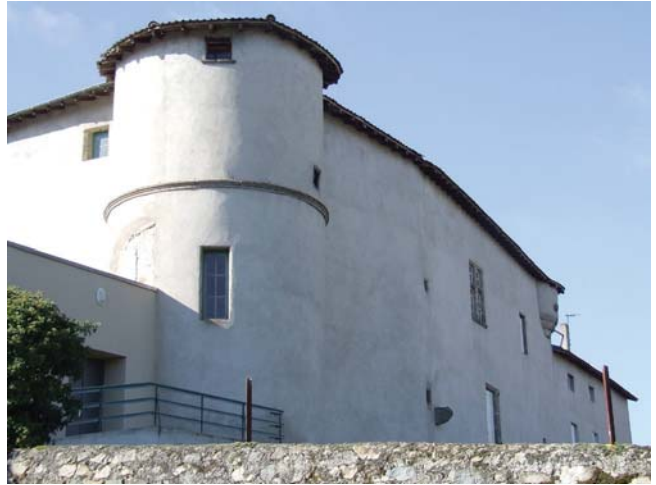
fig. 142. Vue de l'angle nord-est, extérieur. Beauzac.
