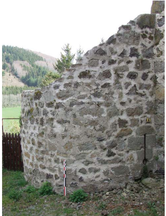
fig. 32. Tour circulaire arasée avec archère-canonnrière de l'enceinte basse. Allègre.
