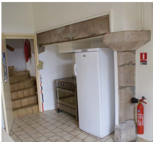
fig. 166. Cheminée tronquée du logis : rez-de-chaussée. Bellevue-la-Montagne (Saint-Just-près-Chomelix).
