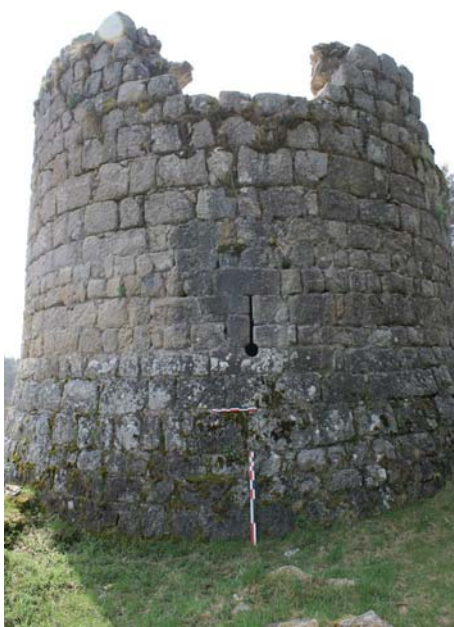
fig. 246. Détail de l'archère-canonnère flanquant l'ouest. Chomelix-le-Bas.
