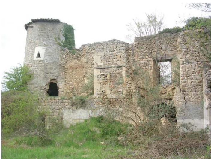
fig. 230. Vue générale de l'édifice ruiné. Le Chambon à la Chapelle-d'Aurec.
