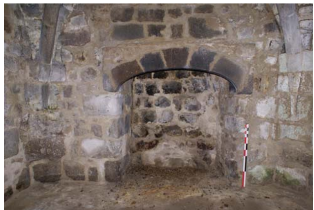
fig. 163. Cheminée de la salle basse de la tour. Bellevue-la-Montagne (Saint-Just-près-Chomelix).
