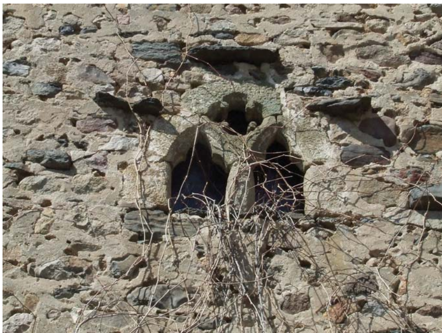
fig. 154. Vue de détail de la fenêtre géminée et trilobée de la grange. La Grange à Beauzac.
