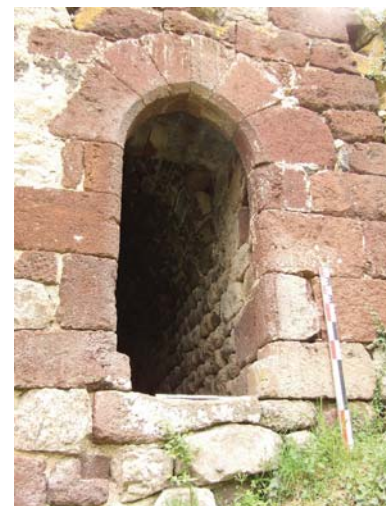
fig. 433. Porte d'accès à la tour. Agrain. Oüides.
