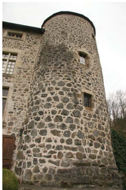
fig. 500. Vue rapprochée de la tour d'escalier du Fieu. Puy-en-Velay.
