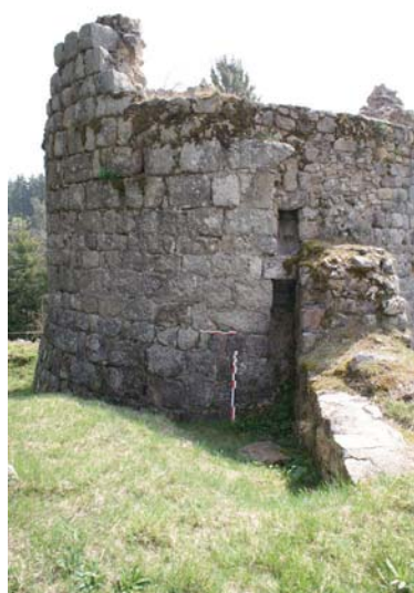
fig. 248. Détail des conduits de latrines. Chomelix-le-Bas.
