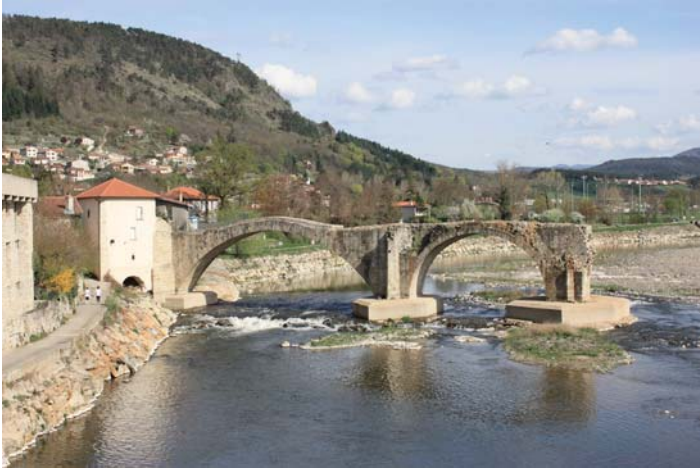
fig. 190. Pont de Brives. Brives-Charensac.
