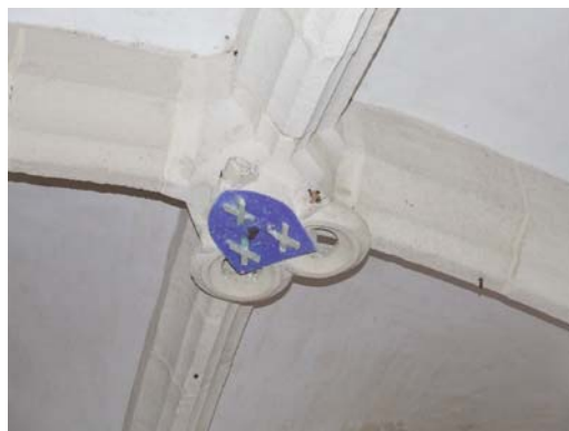
fig. 508. Détail de la voûte d'ogive du niveau 4. Mons. Puy-en-Velay.
