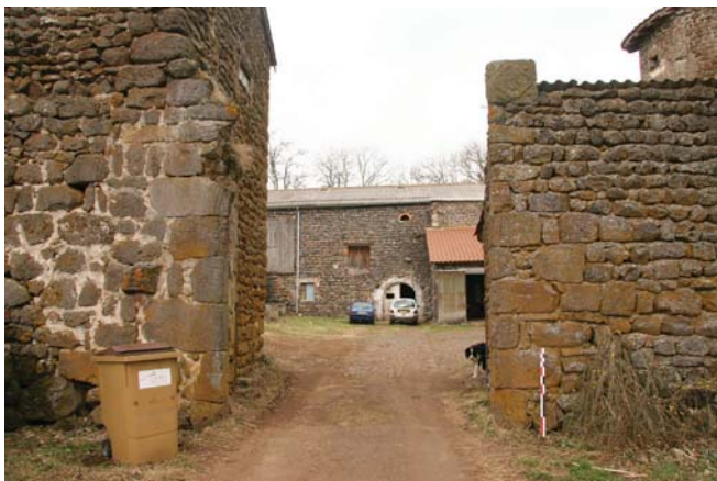
fig. 198. Vue du portail d'entrée (départ d'arc). Auteyrac. Cayres.
