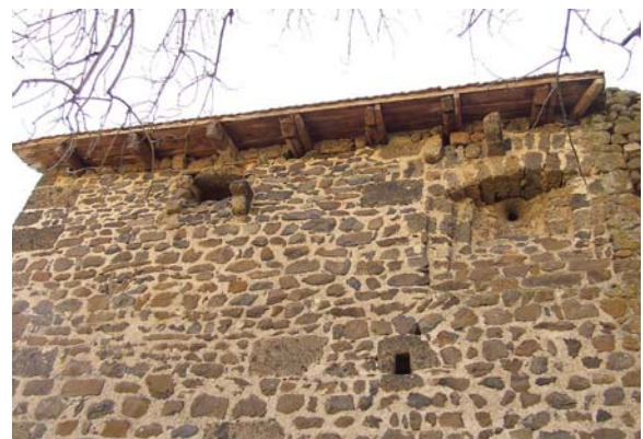
fig. 218. Détail face Nord. La Valette. Chadron.
