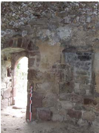
fig. 435. Vue intérieur du niveau 1 de la tour. Agrain. Oüides.
