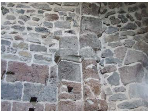
fig. 340. Détail d'un ancien pilier engagé. Lissac.
