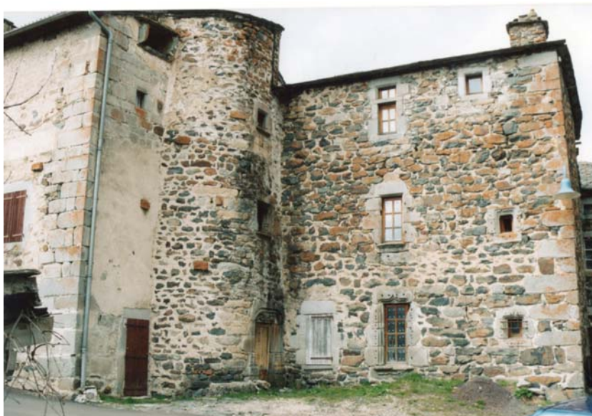
fig. 430. Vue d'une des maisons du bourg. Montusclat.
