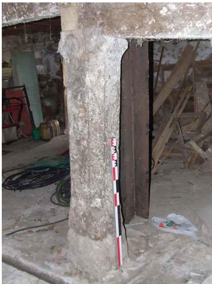
fig. 155. Vue d'un pilier de support en bois du rez-de-chaussée. Beauzac.
