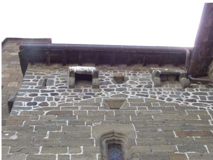
fig. 477. Détail des huchettes de l'étage de fortification. Polignac.
