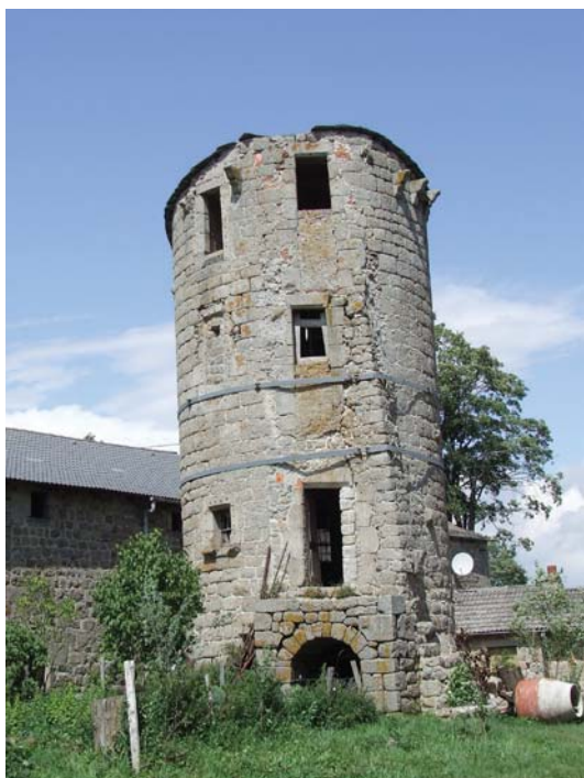
fig. 226. Vue générale de la tour. Pont-de-Mars. Chambon-sur-Lignon.
