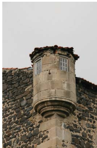
fig. 196. Échauguette d'angle sur cul de lampe. Farnier. Brives-Charensac.
