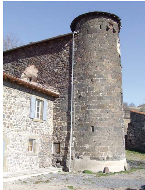
fig. 215. Vue de la tour d'escalier face ouest. La Valette. Chadron.
