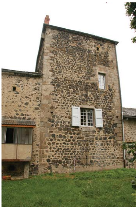
fig. 137. Vue générale de la tour. Beaux.
