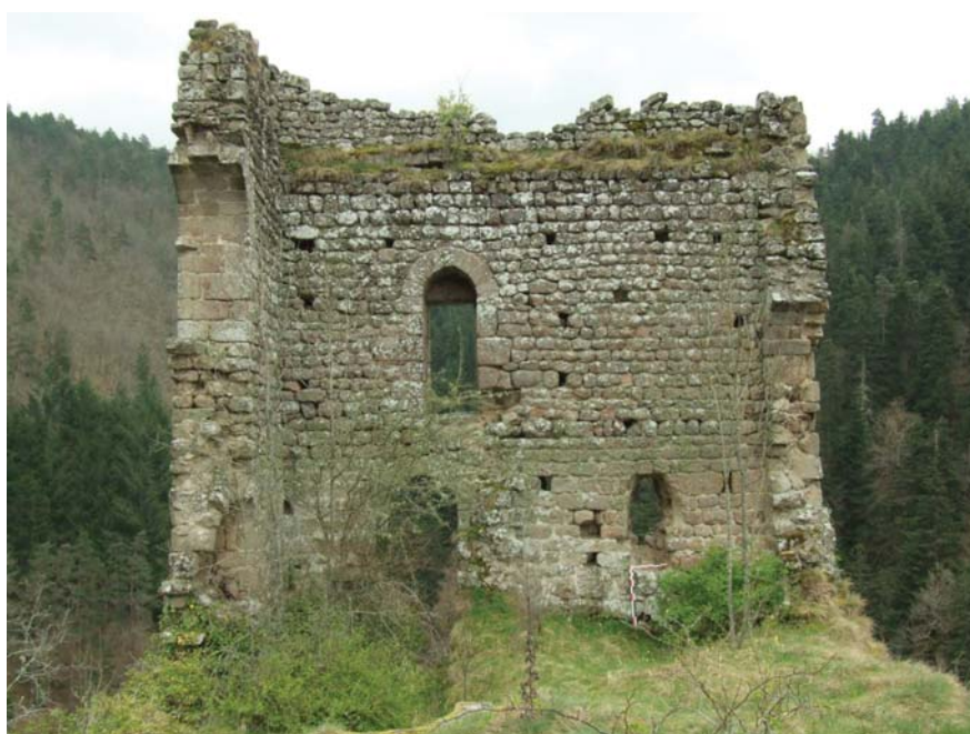
fig. 326. Vue de l'intérieur du pan de mur de la tour avec porte à linteau. Chabrespine-Saint-Martial. Grazac.
