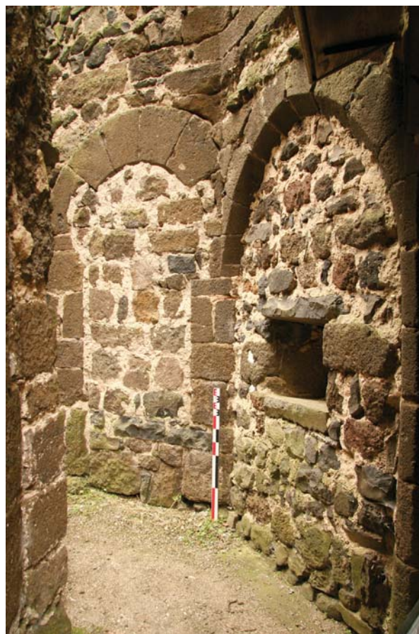
fig. 69. Arcades modernes bouchées : articulant les logis à la tour. Bouzols.
