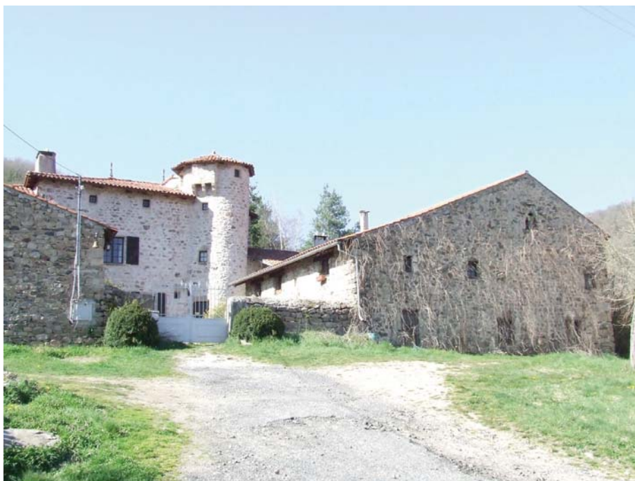
fig. 153. Vue générale de la Grange. Beauzac.
