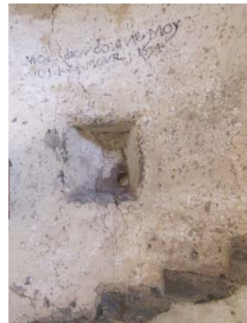
fig. 216. Vue d'une canonnière de l'escalier surmontée d'une inscription. La Valette. Chadron.
