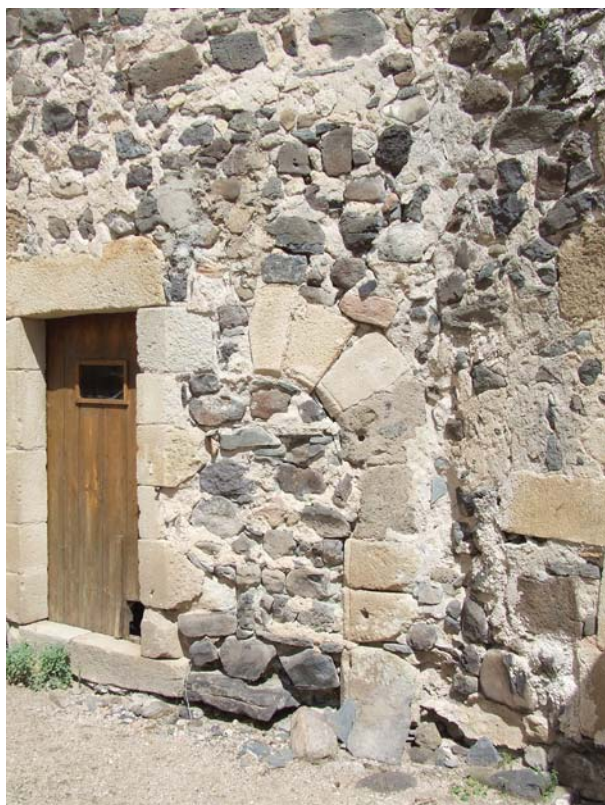
fig. 131. Fenêtre bouchée à simple traverse. Extérieur face ouest. Adiac.
