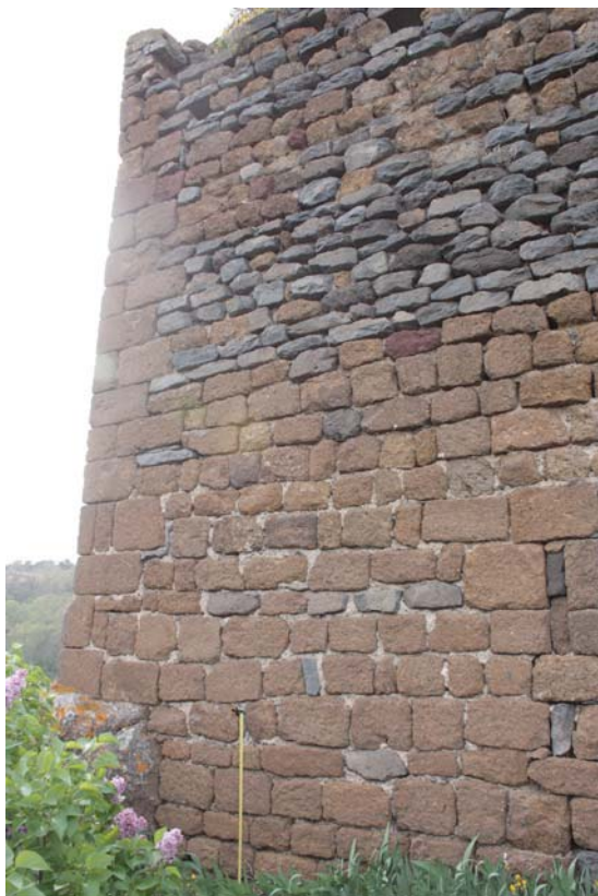
fig. 206. Vue de la face est de la tour, fente de jour bouchée. Ceyssac.
