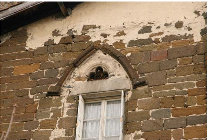
fig. 11. Détail de la baie de la face sud. Aiguilhe.
