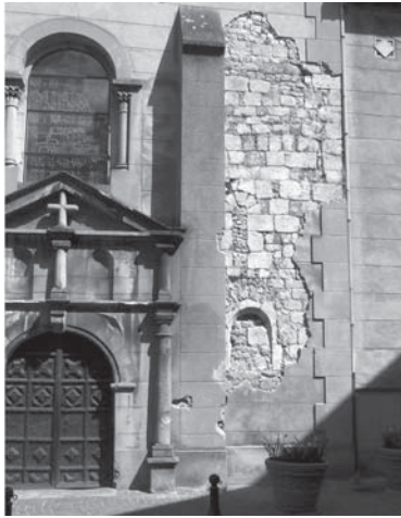
fig. 395. Façade de l'église en cours de restauration. 2008. Monistrol-sur-Loire.
