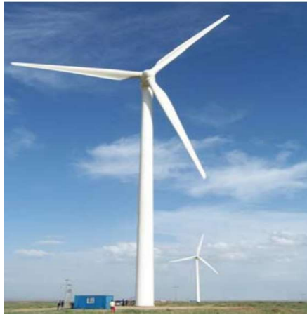
Figure 1-8 Eolienne à axe horizontal à trois pales [22].
