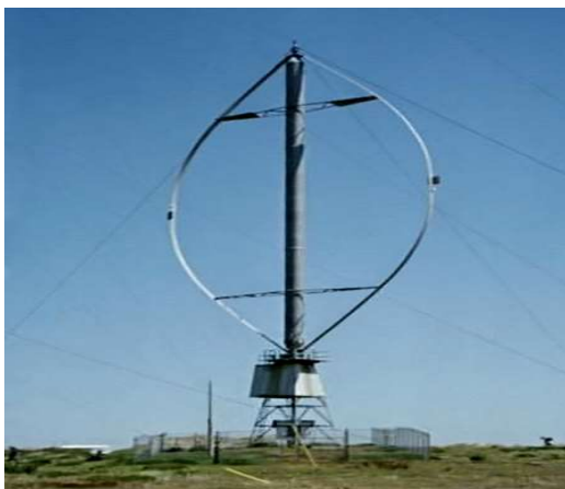
Figure 1-6 Eolienne à axe vertical de type Darrieus [17].
