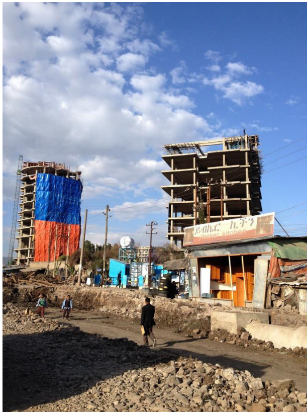
Photo 3 : Une route en construction. Élargissement d'un axe à Bolé - mars 2015
