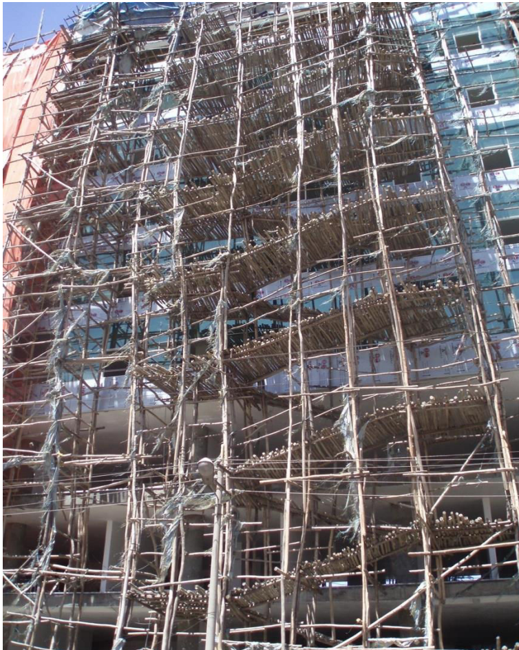
Photo 16 : Les échafaudages en bois d'eucalyptus - Février 2008
