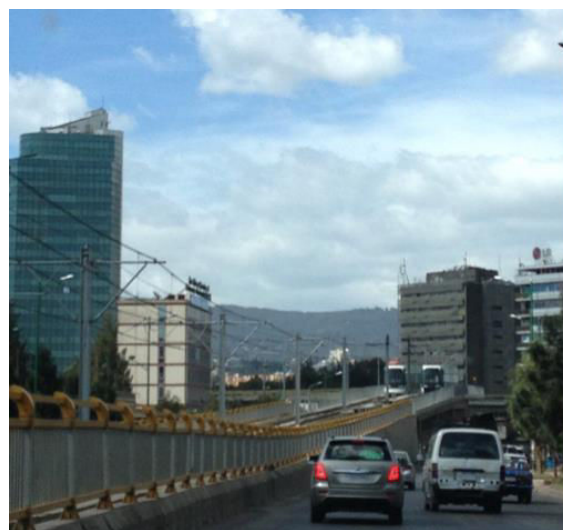
Axe Nord – Sud du tramway, à proximité de Gotera. Décembre 2015
