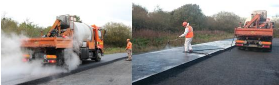
Figure IV-6 Application de la couche d'accrochage
