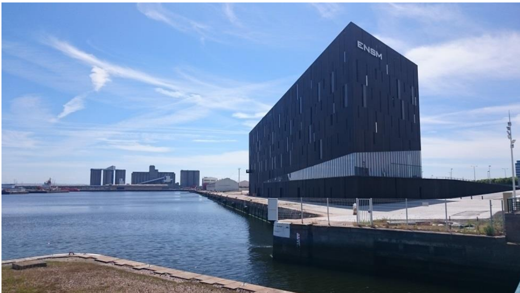
PHOTOGRAPHIE 9 NOUVEAU BÂTIMENT DE L'ÉCOLE DE LA MARINE MARCHANDE.
