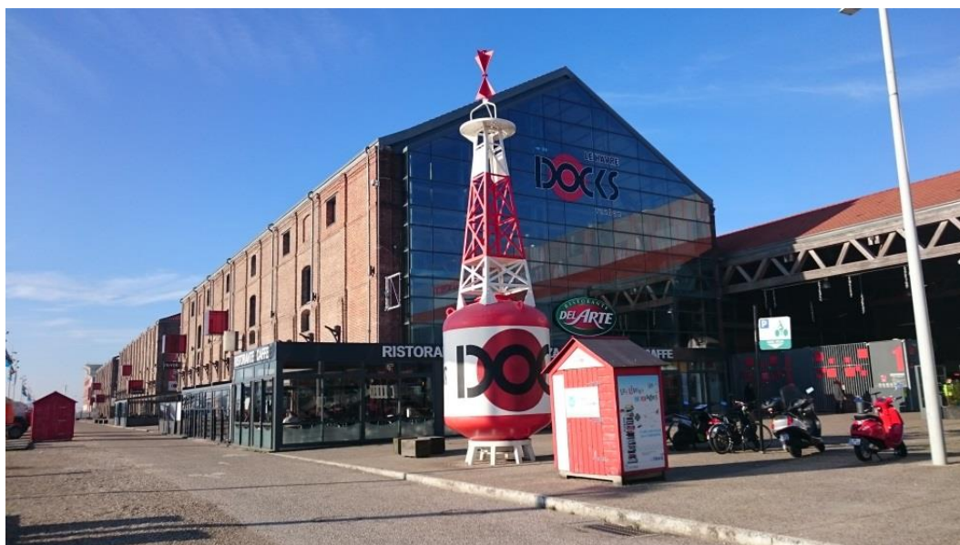
PHOTOGRAPHIE 6 VUE DU CENTRE COMMERCIAL. PHOTO DÉCEMBRE 2015.
