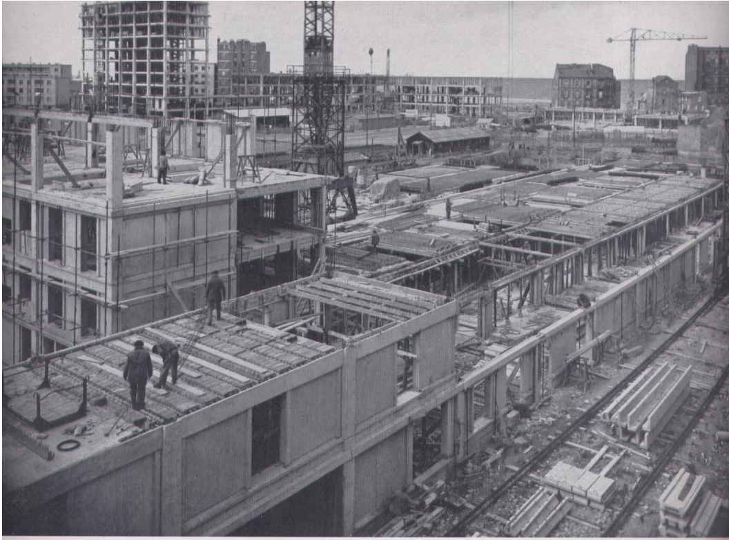
FIGURE 8 CHANTIER PENDANT LA RECONSTRUCTION. SOURCE : SITE UNESCO
