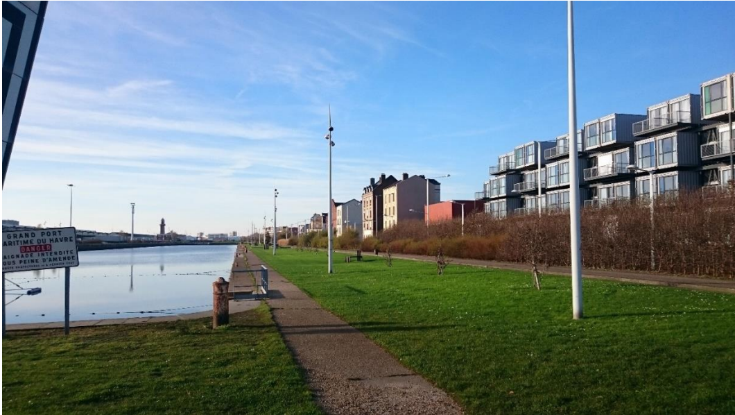
PHOTOGRAPHIE 11 PERSPECTIVE ENTRE LE BASSIN, LE JARDIN FLUVIAL ET LA CITÉ A DOCKS. DÉCEMBRE 2015.
