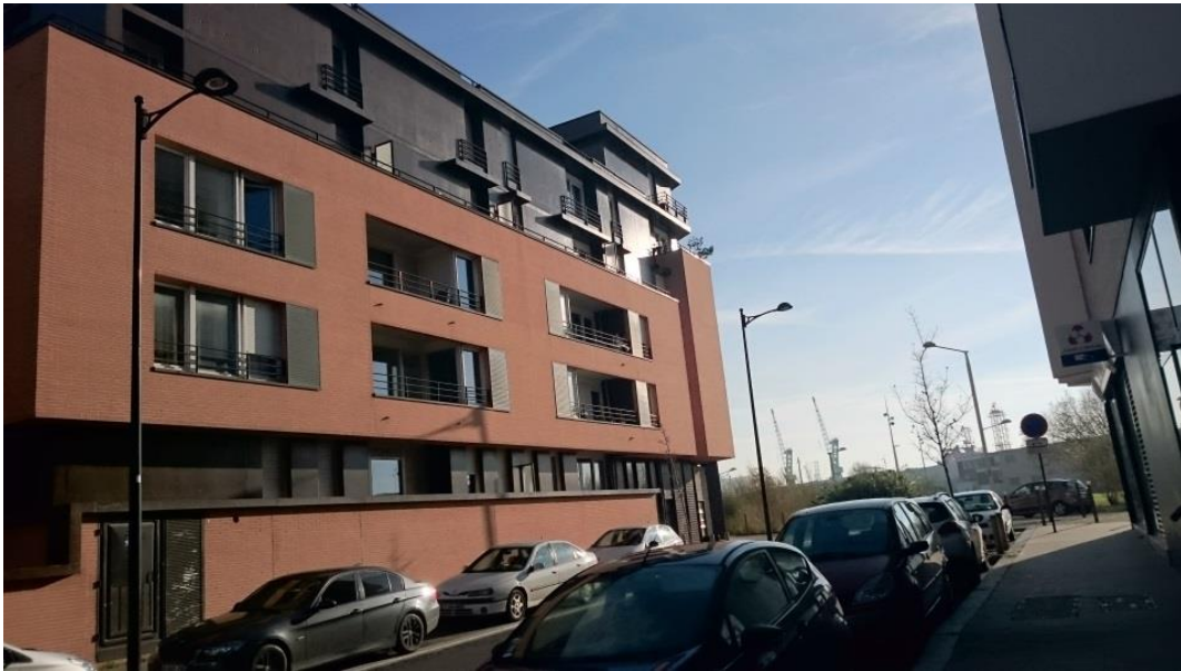
PHOTOGRAPHIE 2 NOUVELLES CONSTRUCTIONS. PHOTOGRAPHIE DE DÉCEMBRE 2015.
