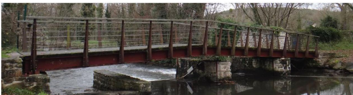
La Grande Roue - vue en amont de la passerelle - décembre 2014 - après abaissement des ouvrages
