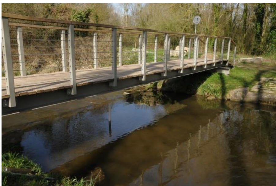
Figure 4-9 : Photographie de l'un des piézomètres placés en aval de la zone d'étude, sous la passerelle.
