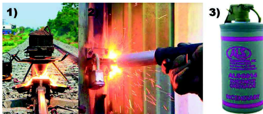
Figure 16 : 1) Utilisation d'un mélange thermite ( \text{Al} + \text{Fe}_2\text{O}_3 ) pour le soudage des rails ; 2) Utilisation d'une torche à la thermite pour la découpe d'éléments métalliques ; 3) Grenade à la thermite pour destruction de matériel
