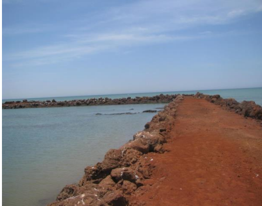
Photo 20 : Chantier de brise-lame (Thiaw 2014),
