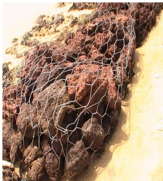
Photo 13 : Vue d'un gabion (CSE, 2011) (Hôtel Teranga, cliche de Ba septembre 2009)
