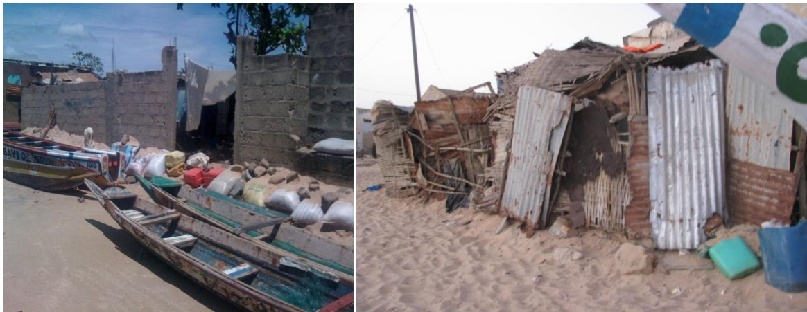
Photo 11 : Protection 2012 et état en 2014 (le mur n'a pas résisté à l'avancée de la mer)
