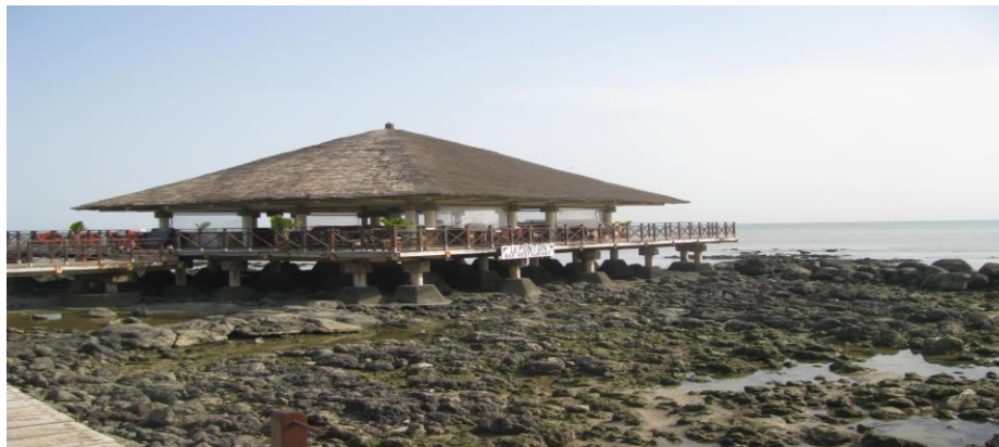
Photo 15 : Enrochement avec des ouvertures pour baignade Espadon
