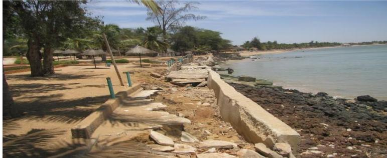
**Photo 19 : Photo savana (rupture mur de protection)**
