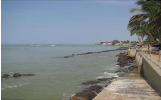
**Photo 16 : Enrochement Mur de soutènement
