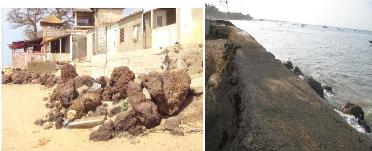
**Photo 10 : Protection de maisons Protection d'une maison par un mur aménagé avec de blocs de pierre à Saly Coulang (cliché Faye)**
