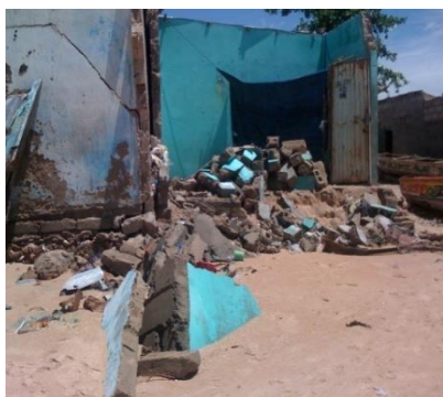
Photo 6 : Maison endommagées à Mbour Golf
