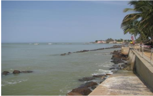
Photo 16 : Enrochement Mur de soutènement Filao
