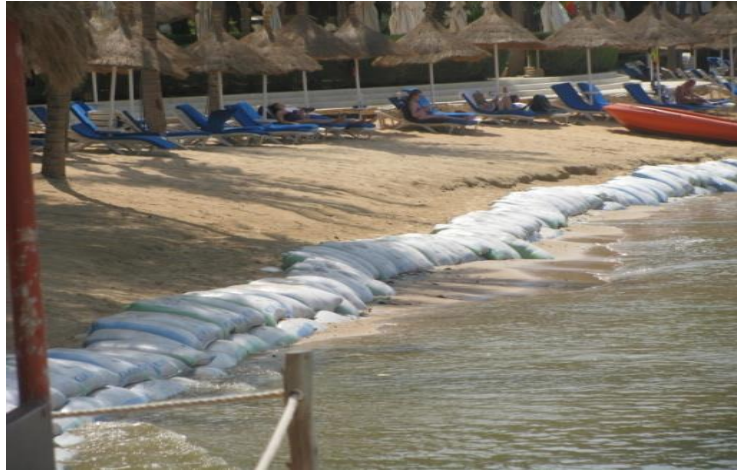
Photo 14 : Enrochement doublé d'alignement de sacs de sables (Palm Beach)
