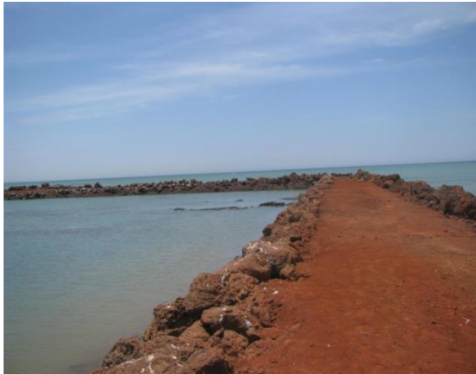
Photo 20 : Chantier de brise-lame (Thiaw 2014),
