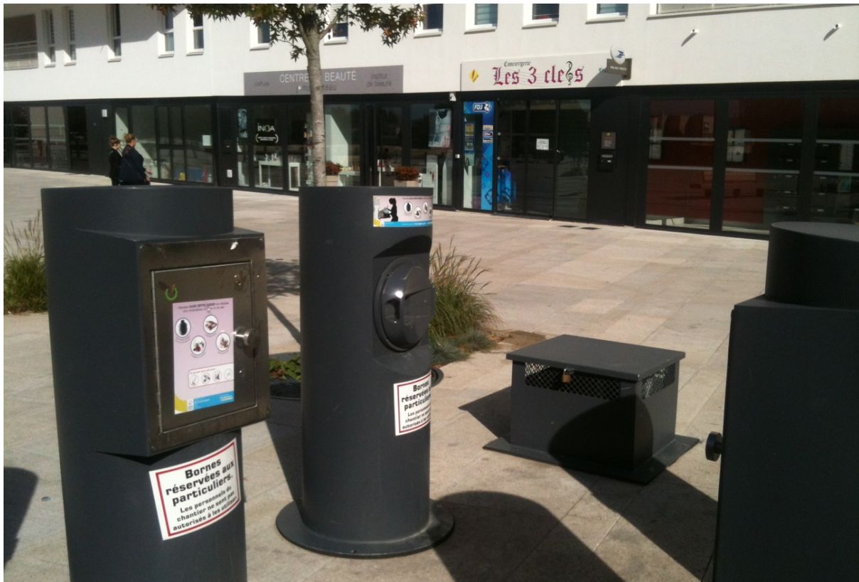
Photographie de la conciergerie Les 3 clefs, en arrière-plan, qui offre un ensemble de services (de la réception de colis à l'aide aux devoirs) aux résidents du Fort. Au premier plan, les bornes d'aspiration des déchets. Source : réalisation personnelle le 26 septembre 2014.
