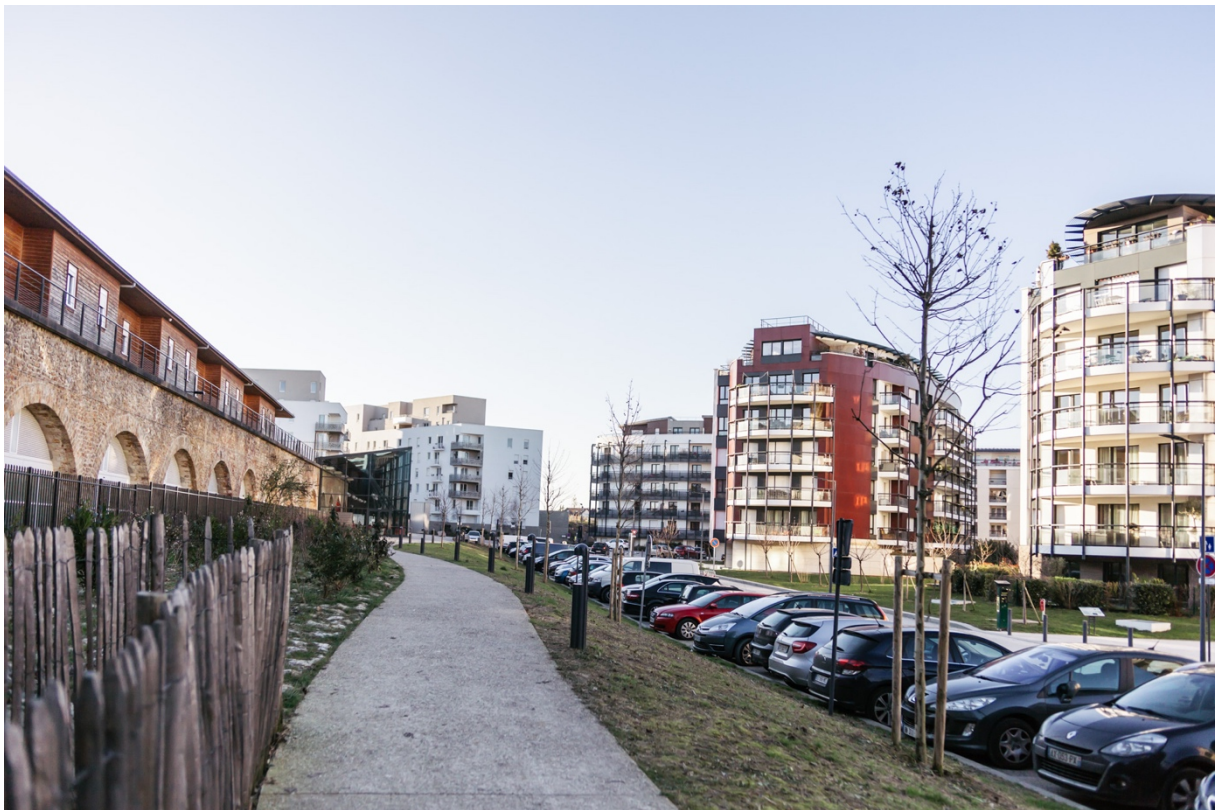
Photographie du mur d'enceinte à gauche surplombé de maisons en bois appartenant à la Direction Générale de la Gendarmerie Nationale. À l'arrière-plan à gauche on distingue également les bâtiments construits à l'intérieur de l'un des cinq bastions du Fort. À droite les « Immeubles-Villas » de forme ovale. Source : Loïc Nys, le 25 février 2018.
