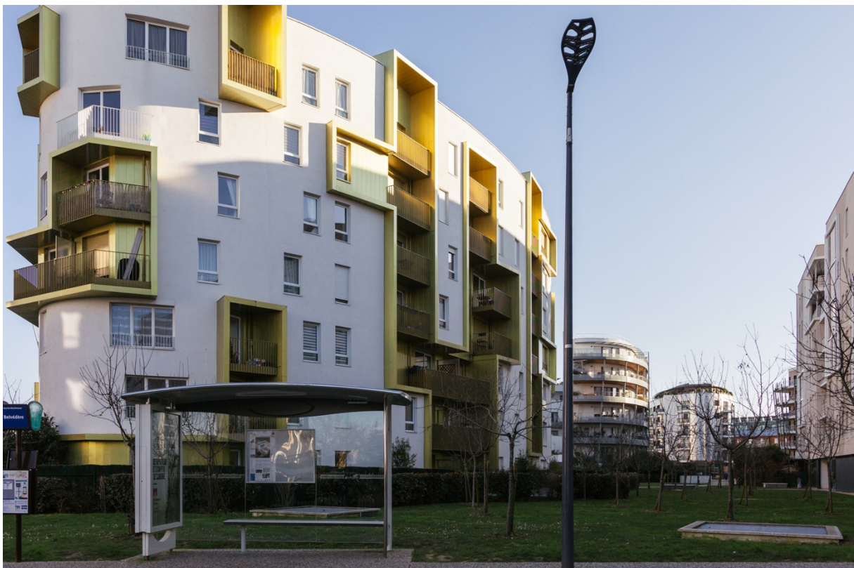
Photographie des arbustes et d'une partie du verger, conçus comme le poumon vert du projet. Source : Loïc Nys le 25 février 2018.
