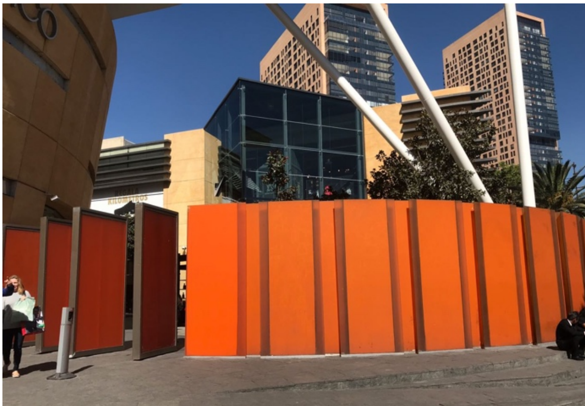
Photographie de l'entrée du centre commercial Antara. Un passage confidentiel et régulé par de grands panneaux orange. L'intérieur est traité comme une rue commerçante haut de gamme. Source : Estefanía Robles le 11 décembre 2017
