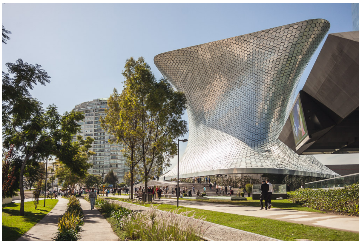
Photographie du musée Soumaya bordé par l'emprise ferroviaire et le parc linéaire. Source : Loïc Nys le 27 novembre 2014.
