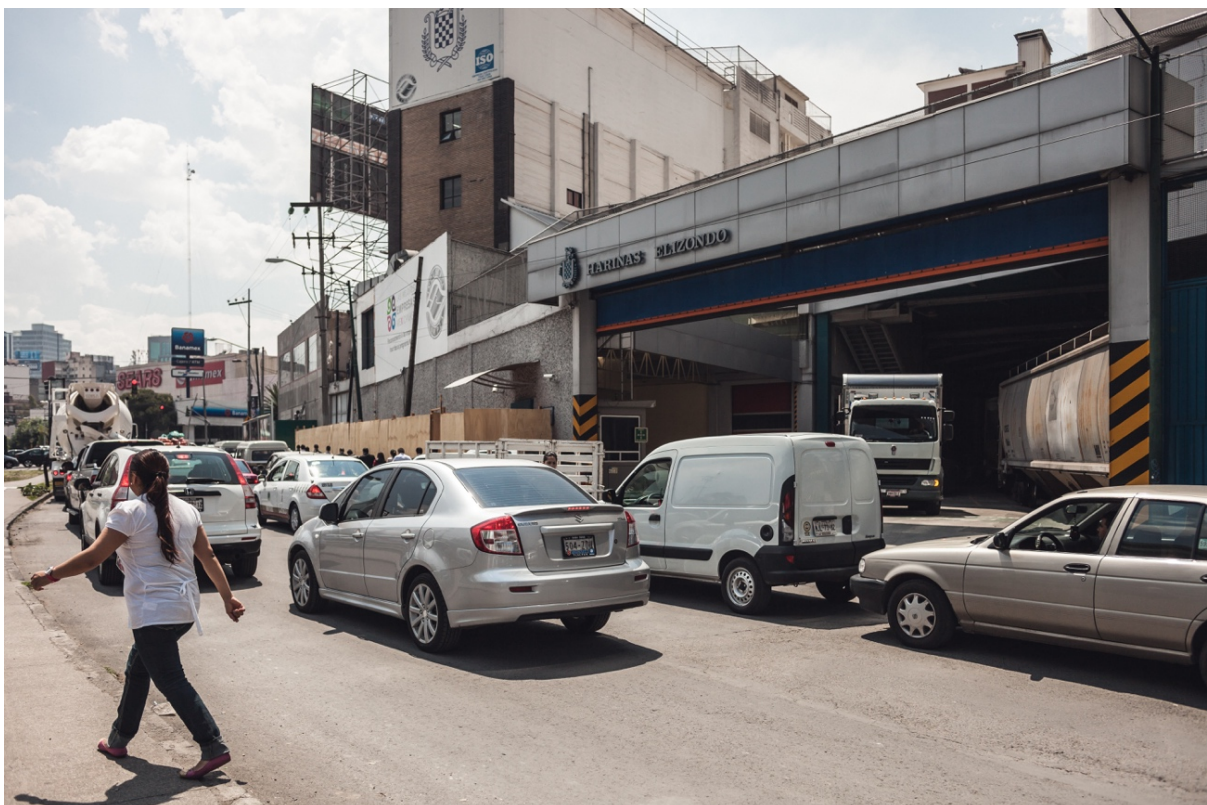
Photographies de quelques emprises industrielles résiduelles (usine de farines et brasserie Modelo). Source : Loïc Nys le 24 mars 2015.
