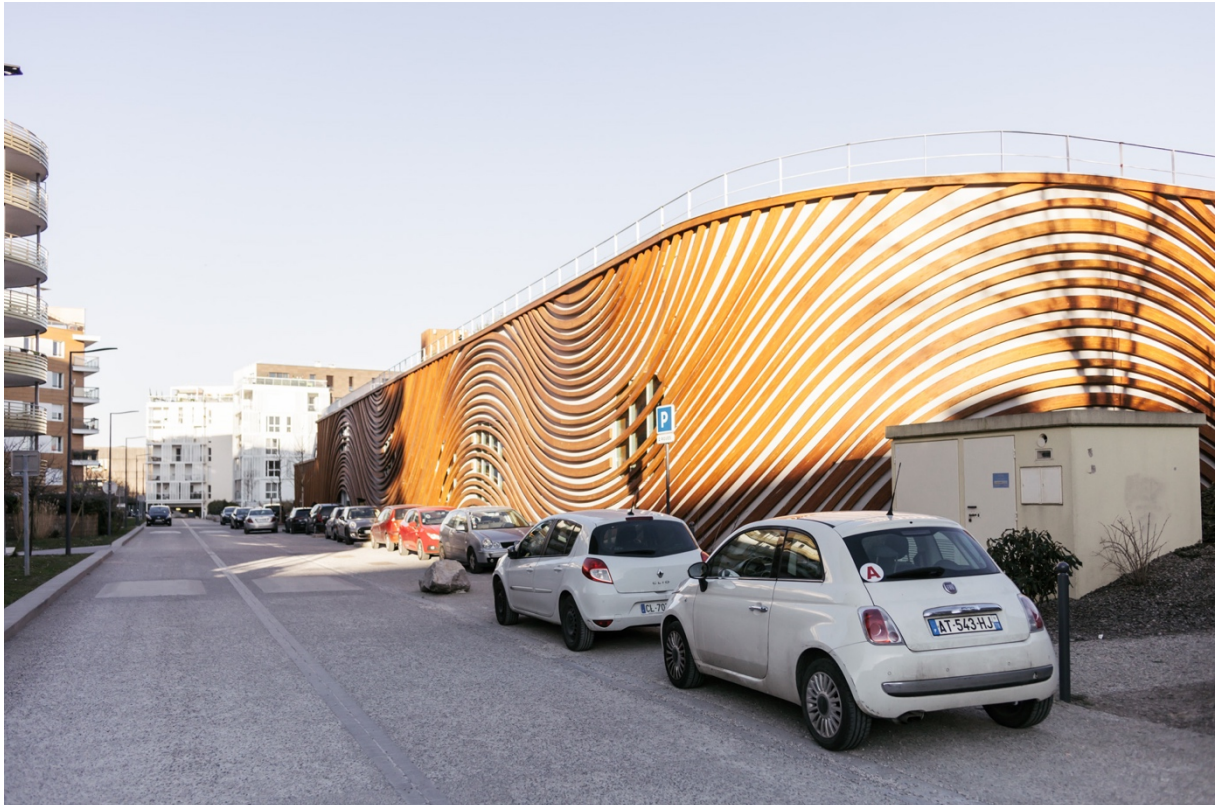
Photographie de la piscine « Feng Shui » (Aquazena) conçue par les architectes du Studio Mikou en 2015. Source : Loïc Nys le 25 février 2018.
