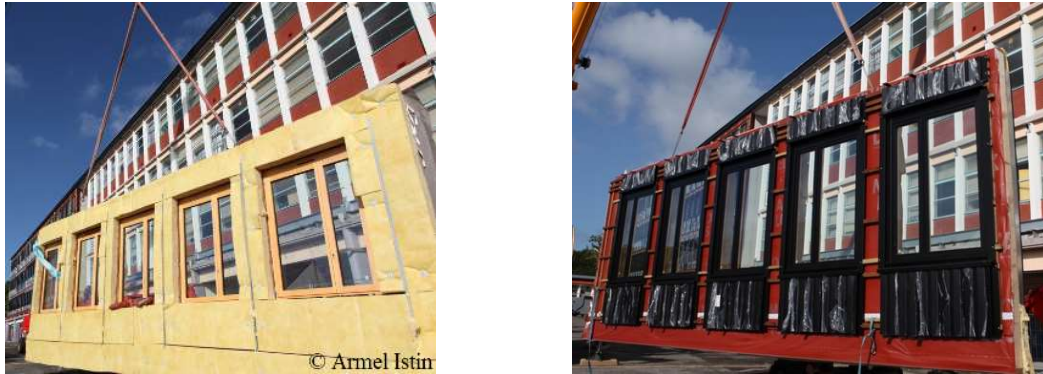
Figure IV-2 : Vues des faces intérieures et extérieures des panneaux préfabriqués.
