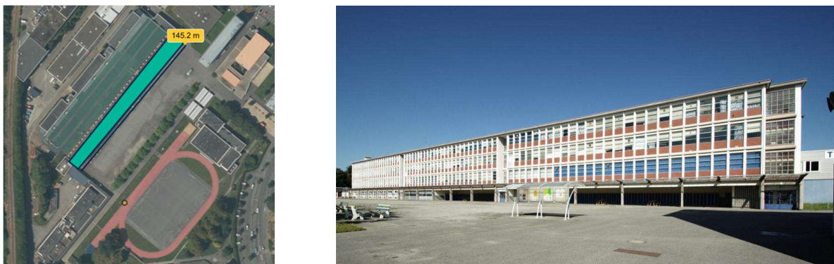
Figure IV-1 : Vue aérienne du bâtiment et vue de l'enveloppe avant réhabilitation.
