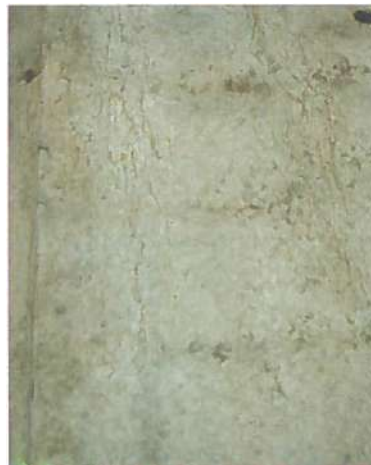
FIGURE C.2 – Phénomène de ressuage ( Geoffray, 1991 )
