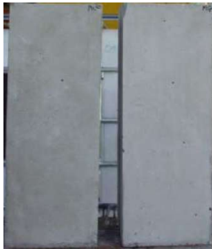
FIGURE I.14 – Influence du type de l’huile de coffrage sur la couleur de la surface du béton à partir d’un coffrage métallique : émulsion (gauche) et cire minérale (droite) (Lallement, 2001)
