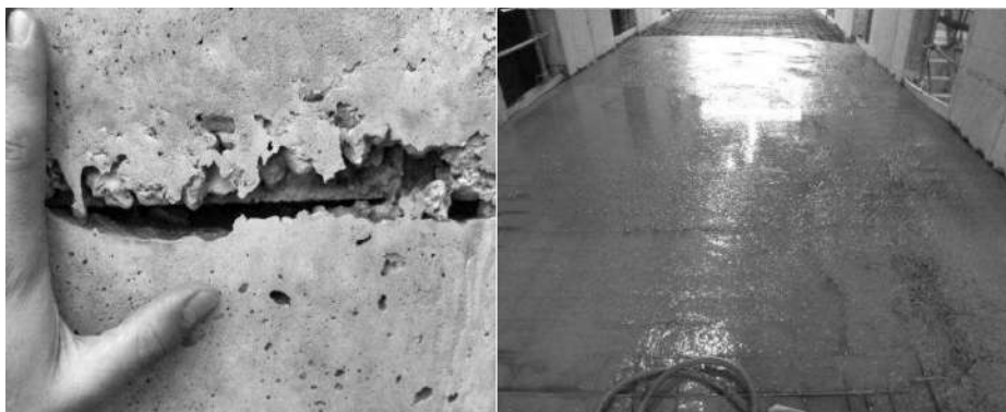
FIGURE I.17 – Exemples d'une sous-vibration (gauche) et sur-vibration (droite)
