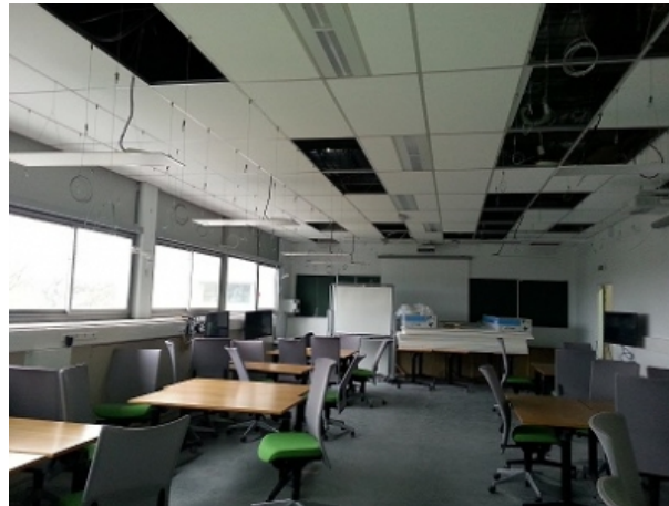
FIGURE 1 – Photographie d'une salle d'enseignement de l'Université Paul Sabatier équipée de capteurs.
