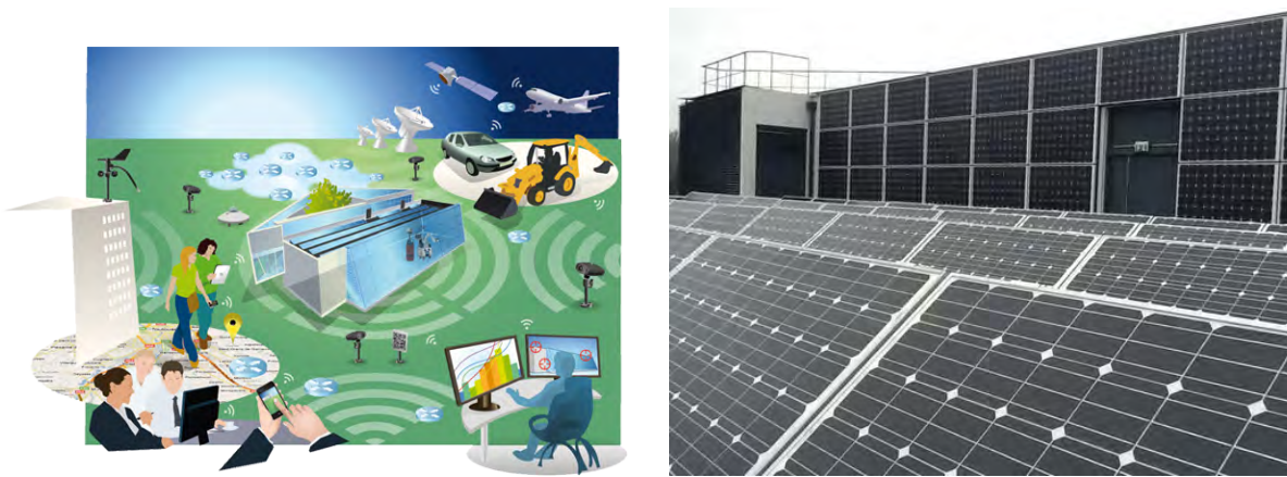
FIGURE 1.2 – Illustrations et panneaux solaires du bâtiment ADREAM
