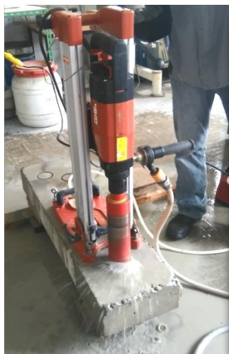
Figure 4.8 : Carottage sous eau du corps d'épreuve D3
