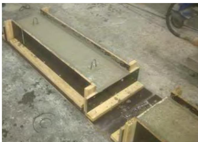
Figure 4.2: Coulage des corps d'épreuves D2 et D3
