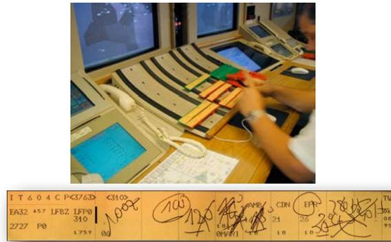
Figure 129: une position de contrôle aérien en France, basée sur une image radar et un tableau de strips papier
