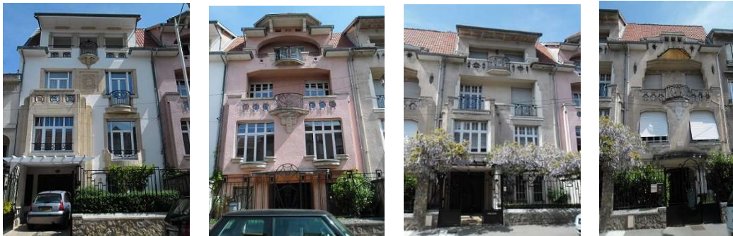
Fig. 145 : Ensemble des 4 villas dans la rue du Lieutenant Henri Crépin (n os 9-11-11bis-15)
