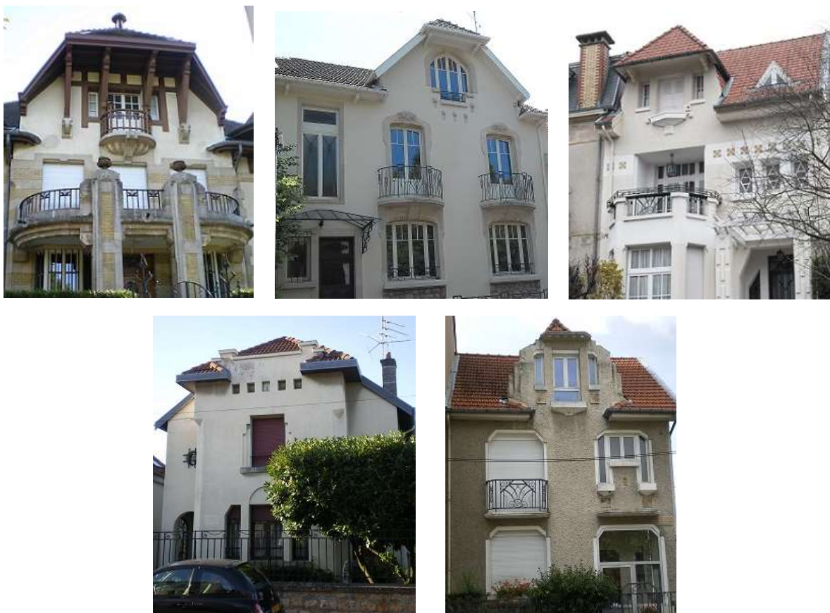
Fig. 70 : Les toitures à demi-croupes chez Masson
