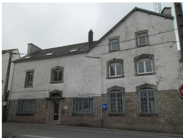
Entreprise de construction Groleau 7, rue Bernus à Vannes
