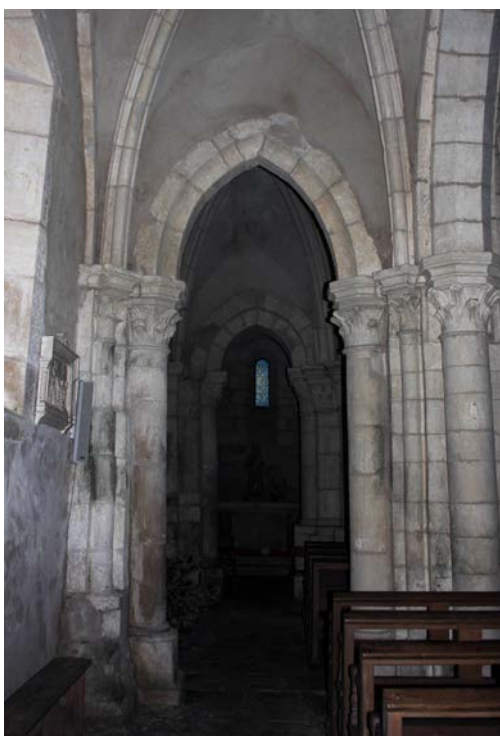
Fig. 36 – Pilastre élancé, église d'Allamps, 54 (cliché Marion Subts).
