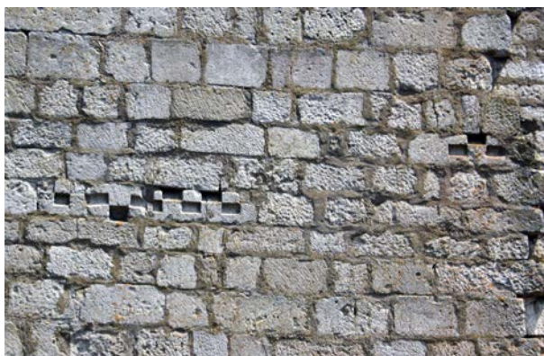
Fig. 41 – Fragments de corniche décorée de billettes romanes en remploi dans la reprise du clocher de Barisey-la-Côte, 54 (cliché Marion Subts).
