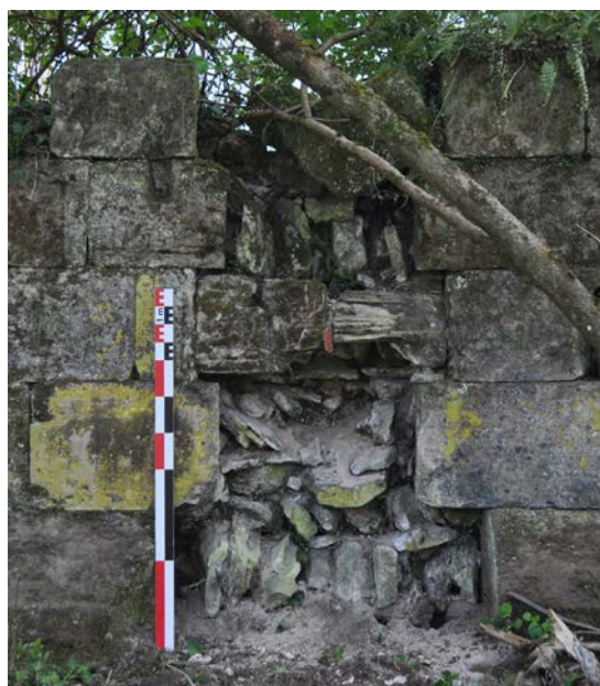
Fig. 53 – Blocage en épi dans le mur gouttereau nord de l'abbatiale de Haute-Seille, 54 (cliché Cédric Moulis).
