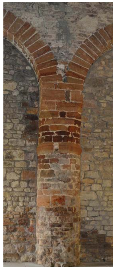
Fig. 28 – Pilier circulaire appareillé de moellons, nef du prieuré de Bleurville, 88 (cliché Cédric Moulis).
