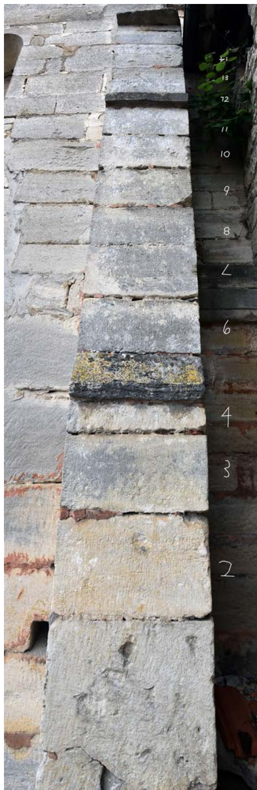
Fig. 4 – Signes lapidaires en chiffres arabes sur un contrefort de l'église de Méné-sur-Saulx, 55 (cliché Cédric Moulis).
