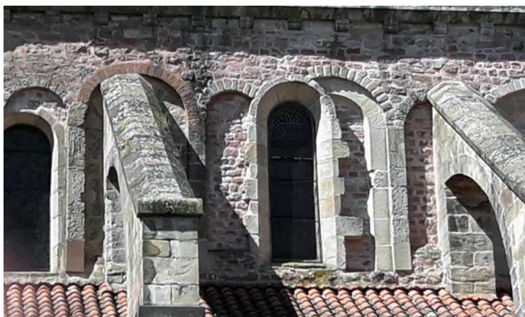
Fig. 16 – Derrière les fenêtres en plein cintre du XII e siècle, la nef de la basilique Saint-Maurice d'Épinal (88) conserve en palimpseste la trace des fenêtres primitives du XI e siècle en plein cintre, ainsi que leur décor d'arcs aveugles extradossés (cliché Cédric Moulis).
