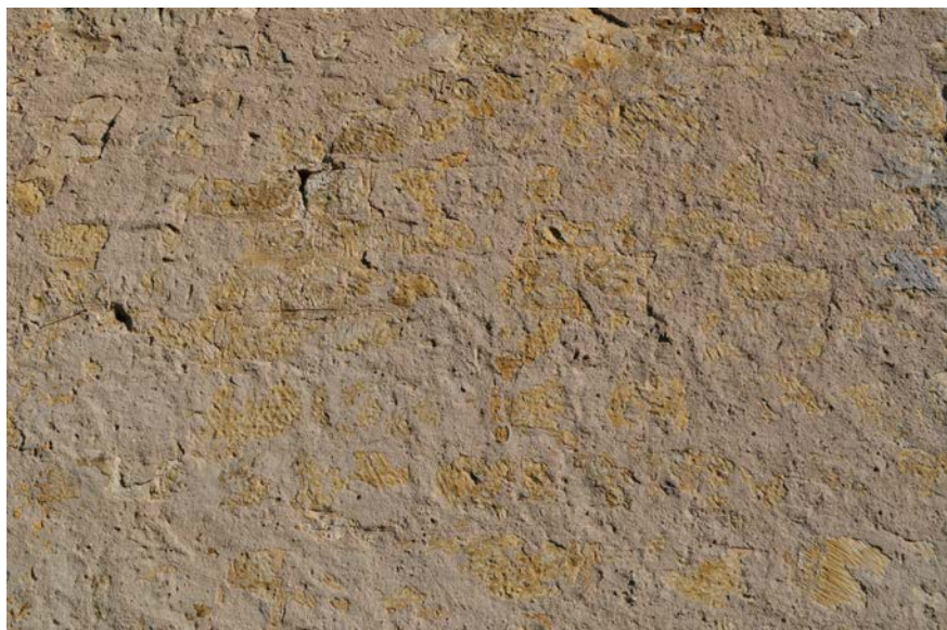
Fig. 21 – Enduit moderne granuleux posé sur l'enduit de faux joints primitif de l'église de Vandelévillle, 54 (cliché Cédric Moulis).
