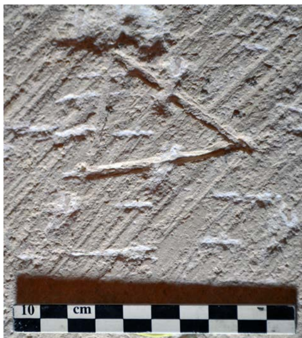
Fig. 41 – Signe lapidaire triangulaire dans le chœur prieuré de Blanzey, 54 (cliché Cédric Moulis).
