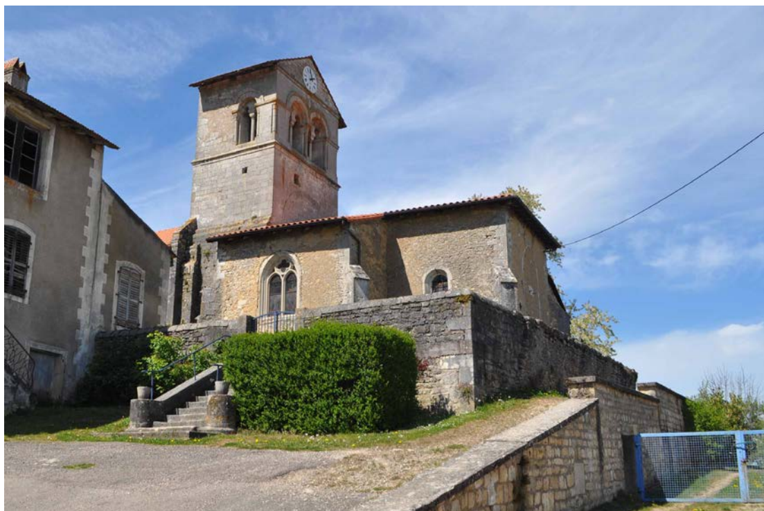
Fig. 11 – L'église de Battigny (54, XII e siècle), bâtie perpendiculairement à la pente de son coteau, a nécessité de gros travaux de terrassement (cliché Cédric Moulis).
