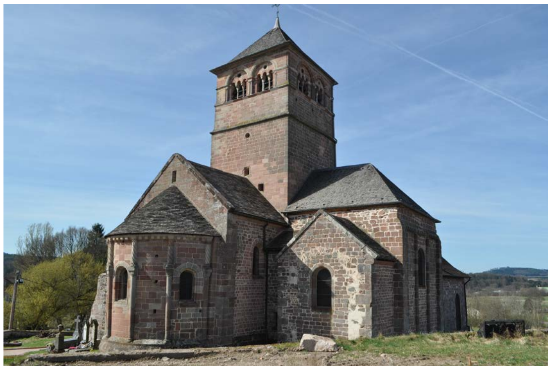
Fig. 2 – Volumes géométriques de la partie orientale de l'église de Champ-le-Duc, 88 (cliché Cédric Moulis).
