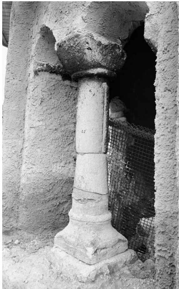
Fig. 13 – La colonnette centrale des ouvertures de la tour de la commanderie de Nancy (54) s'encastre dans le chapiteau en Tau qui a un logement prévu à cet effet (cliché A. George – SRI, n°96 54 7967 X).
