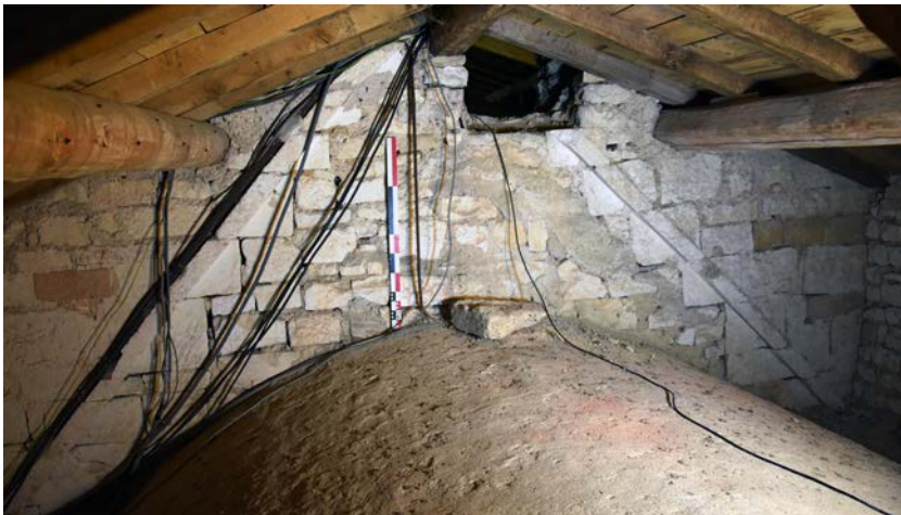
Fig. 16 – Vue générale du solin roman du chœur de l'église d'Allamps (cliché Cédric Moulis).
