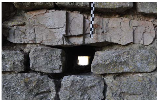
Fig. 11 – Gaine de boulin traversante, tour seigneuriale de Darnieulles, 88 (cliché Cédric Moulis).
