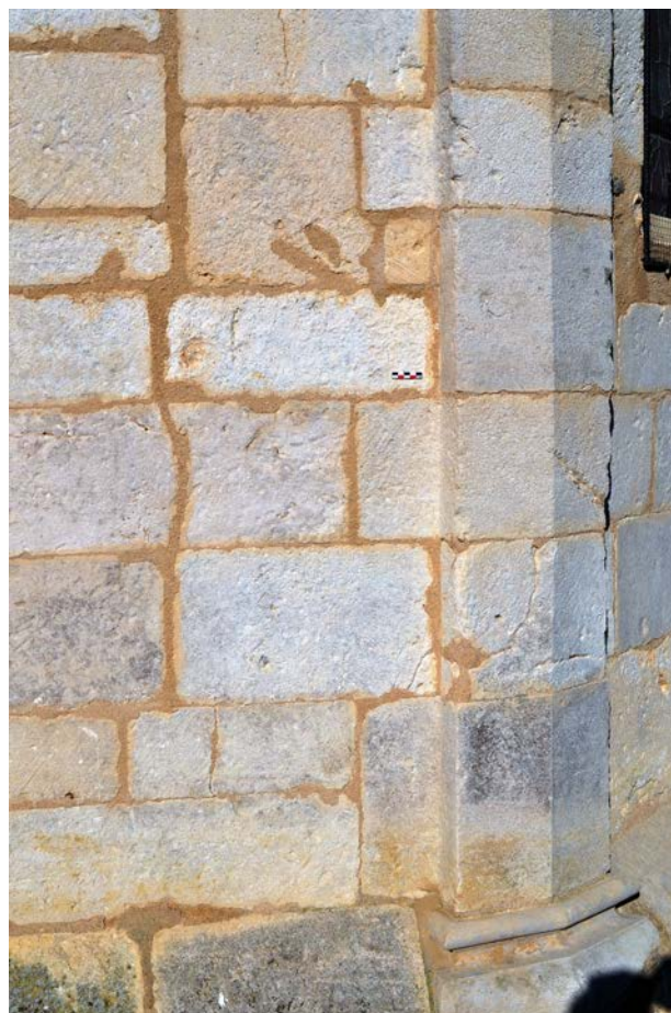
Fig. 24 – Chainage harpé sur le chevet pentagonal de Forcelles-Saint-Gorgon, 54 (cliché Cédric Moulis).
