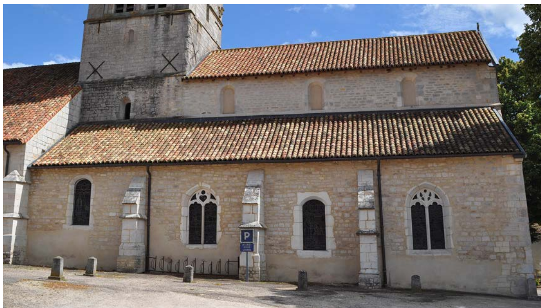
Fig. 1 – Les bas-côtés et les murs gouttereaux des vaisseaux de l'église de Coussey (88) sont réalisés en moellons calcaires équarris (cliché Cédric Moulis).
