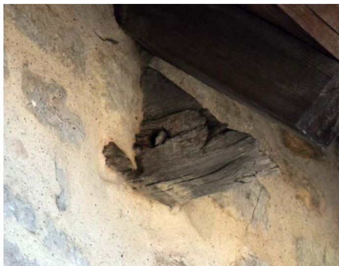
Fig. 3 – Entrail en assemblage à mi-bois de l'église de Coussey. On devine le trou de la cheville (cliché Cédric Moulis).
