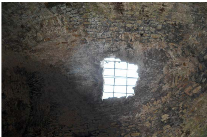
Fig. 5 – Voûte couvrant la salle basse du donjon de Prény, 54 (cliché Cédric Moulis).
