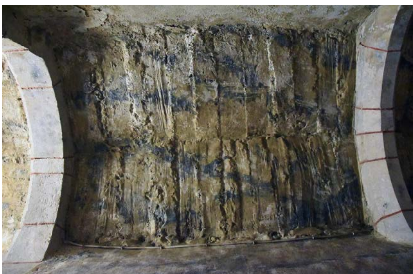
Fig. 39 – Voûte en bâtière, couloir d'accès à la crypte de Dieulouard, 54 (cliché Cédric Moulis).
