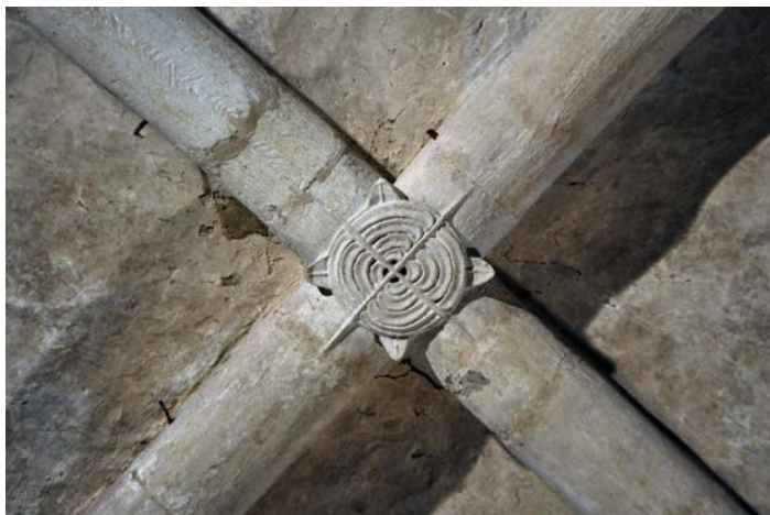
Fig. 43 – On remarque les quatre petits tronçons de nervure qui viennent assurer la liaison avec la clef de voûte, crypte de Blanzey, 54 (cliché Cédric Moulis).
