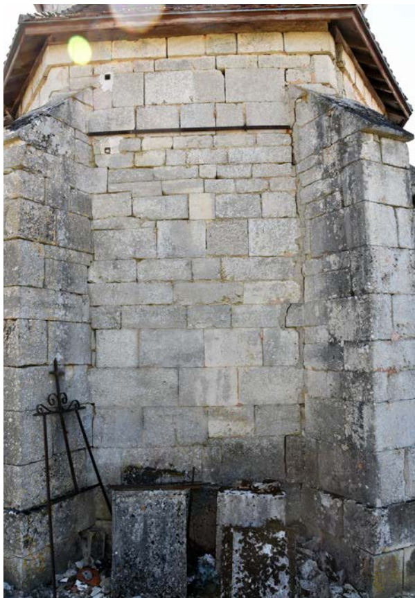
Fig. 28 – Le chaînage de ce pan du chevet de Saudron (52) reprend les différents types de liaisons possibles (cliché Cédric Moulis).
