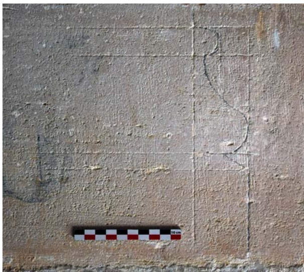
Fig. 33 – Profil de moulure gravé sur une partie tardive de l'église d'Échenay, 52 (cliché Cédric Moulis).
