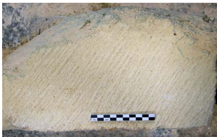
Fig. 37 – Layage obtenu avec un marteau taillant droit (cliché Vianney Muller).
