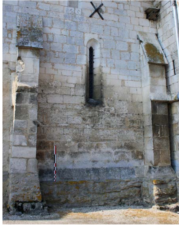
Fig. 17 – Fondation hors sol sur une travée du mur gouttereau sud de l'église de Sepvigny, 55 (cliché Marion Subts).
