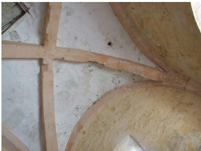
Fig. 12 – Croisée d'ogives à nervures carrées, tour-porche de l'église de Remoncourt, 88 (cliché Cédric Moulis).
