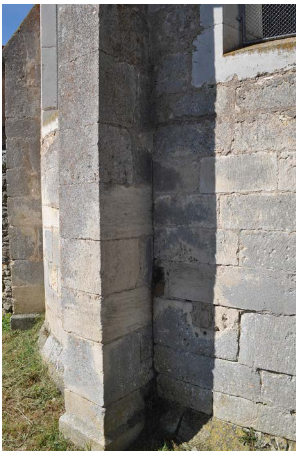
Fig. 27 – Les pierres de ce contrefort du chevet de Puxe-Laloeuf (54) pénètrent en boutisse dans la maçonnerie, sans chaînage (cliché Cédric Moulis).
