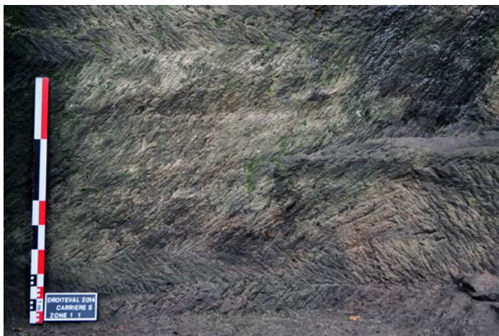
Fig. 11 – Droiteval, traces de broche sur la paroi de la carrière 1.1 au nord de l'autel (cliché Marie Nique).
