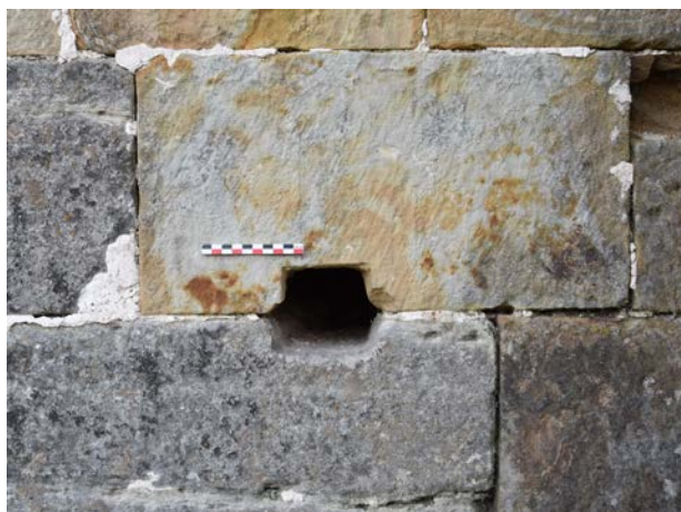
Fig. 9 – Trou de boulin dichotomique d'arête, chevet pentagonal de la chapelle de Xugney, 88 (cliché Cédric Moulis).
