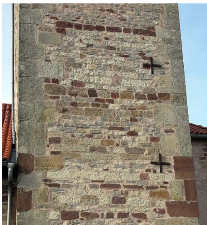
Fig. 13 – Résonnances multiples entre les chaînes d'angles et les assises de parement sur le clocher de Gelvécourt-et-Adompt, 88 (cliché Cédric Moulis).
