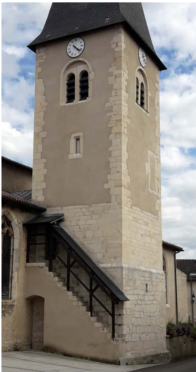
Fig. 19 – Résonance 1:1 à la base, puis plus complexe, entre chaîne d'angle en pierre de taille et parement de moellons (recouvert par un enduit), église de Vandières, 54 (cliché Cédric Moulis).
