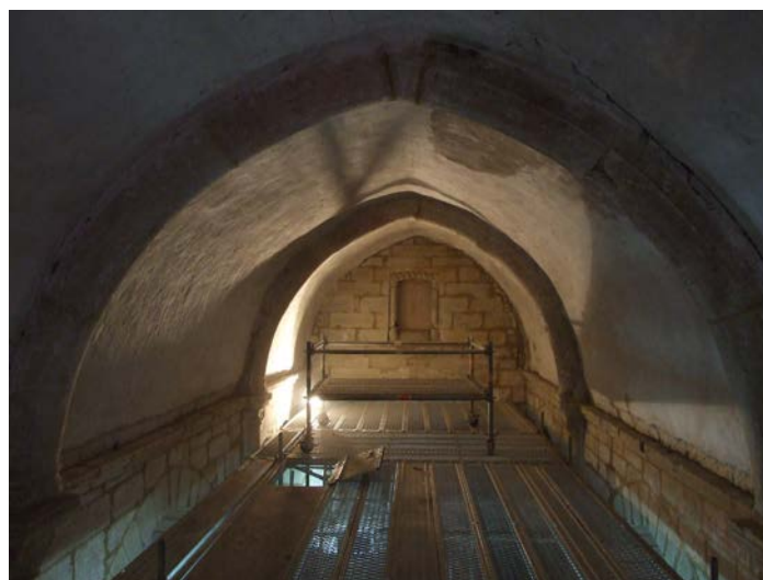
Fig. 1 – Voûte en berceau brisé, chœur de l'église d'Isches, 88 (cliché Cédric Moulis).
