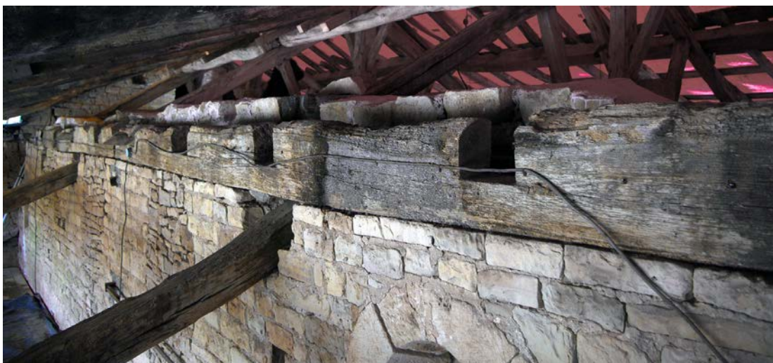
Fig. 8 – Sablière sur le mur gouttereau nord de l'église de Vomécourt-sur-Madon (cliché Cédric Moulis).
