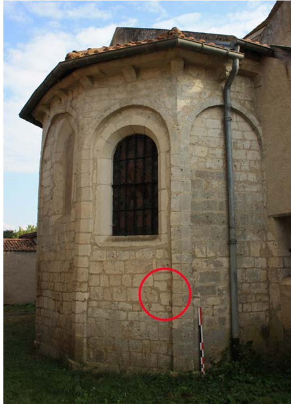
Fig. 26 – Le rythme du parement a été interrompu pour permettre aux pierres du parement et du pilastre de se lier. Chevet de Gézoncourt, 54 (cliché Marion Subtis).
