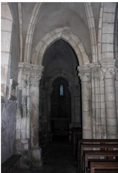
Fig. 36 – Pilastre élancé, église d'Allamps, 54 (cliché Marion Subts).
