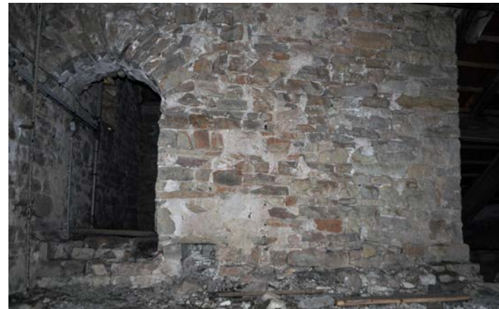
Fig. 24 – Porte à arc composé de moellons, clocher de l'église de Virecourt, 54 (cliché Cédric Moulis).
