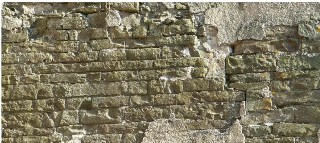
Fig. 33 – Parement de moellons équarris, clocher de l'église de Bouzémont, 88 (cliché Cédric Moulis).
