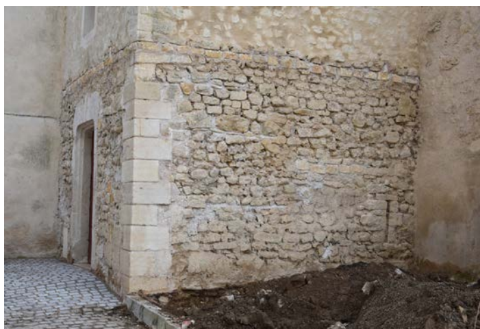
Fig. 12 – Appareillage de moellons grossiers sur le clocher d'Essey-lès-Nancy, 54 (cliché Ellia Martin).
