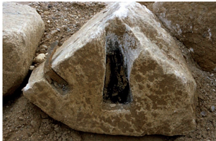
Fig. 8 – Queue d'aronde en bois partiellement retrouvée dans son logement (au centre), pont de Dieulouard, 54 (cliché Jean-Pierre Legendre - SRA).
