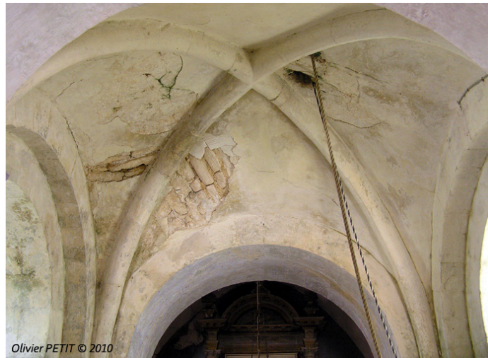
Fig. 45 – Moellons équarris composant les voûtains d'une croisée d'ogives torique, dissimulés sous l'enduit, église de Malaumont, 55 (cliché Olivier Petit - http://patrimoine-de-lorraine.blogspot.com/2010/12/malaumont-55-leglise-paroissiale-saint.html ).
