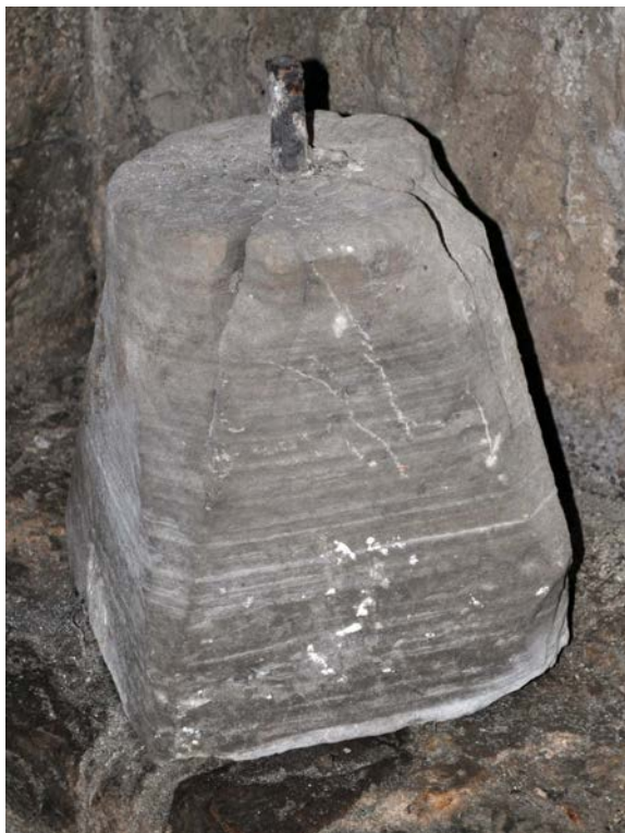
Fig. 10 – Chapiteau (ici à l'envers) présentant une fixation à son pilier par un goujon métallique (cliché Cédric Moulis).
