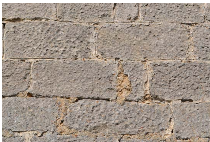
Fig. 17 – Décor de joints fins tirés au fer sur un parement de pierres de taille, église de Battigny, 54 (cliché Cédric Moulis).
