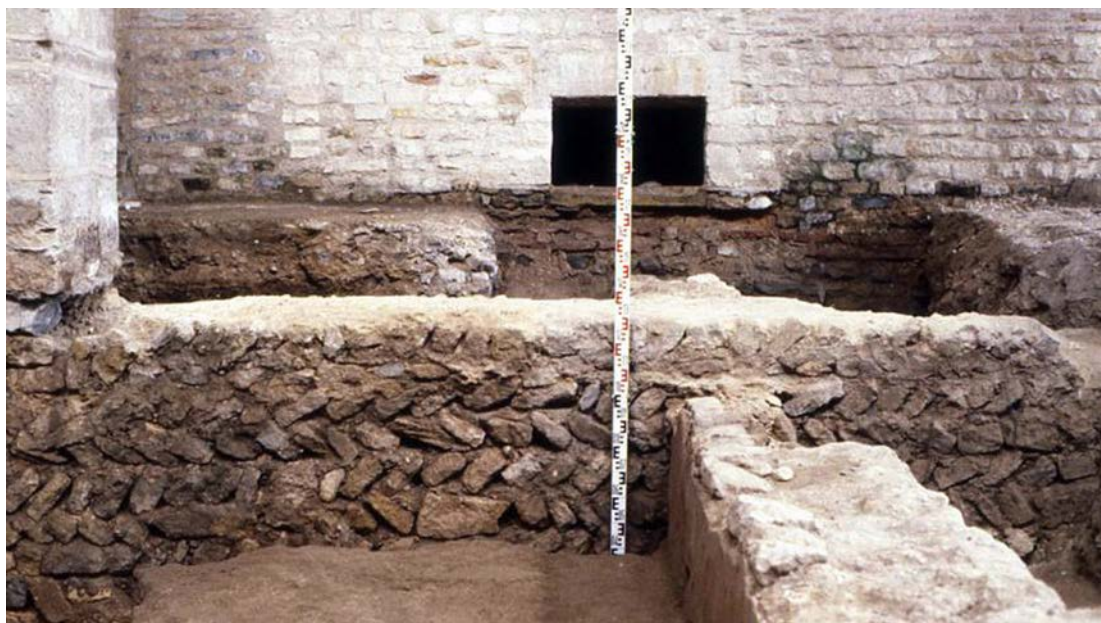
Fig. 47 – Fondations de pierres disposées en épi à Saint-Pierre-aux-Nonnains de Metz, 57 (cliché François Heber-Suffrin).
