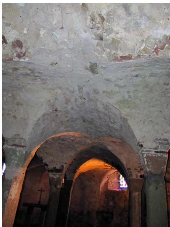
Fig. 6 – Voûte d'arête dans la crypte du prieuré de Bleurville, 88 (cliché Cédric Moulis).
