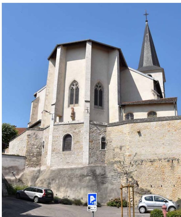
Fig. 12 – L'emplacement choisi pour l'église de Dieulouard (54, XII e -XVI e siècle) a permis la construction d'une crypte romane pour compenser la dénivellation du terrain (cliché Cédric Moulis).
