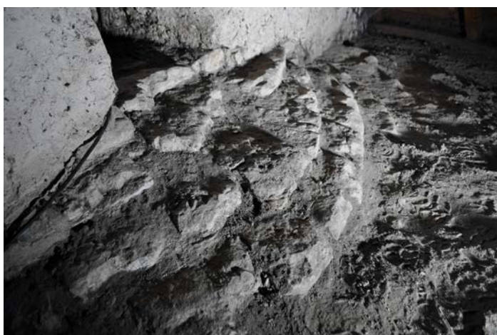
Fig. 49 – Extrados de la voûte en cul-de-four de l'abside de l'église de Flin, 54 (cliché Cédric Moulis).
