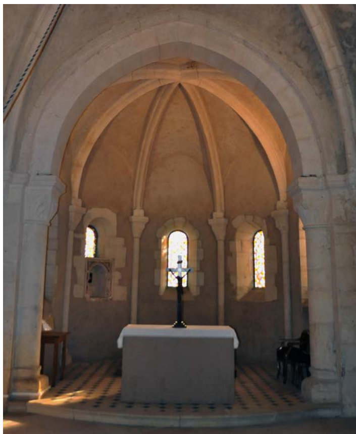
Fig. 4 – Voûte à pans coupés nervurés, chœur de l'église prieurale de Blanzey, 54 (cliché Cédric Moulis).
