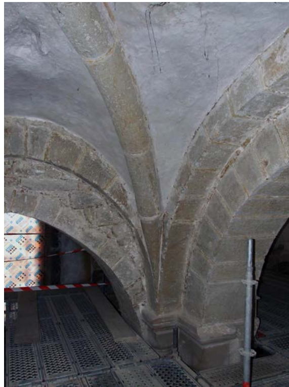
Fig. 32 – Croisée torique se terminant en sifflet, église d'Isches, 88 (cliché Cédric Moulis).
