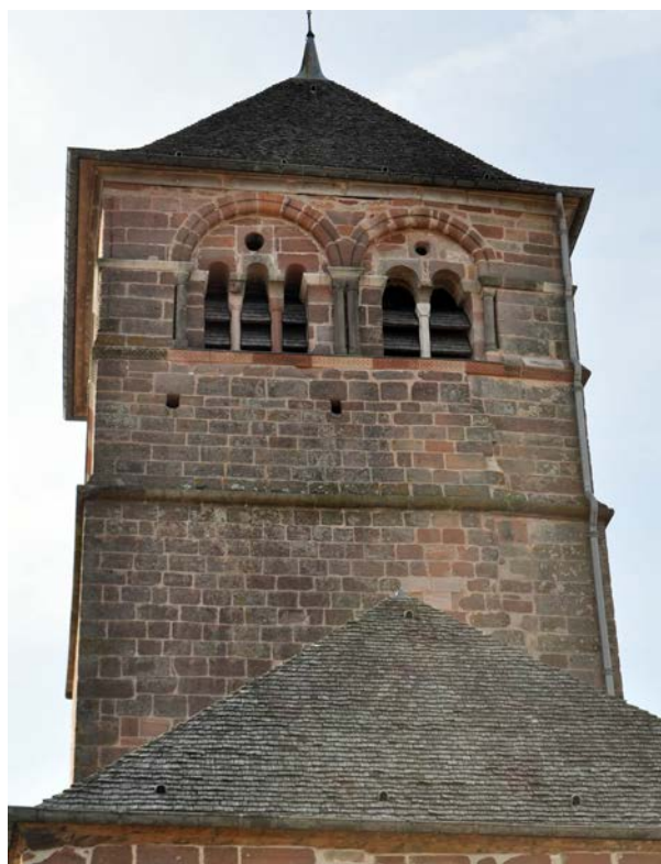
Fig. 29 – Parement de carreaux, clocher de Champ-le-duc, 88 (cliché Cédric Moulis).
