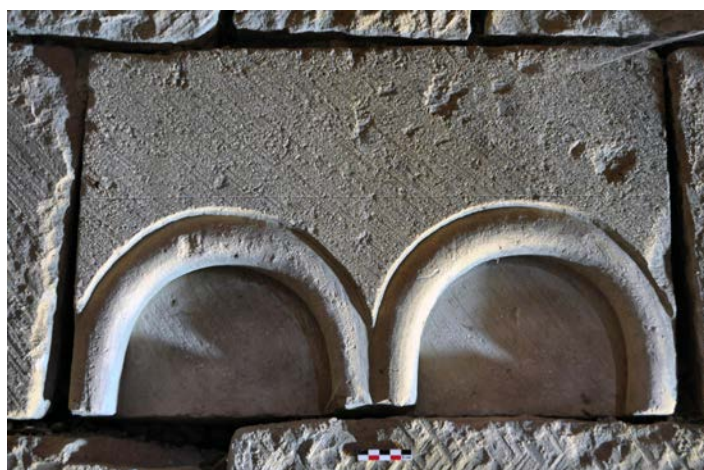
Fig. 29 – Trait préparatoire sur un élément de fenêtre en remploi, mur ouest du clocher de Champougny, 55 (cliché Cédric Moulis).
