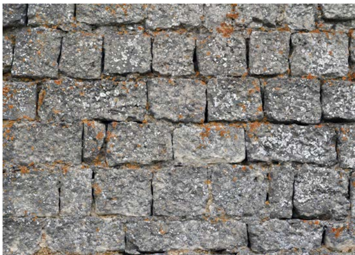
Fig. 15 – Appareillage de pierres de taille calcaires dégrossies au pic, sans taille de finition, sur le mur gouttereau nord de l'église de Battigny, 54 (cliché Cédric Moulis).
