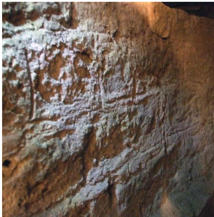
Fig. 20 – Décor de joints tirés au fer larges, base intérieure de l'abside primitive de l'église de Custines, 54 (cliché Cédric Moulis).
