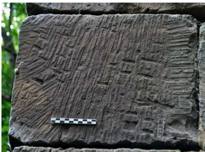
Fig. 23 – Layage à traces larges sur le château de Romont, 88 (cliché Cédric Moulis).
