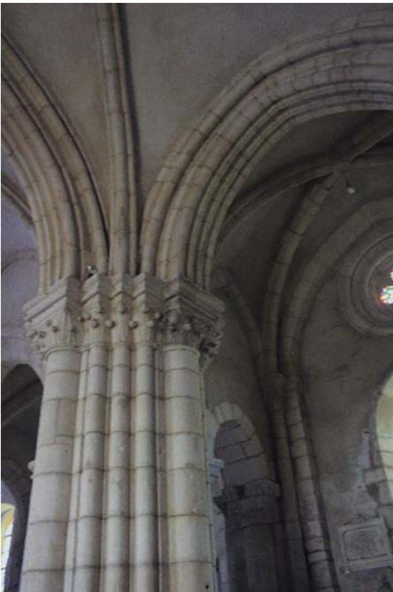
Fig. 31 – Piliers à colonnes engagées composés de tambours, église d'Allamps, 54 (cliché Marion Subts).
