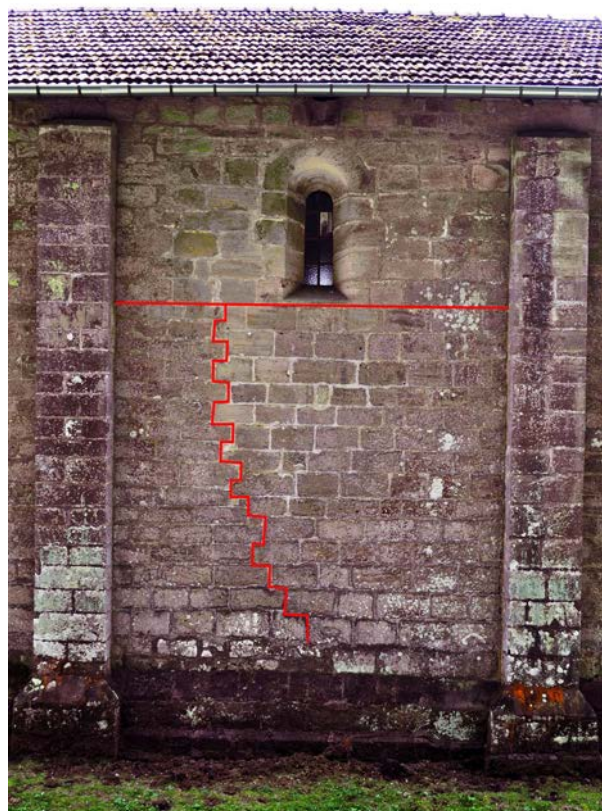
Fig. 42 – Couture sur la troisième travée nord de l'abbatiale de Droiteval, 88 (cliché Cédric Moulis).
