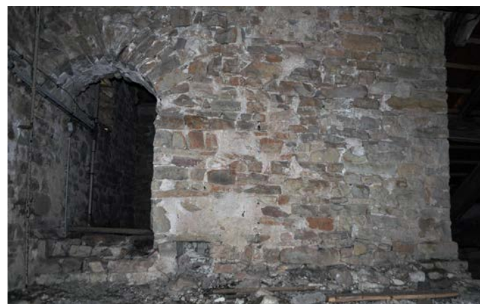
Fig. 24 – Porte à arc composé de moellons, clocher de l'église de Virecourt, 54 (cliché Cédric Moulis).
