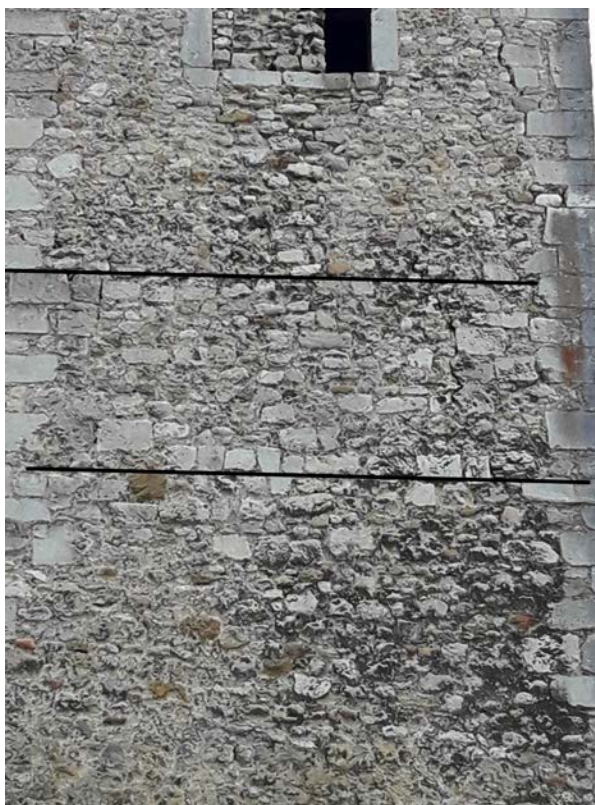
Fig. 39 – Assises de réglage dans le parement en moellons grossiers du clocher de Pagny-sur-Moselle, 54 (cliché Cédric Moulis).
