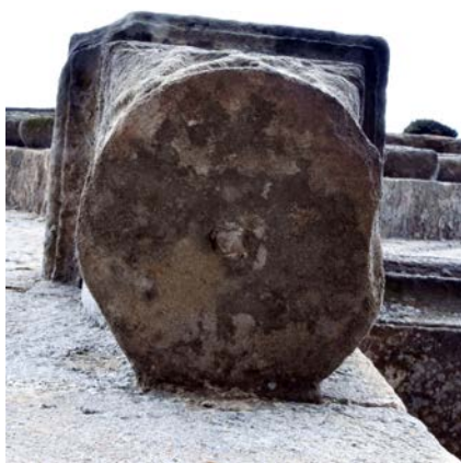
Fig. 12 – Ici, le plomb est encore partiellement présent, abbaye de Haute-Seille, 54 (cliché Cédric Moulis).
