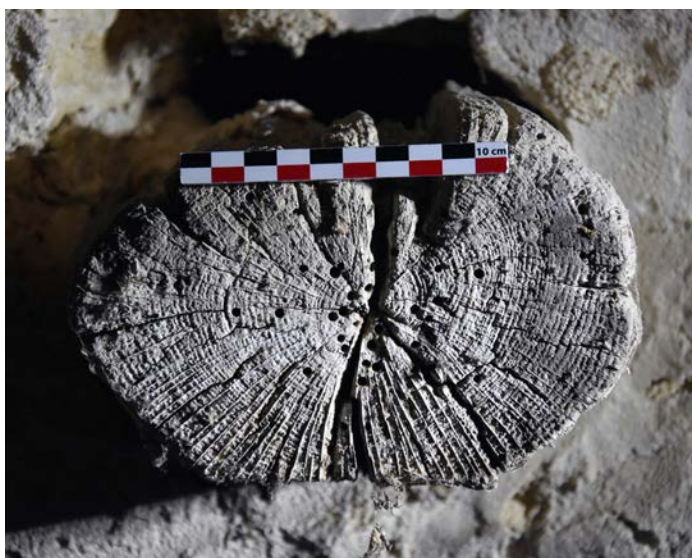
Fig. 6 – Section du fragment d'entrail de l'église d'Allamps vu depuis les combles (cliché Cédric Moulis).
