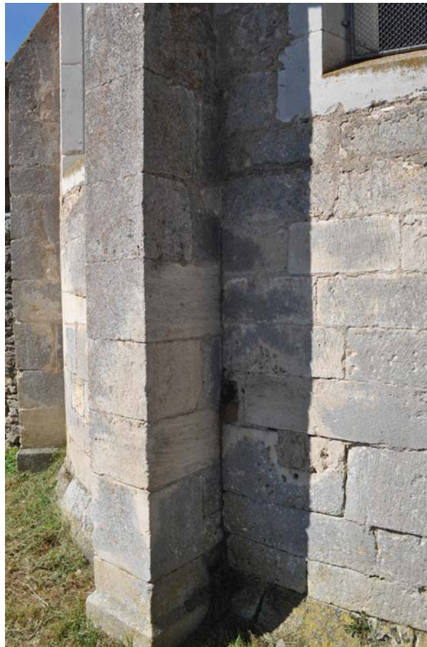
Fig. 27 – Les pierres de ce contrefort du chevet de Puxe-Laloeuf (54) pénètrent en boutisse dans la maçonnerie, sans chaînage (cliché Cédric Moulis).
