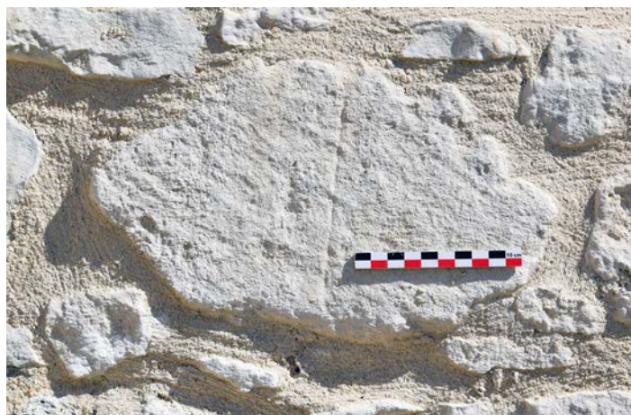
Fig. 30 – Trait sur le lit d'attente ou de pose d'un trumeau en remploi dans l'église de d'Échenay, 52 (cliché Cédric Moulis).
