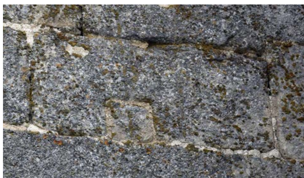
Fig. 21 – Trou de boudin façonné d'arête, bouché correctement dès la fin de son utilisation, église de Nançois-le-Grand, 55 (cliché Cédric Moulis).
