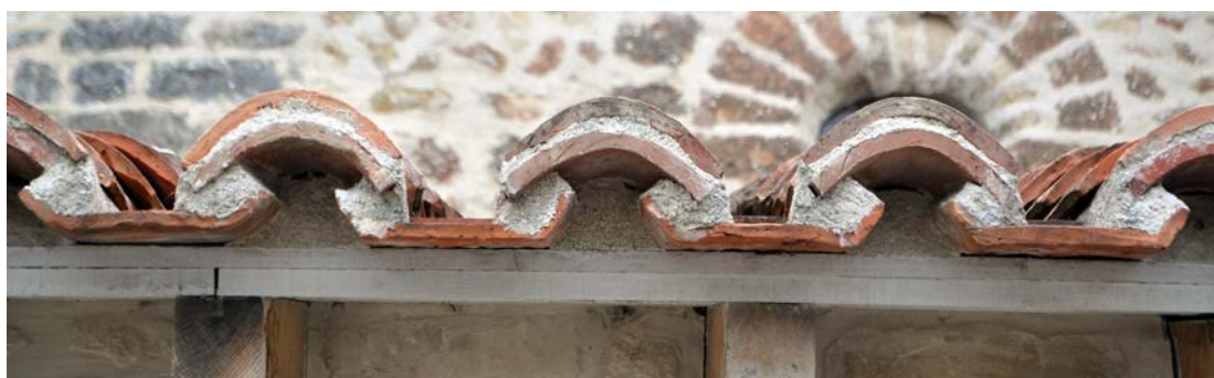
Fig. 27 – Tuiles basées sur des modèles anciens retrouvés dans l'église de Moëslains, 52 (cliché Cédric Moulis).
