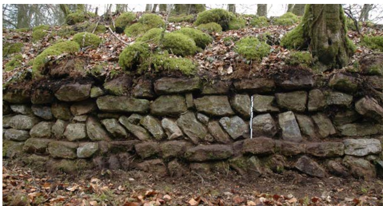
Fig. 50 – Dispositif en épi sur le parement du mur d'enceinte des Tours Séchelles, 88 (cliché Cédric Moulis).
