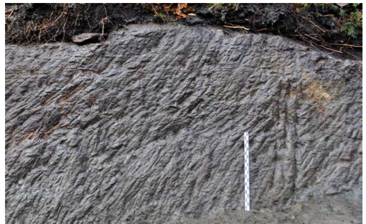
Fig. 18 – Droiteval, carrière 2.3., traces de pic verticales trahissant l'emplacement d'une encoignure (cliché Cédric Moulis).
