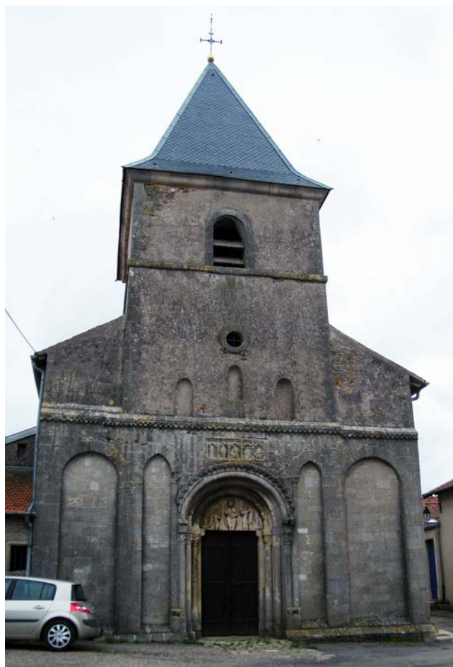
Fig. 8 – La tour-porche de Laitre-sous-Amance, 54 (cliché SRI).
