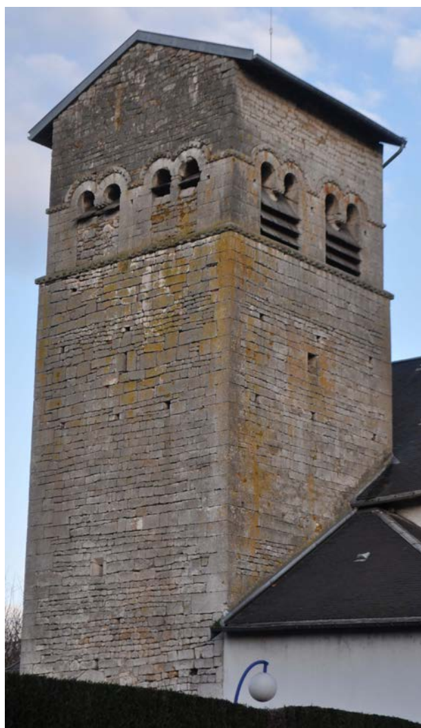
Fig. 15 – Alignement horizontal et vertical des trous de boulins, clocher de Blénod-lès-Pont-à-Mousson, 54 (cliché Cédric Moulis).
