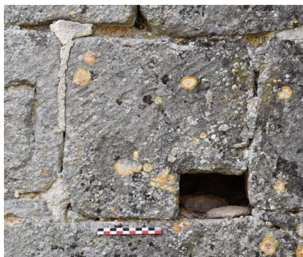
Fig. 5 – Trou de boulin façonné d'angle, église d'Ozières, 52 (cliché Cédric Moulis).
