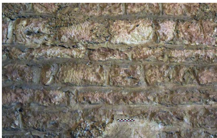
Fig. 18 – Décor de joints tirés au fer larges, comble de la nef de l'église de Coussey, 88 (cliché Cédric Moulis).
