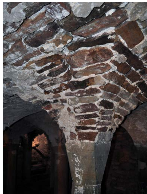
Fig. 46 – Structure des voûtes d'arêtes de la crypte de Bleurville, 88 (cliché Cédric Moulis).
