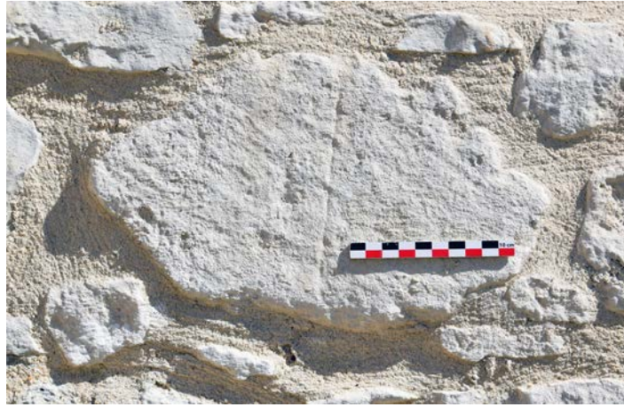
Fig. 30 – Trait sur le lit d'attente ou de pose d'un trumeau en remploi dans l'église de d'Échenay, 52 (cliché Cédric Moulis).
