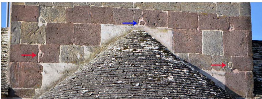
Fig. 8 – Trous de boulin façonné sur arête verticale (flèches rouges), et un trou façonné dichotomique d'angle (flèche bleue), clocher de l'église de Gorhey, 88 (cliché Cédric Moulis).
