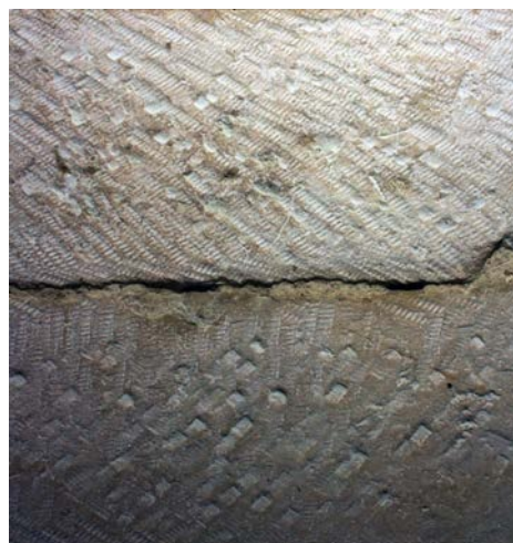
Fig. 28 – Traces de ciseau se mêlant à de la bretture sur l'église de Sepvigny, 55 (cliché Marion Subts).
