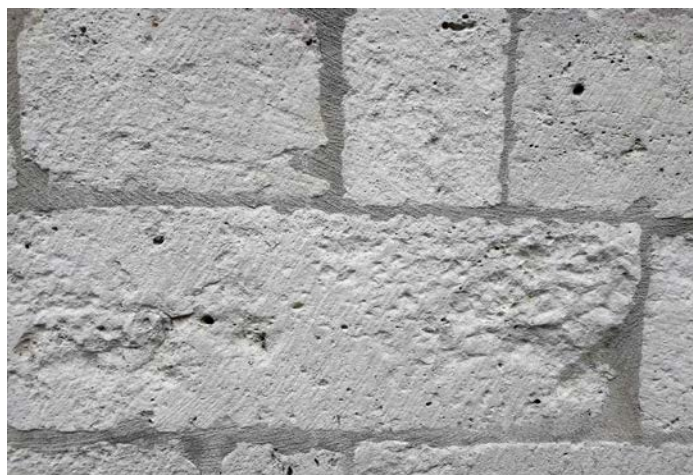
Fig. 16 – L'angle supérieur droit de cette pierre de parement sur l'église de Vandières (54) a été descendu au-delà du niveau de la taille de finition, si bien que les traces de layage obliques ne recouvrent pas celles du dégrossissage au pic (cliché Cédric Moulis).
