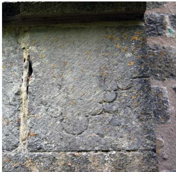
Fig. 32 – Tracé à la pointe sèche du plan des piliers engages des collatéraux de l'église d'Écrowes, gravé sur un contrefort du mur nord, 54 (cliché Marion Subts).
