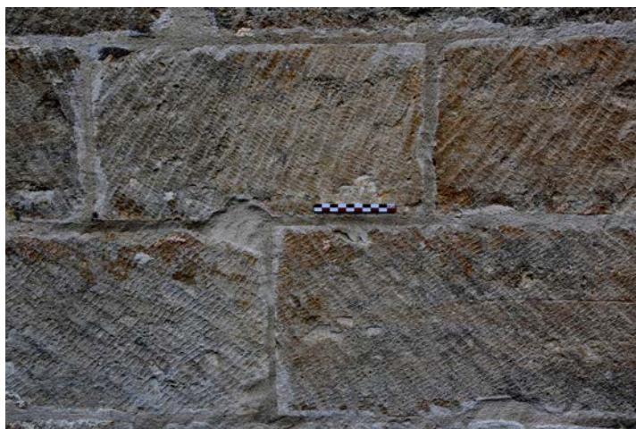
Fig. 25 – Deux traces de brettage différentes sont lisibles sur l'église de Sully, 52 (cliché Cédric Moulis).
