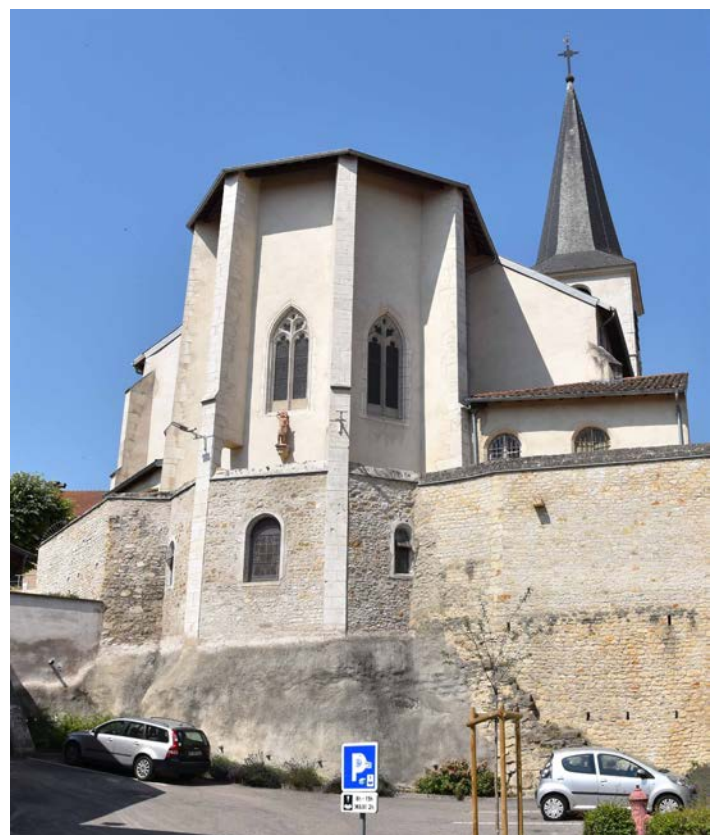
Fig. 12 – L'emplacement choisi pour l'église de Dieulouard (54, XII e -XVI e siècle) a permis la construction d'une crypte romane pour compenser la dénivellation du terrain (cliché Cédric Moulis).
