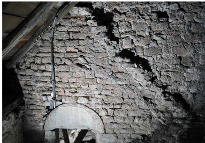
Fig. 17 – Solin en moellon de la nef de l'église de Flin, 54 (cliché Cédric Moulis).
