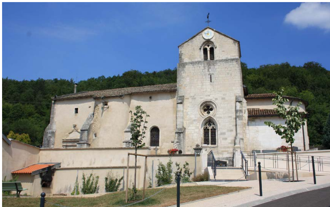
Fig. 8 – Le clocher de l'église d'Allamps (54, XII e siècle) est placé sur le bras sud du transept afin de contreventer le bâtiment dans la pente (cliché Marion Subts).
