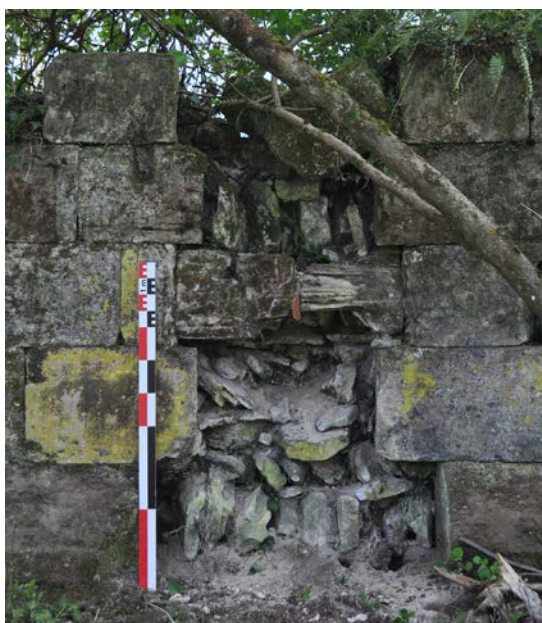
Fig. 53 – Blocage en épi dans le mur gouttereau nord de l'abbatiale de Haute-Seille, 54 (cliché Cédric Moulis).
