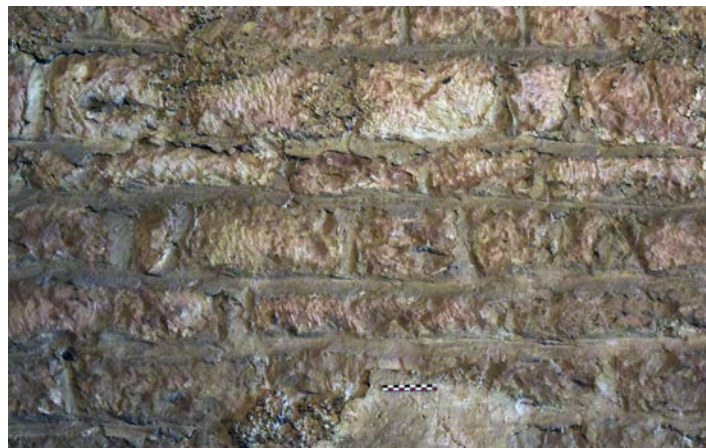
Fig. 18 – Décor de joints tirés au fer larges, comble de la nef de l'église de Coussey, 88 (cliché Cédric Moulis).
