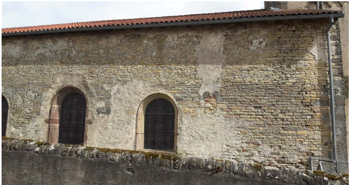
Fig. 13 – Appareillage de moellons équarris et dégrossis sur la nef de l'église de Bouzémont, 88. On remarque la présence de trois baies romanes bouchées (cliché Cédric Moulis).
