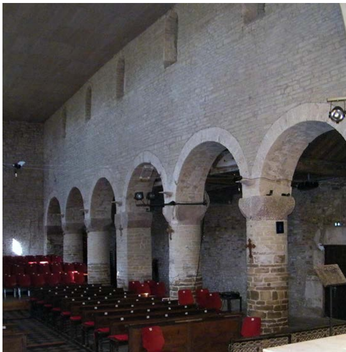
Fig. 29 – Alternance 2:1 de piliers circulaires et carrés, église de Froville, 54 (cliché Anne Chrétien - SRI).
