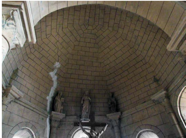
Fig. 3 – Voûte en cul-de-four coupée en pans, chœur de l'église de Vicherey, 88 (cliché Cédric Moulis).
