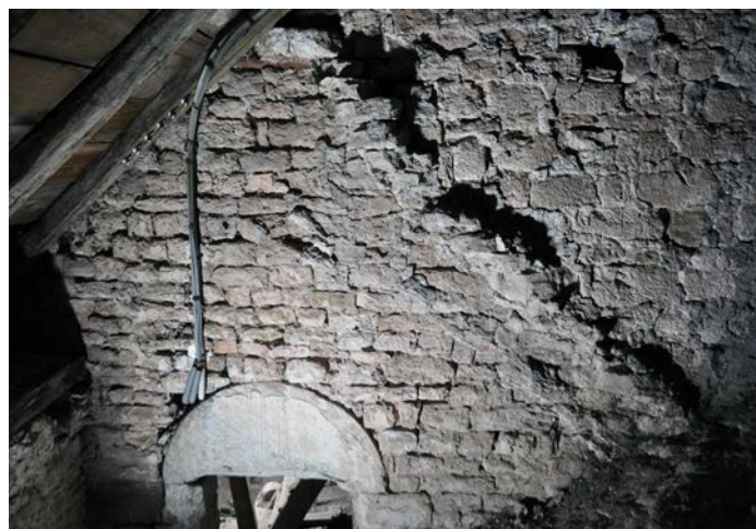
Fig. 17 – Solin en moellon de la nef de l'église de Flin, 54 (cliché Cédric Moulis).
