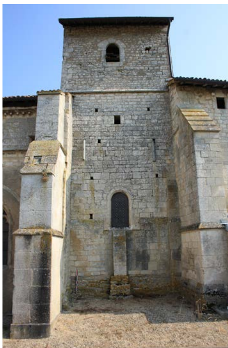
Fig. 17 – Négatif d'un échafaudage régulier, clocher de l'église paroissiale de Sepvigny, 55 (cliché Marion Subts).
