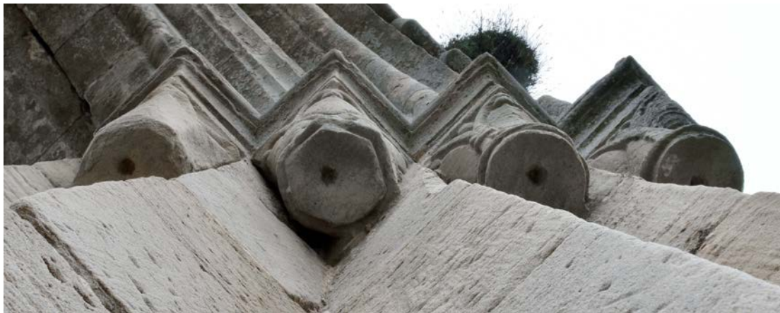
Fig. 11 – Les quatre chapiteaux à droite du portail d'entrée de l'abbatiale de Haute-Seille (54) comportent un logement pour fixer des goujons (cliché Cédric Moulis).
