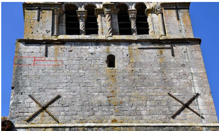
Fig. 14 – Résonnance 2:1 (en rouge) sur le clocher de Coussey, 88 (cliché Cédric Moulis).
