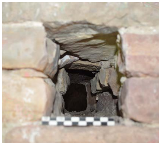
Fig. 13 – Gaine de boulin parementée, gouttereau sud de la chapelle de Xugney, 88 (cliché Cédric Moulis).
