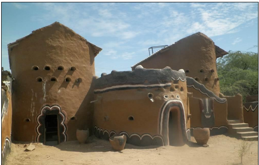
Figure 14: Grand bâtiment du musée Sao-Kotoko de Gaoui (ph. M. Makrada Maïna), 2013.
